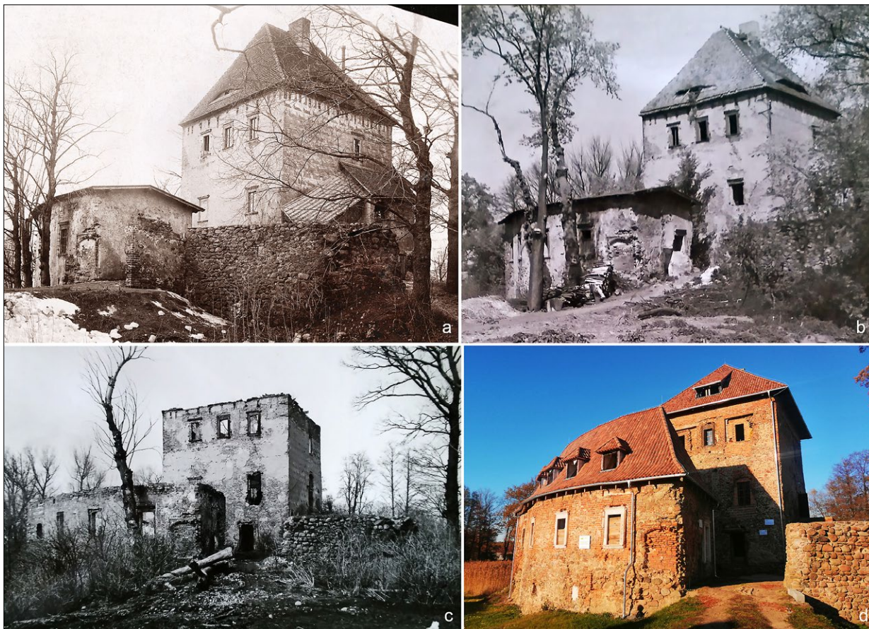
Ryc. 2. Zamek w Witkowie, widok od południowego wschodu, a – fotografia archiwalna z 1913 r. (archiwum Lubuskiego Wojewódzkiego Konserwatora Zabytków w Zielonej Górze); b – stan z 1961 r. (fot. I. Springer [Radacki 1961]); c – stan z 1973 r. (fot. K.R. Janowski [Janowski 1973]); d – stan z 2022 r. (fot. A. Michalak).
