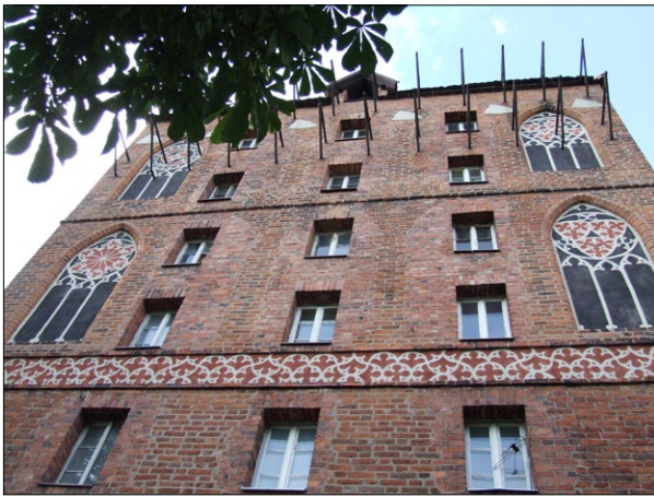
Ryc. 4. Baszta Golebnik – górny fragment elewacji południowej, 2020. Fig. 4. Golebnik Tower – the upper part of the southern facade, 2020.
