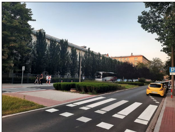
Ryc. 7. Budynek hali maszyn A1–A2 – widok od ul. Reymonta, czerwiec 2023; fot. J. Wowczak.
