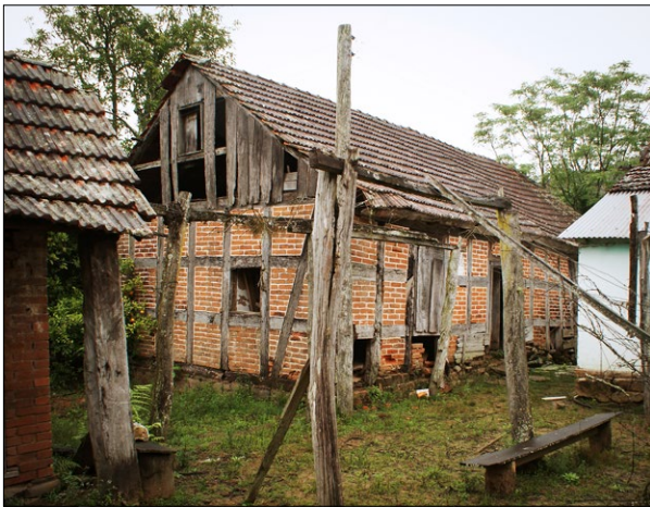
Ryc. 6. Budynek ryglowy w Linha Patrícia, gm. Paraíso do Sul (2016), wyraźnie widoczne podobieństwo do budynku w Rakowie nr 13.
