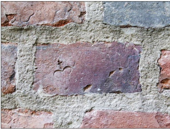
Ryc. 8. Cegła z charakterystycznym stemplem Cegielni Królewskiej znajdującej się przy Kaszowniku w Toruniu, 2020.
