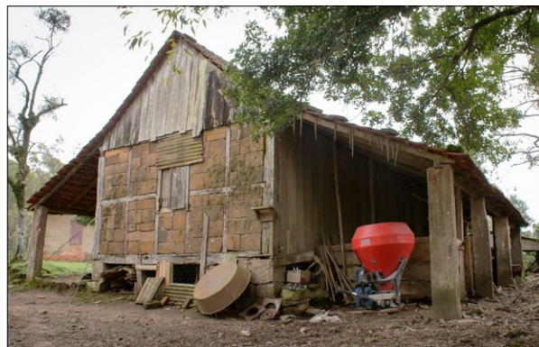
Ryc. 10. Pola drewnianej konstrukcji szkieletowej wypełnione blokami piaskowca, Linha das Pedras, gm. Agudo (2015).
