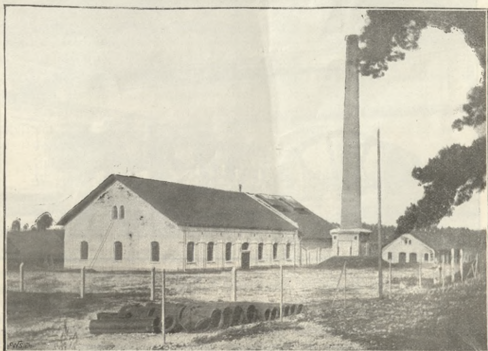
Fig. II. Hala maszyn stacji pomp w Woli dobrostańskiej.
