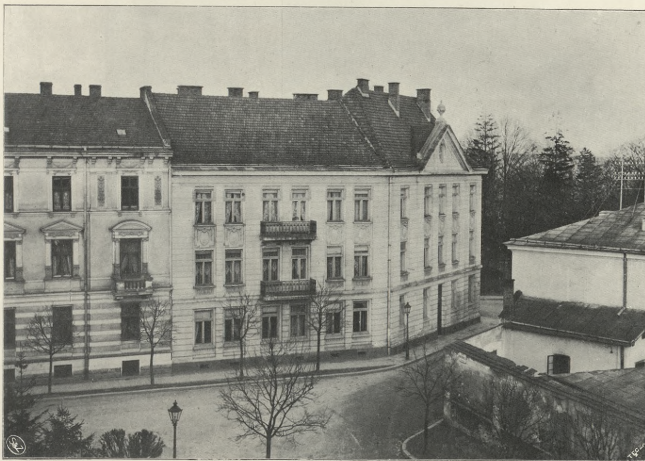
DOM PRZY ULICY UJEJSKIEGO WE LWOWIE. Firma nasza wykonała cały budynek, w żelazo-betonie wykonano stropy i schody.
