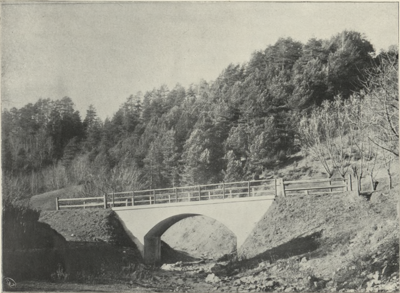
MOST NA POTOKU BERESKA W ROZPUCIU NA DRODZE PRZEMYSŁ-SANOK łuk Moniera, światło 8 m, szerokość 6 m.
