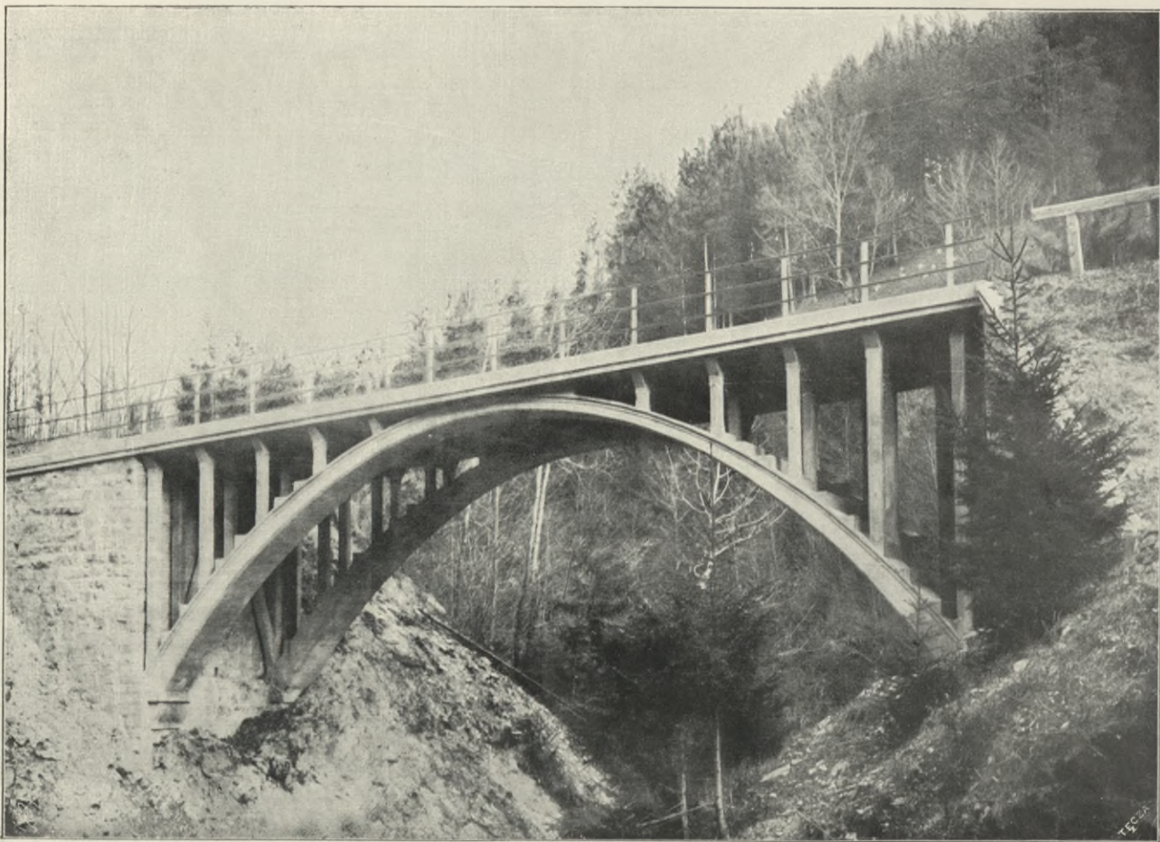
MOST W JAWOROWIE NA DRODZE KOSÓW-JASIONÓW GÓRNY belki łukowe, światło 18 m, szerokość 6 m.
