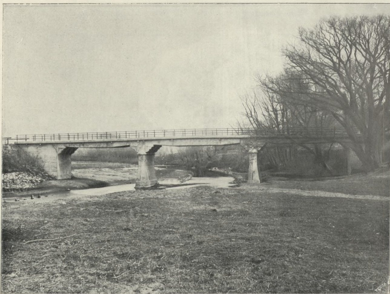
MOST NA STRWIĄŻU W CZAPLACH trzyprzęsłowy, belki proste, światło środkowe 15 m, światła skrajne po 12,50 m, szerokość 6 m.
