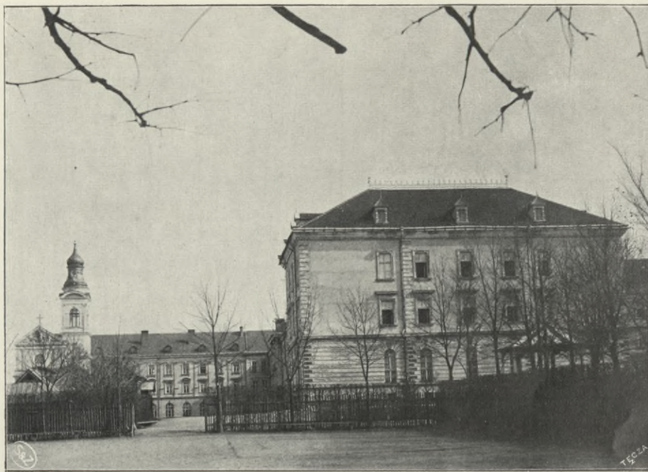
ZAKŁAD WYCHOWAWCZY OO. JEZUITÓW W CHYROWIE. Wykonano stropy kasetowe żelazno-betonowe.
