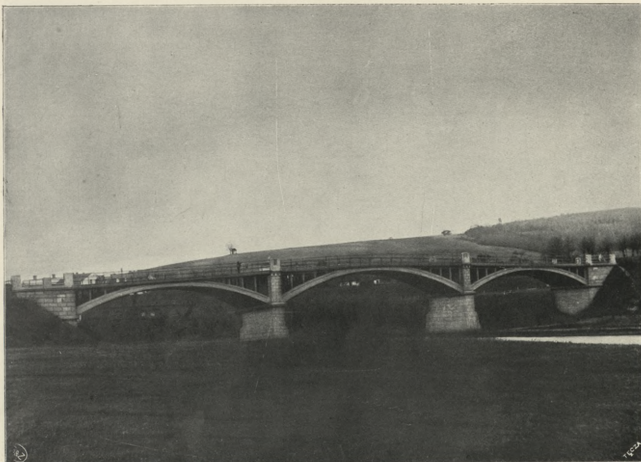
MOST W STRYŻOWIE NA WISŁOKU trzyprzęsłowy, belki łukowe, światło środkowe 25 m, światła skrajne po 20·50 m, szerokość 6 m.
