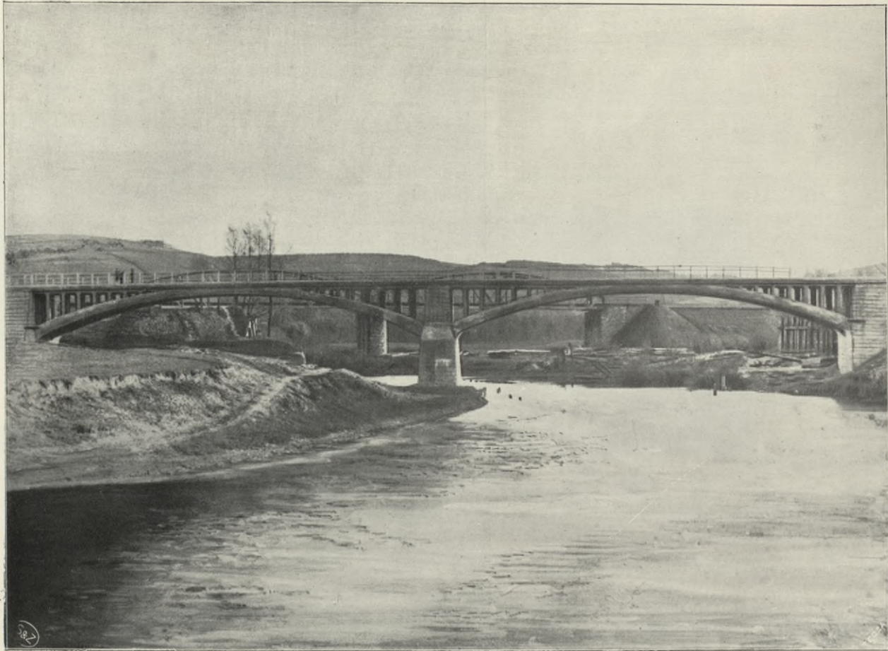
MOST NA WISŁOKU W ŻARNOWIE NA DRODZE RZESZÓW-JASŁO dwuprzęsłowy, belki łukowe, światła po 35 m, szerokość 6 m.
