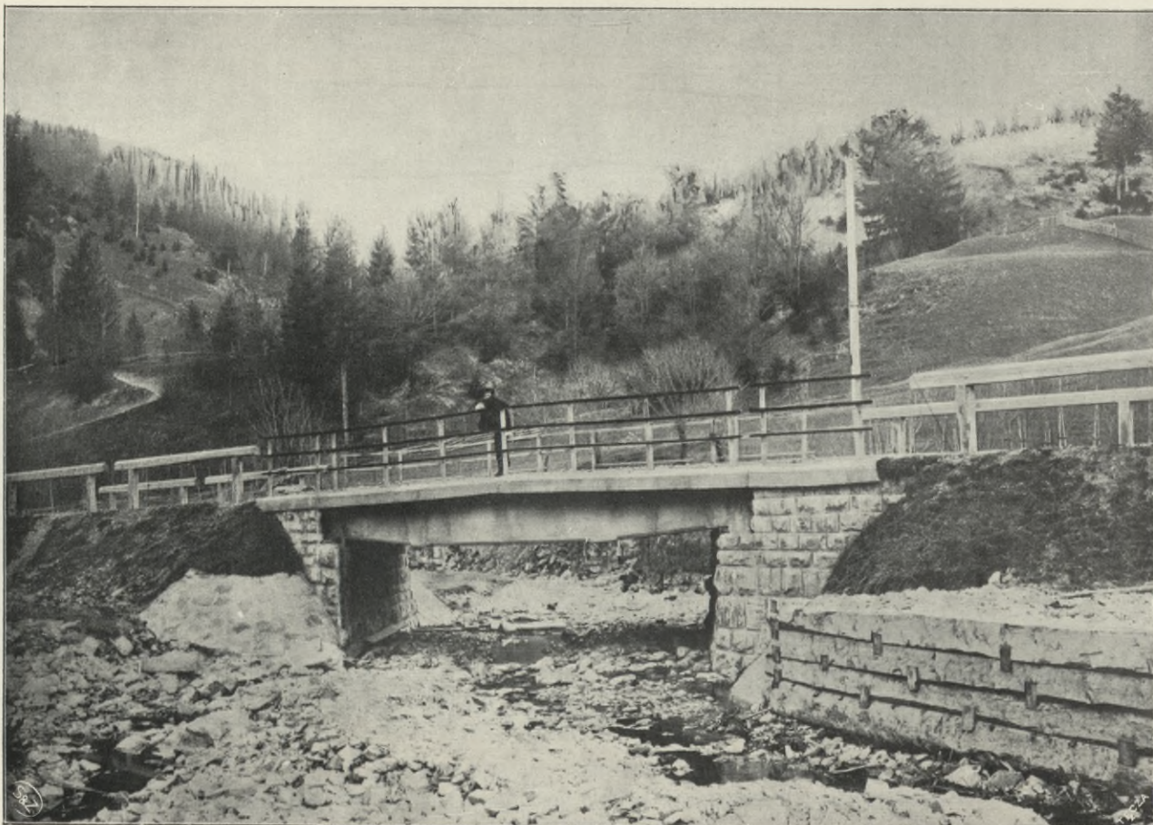
MOST NA DRODZE KOSÓW-JASIONÓW GÓRNY belka prosta, światło 11 m, szerokość 6 m.
