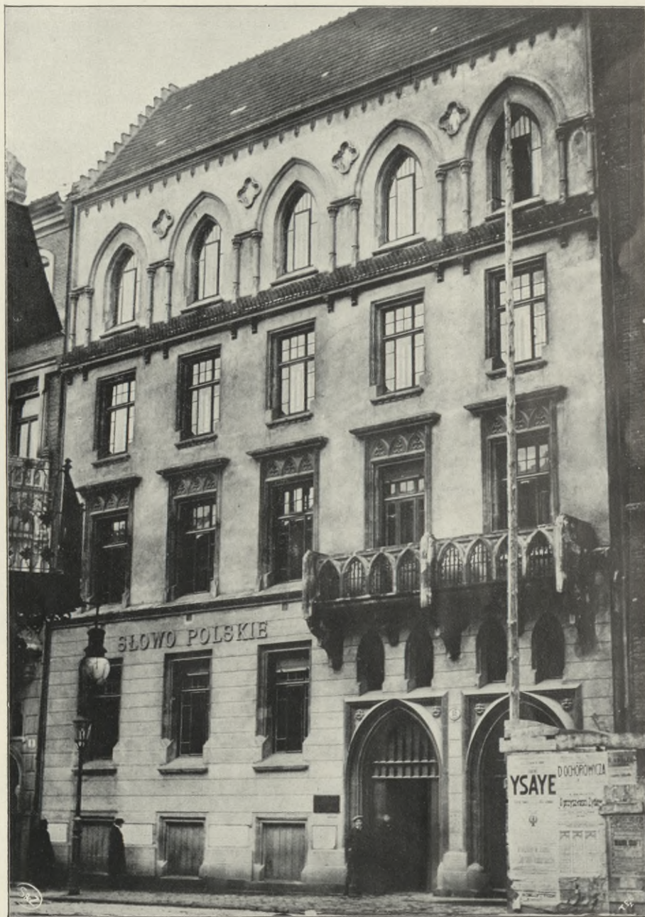
DOM „SŁOWA POLSKIEGO“ WE LWOWIE. Firma nasza wykonała cały budynek. W żel.-bet. wykonano dach, stropy i słupy.
