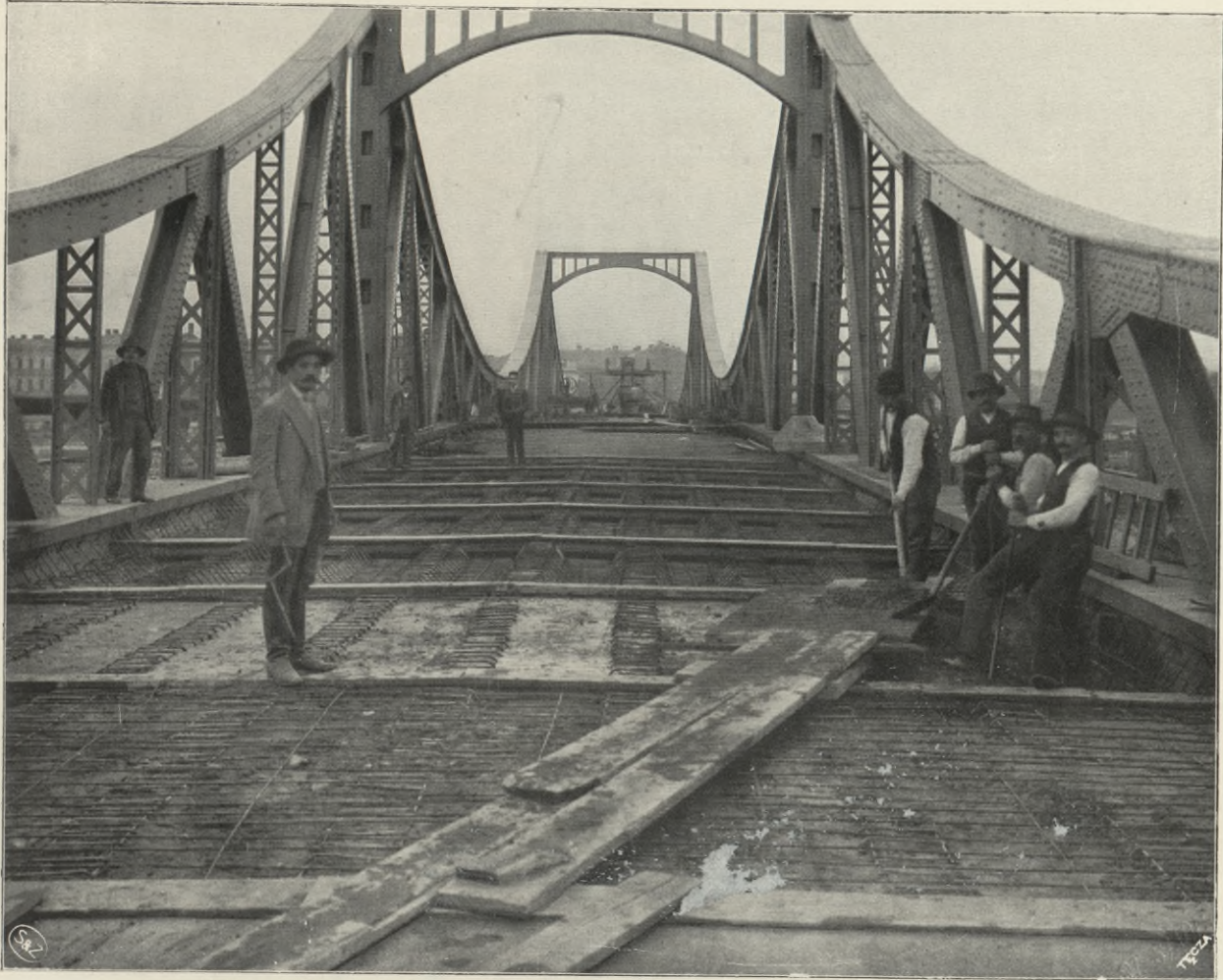
MOST III NA WIŚLE W KRAKOWIE wykonanie toru jezdnego.
