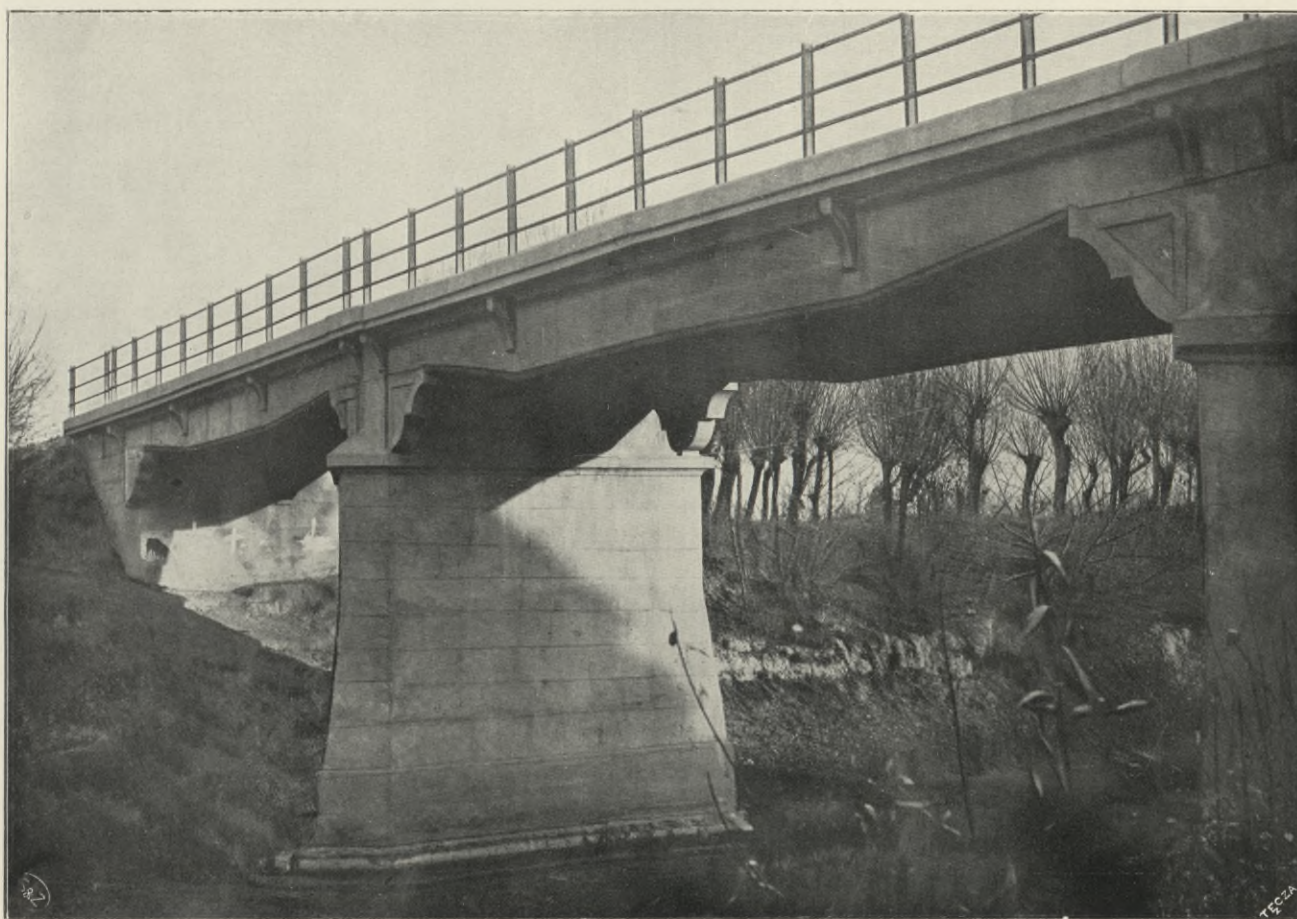
SZCZEGÓŁ MOSTU NA STRWIĄŻU W BISKOWICACH
