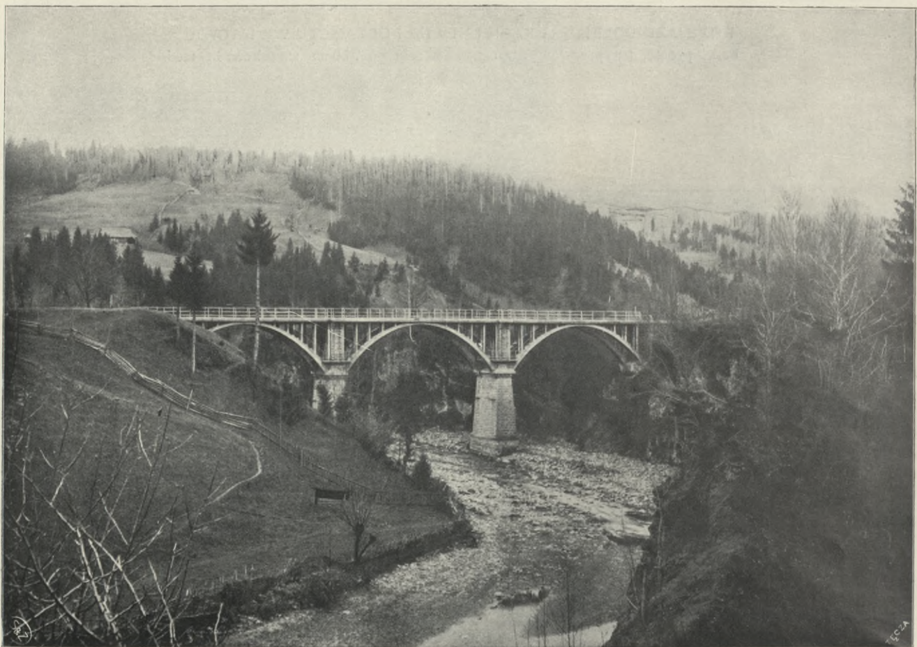
MOST NA DRODZE KOSÓW-JASIONÓW GÓRNY belki łukowe, trzyprzęsłowy, światło środkowe 18 m, światło skrajne po 17 m, szerokość 6 m.
