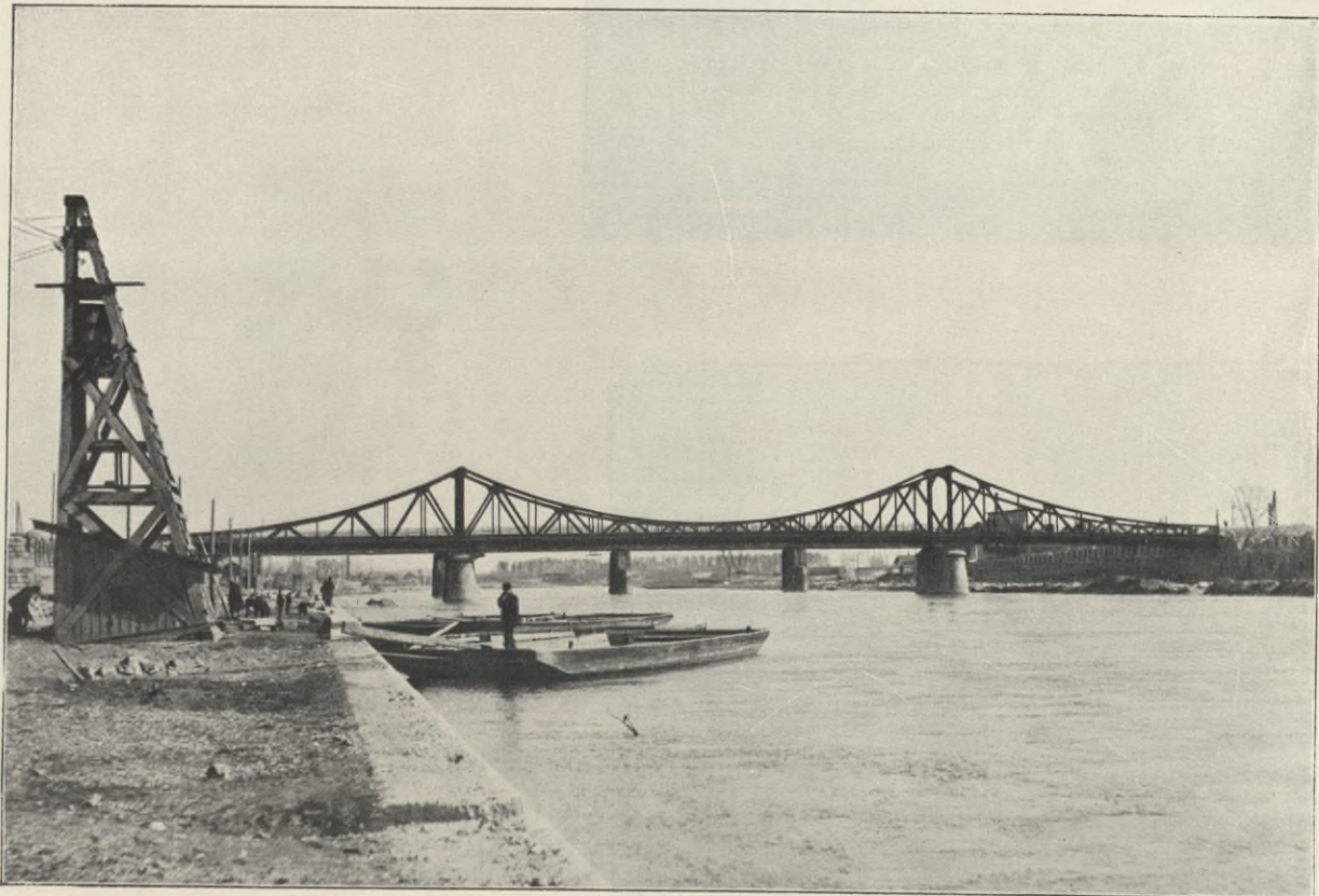
MOST III NA WIŚLE W KRAKOWIE wykonano przyczółki i filary.
