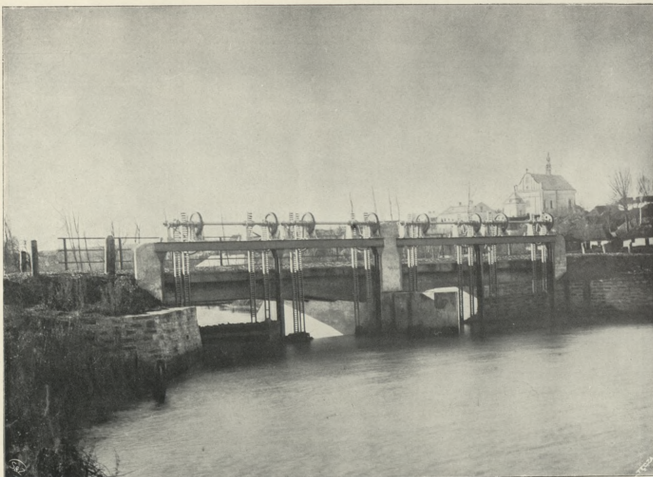
MOST ZE SZLUZĄ NA STRYPIE W WIŚNIOWCZYKU dwuprzęsłowy, belka ciągła, światła po 80 m, szerokość 6 m.
