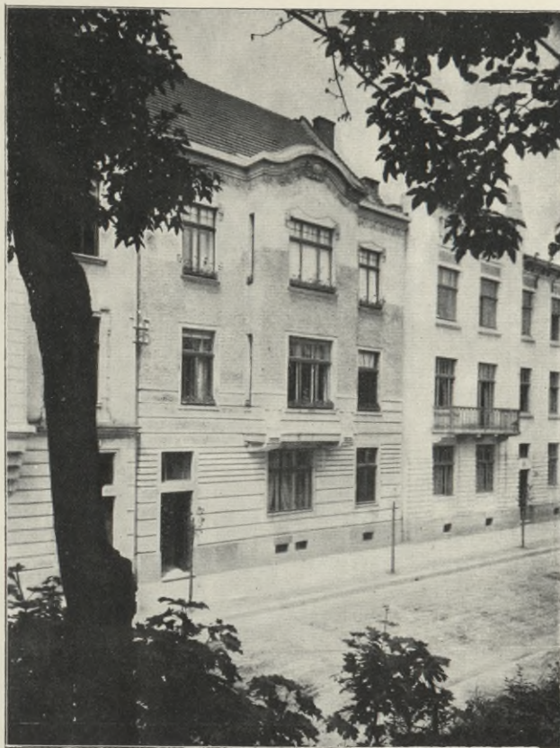
DOM PRZY ULICY JABŁONOWSKICH WE LWOWIE. Firma nasza wykonała cały budynek. W żelazo-betonie wykonano stropy i erkier.
