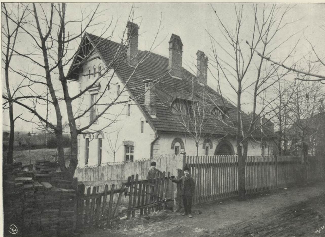
WILLA NA KASTELÓWCE WE LWOWIE. Firma nasza wykonała cały budynek, w żelazo-betonie wykonano część stropów.
