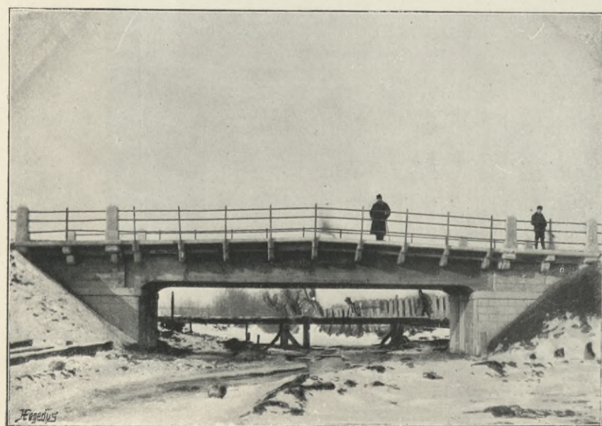
MOST W POMORZANACH NA DRODZE ZARWANICA-BRZEŻANY dwuprzęsłowy, belka ciągła, światła po 9 m, szerokość 6 m.
