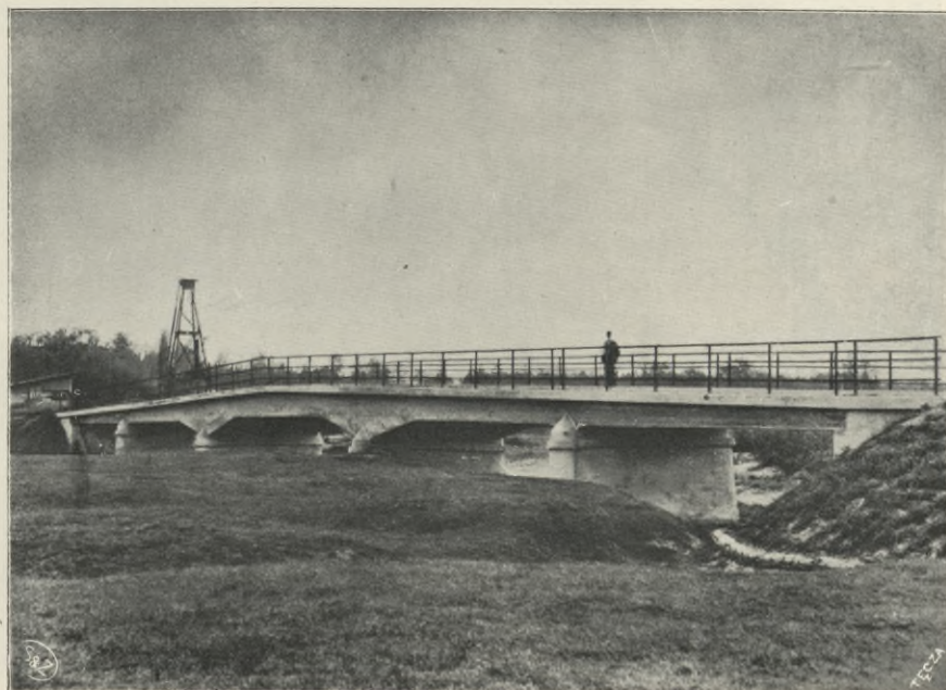
MOST W WOLICY NA RACIE trzyprzęsłowy, belka ciągła, światło środkowe 17·30 m, światła skrajne po 11 m, szerokość 4·30 m.
