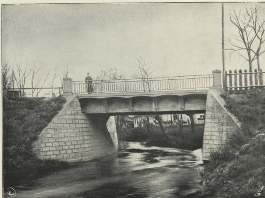
MOST W ROGOŹNIE NA DRODZE PRZEMYŚL-SAMBOR belka prosta, światło 6 m, szerokość 6 m.
