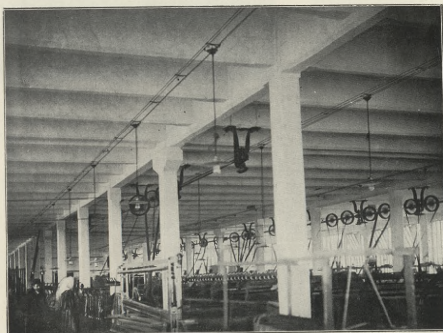
PRZĘDZALNIA FABRYKI SUKNA W RAKOWIE. Wykonana cała w żelazo-betonie.
