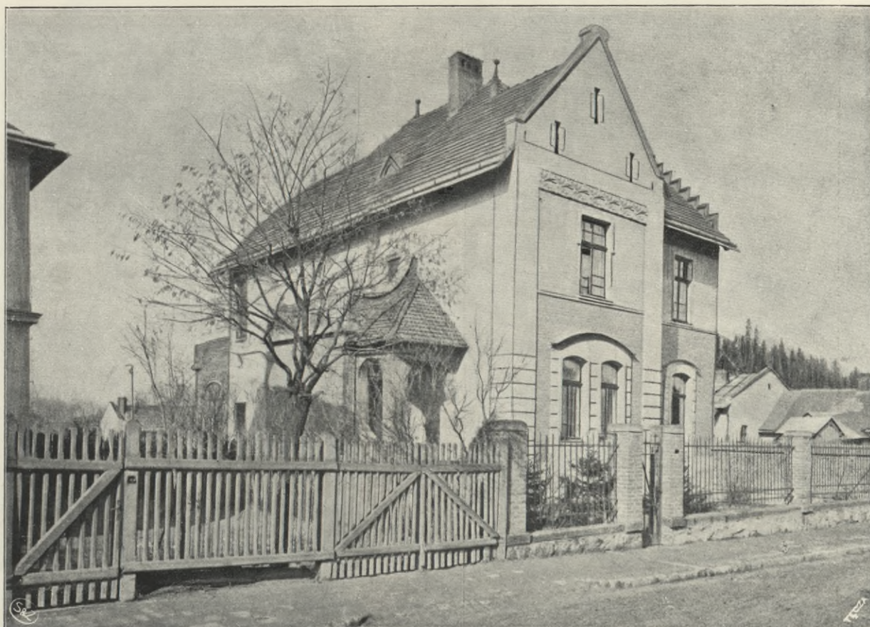
WILLA PRZY ULICY SOBIESZCZYŻNA WE LWOWIE. Firma nasza wykonała cały dom, w żelazo-betonie wykonano część stropów.
