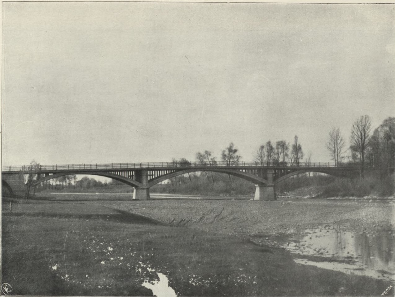
MOST NA ASIOLCE POD KROSNEM trzyprzęsłowy, belki lukowe, światło środkowe 25 m, światła skrajne po 22 m, szerokość 6 m.
