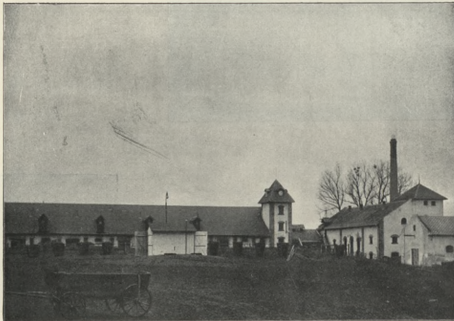
STAJNIA I GORZELNIA W CZERNIŁOWIE MAZOWIECKIM. Wykonano stropy.
