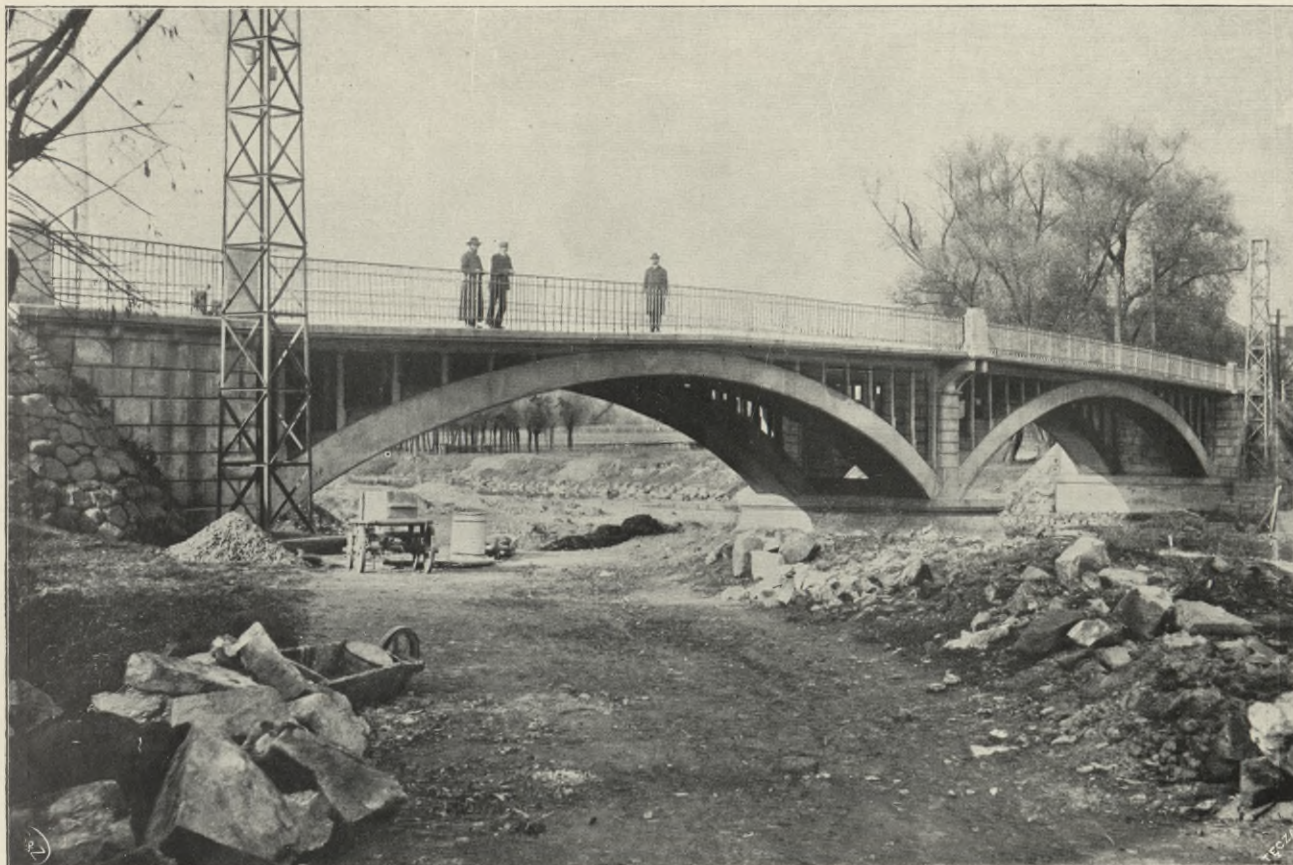
MOST W NOWYM SĄCZU NA DRODZE ZAKLICZYN-NOWY SĄCZ-NIEDZICA dwuprzęsłowy, belki lukowe, światła po 30 m, szerokość 7.70 m.
