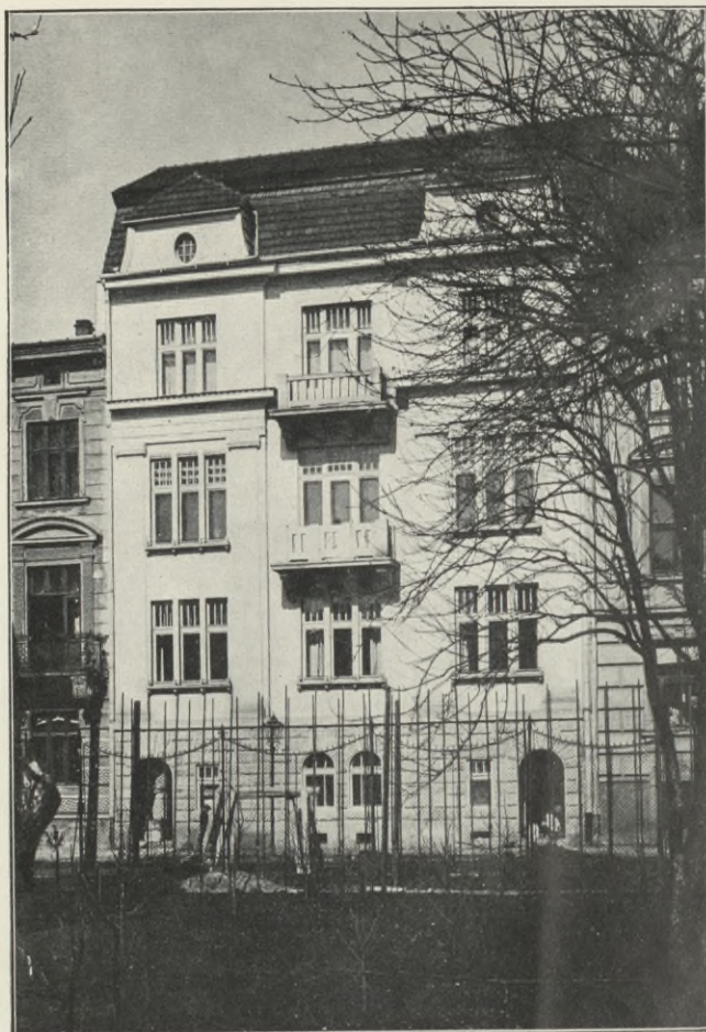
DOM WP. GLASERA W KRAKOWIE. Wykonano stropy.
