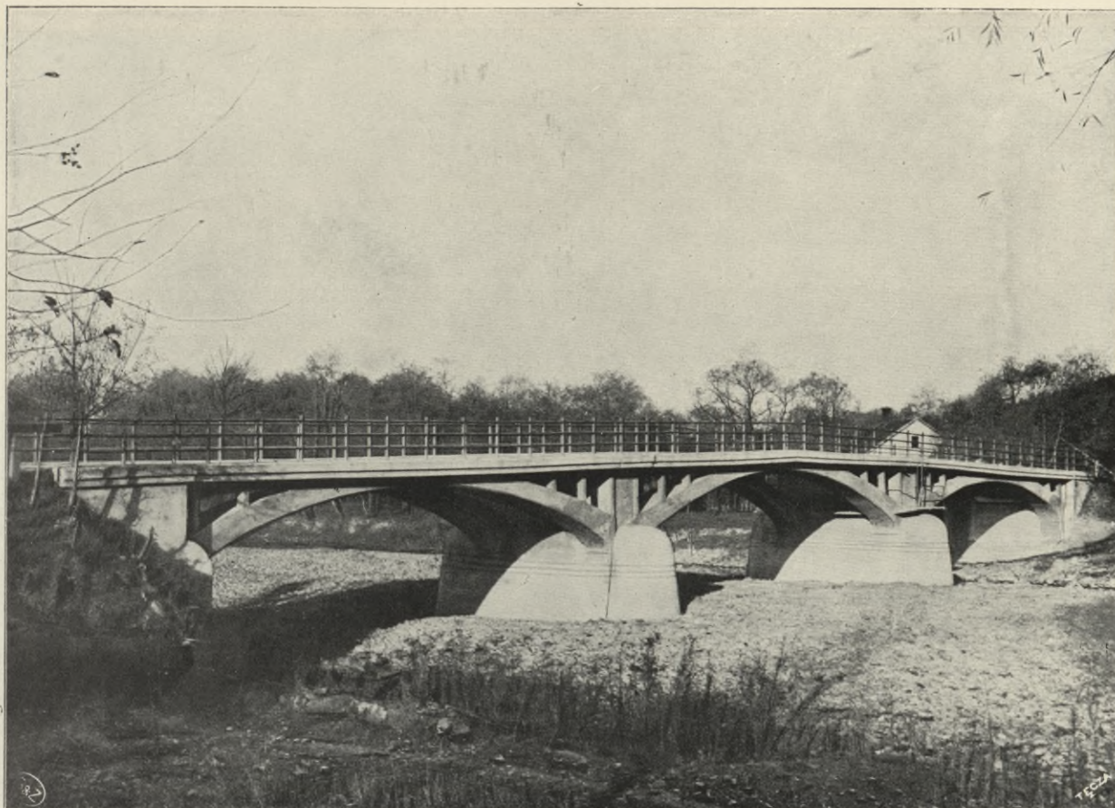
MOST NAD KOSZARAWĄ NA DRODZE JELEŚNA-ŻYWIEC trzyprzęsłowy, belki łukowe, światło środkowe 17·60 m, światła skrajne po 15·50 m, szerokość 6 m.
