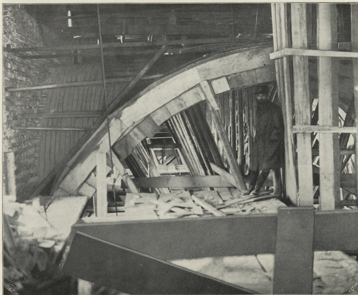
Sklepienie podczas budowy.
