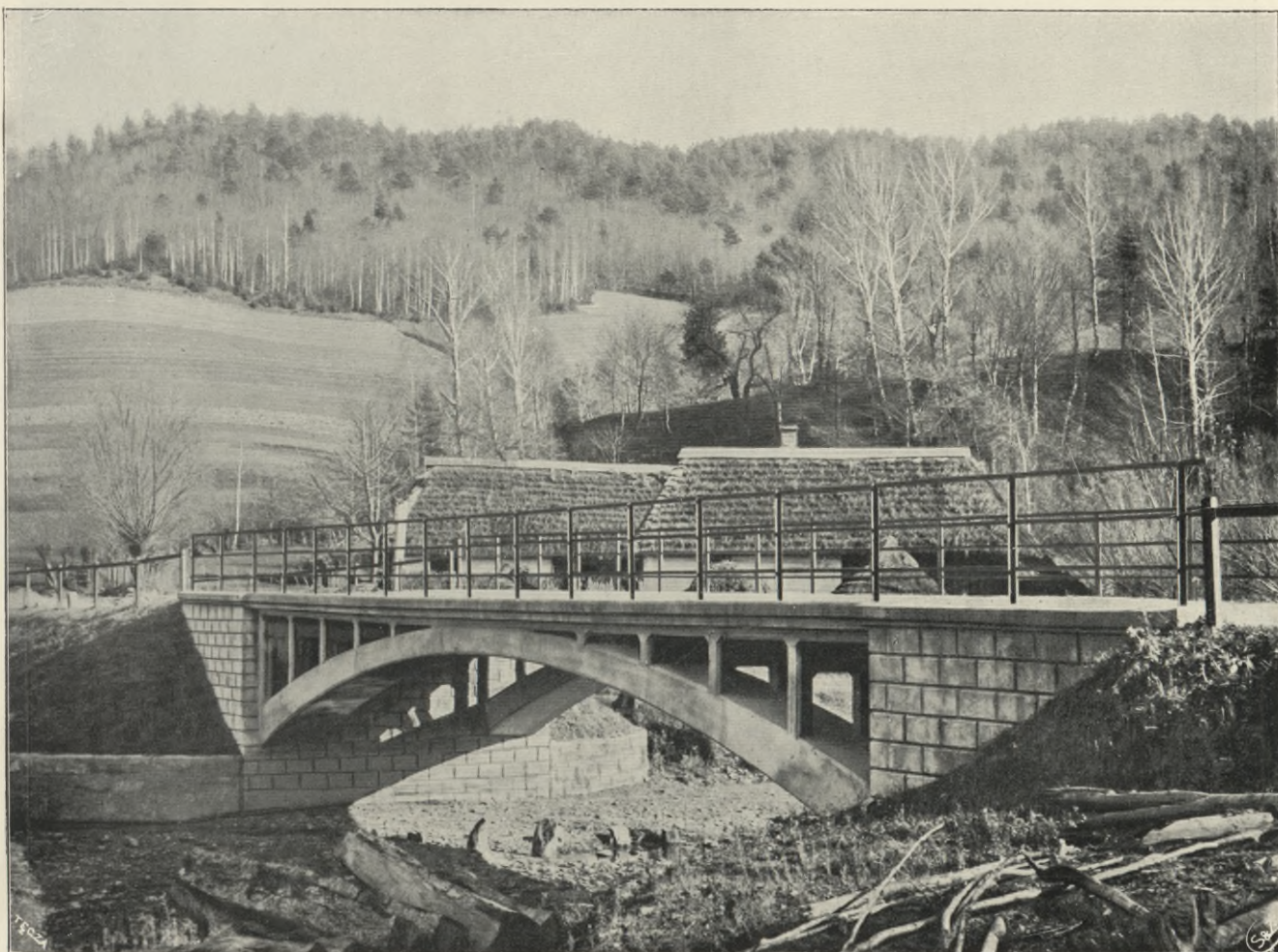
MOST W ZAŁUŻU NA DRODZE PRZEMYSŁ-SANOK belki łukowe, światło 18 m, szerokość 6 m.
