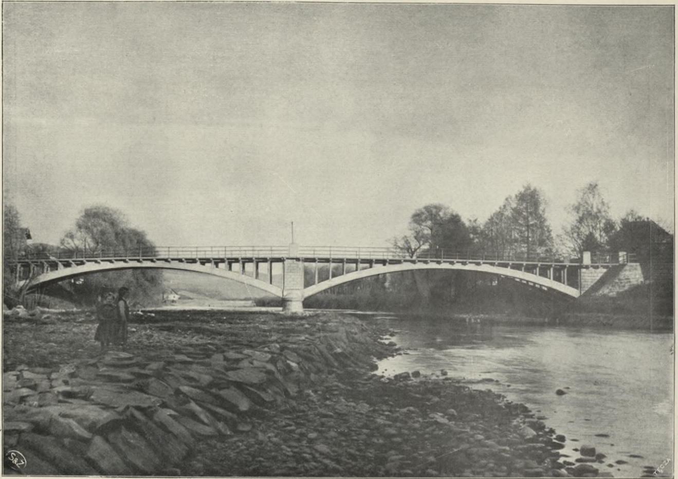
MOST NA DUNAJCU W NOWYM TARGU belki łukowe, dwuprzęsłowy, światła po 30 m, szerokość 7·70 m.
