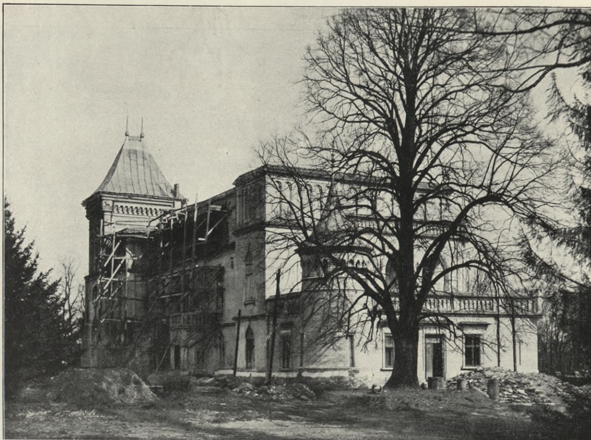
ZAMEK HR. REYÓW. W PRZECŁAWIU. Wykonano stropy i kosz dachowy.
