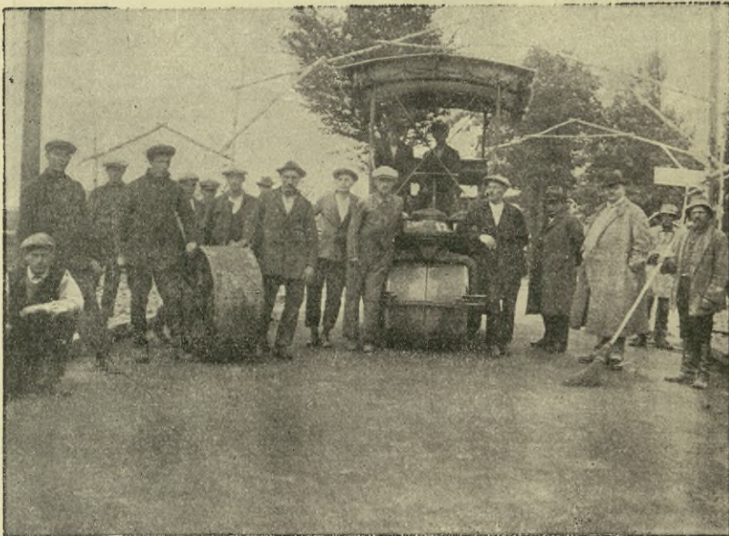
Rys. 8. Wałowanie „Komdrobitu“ wałem benzynowym.
