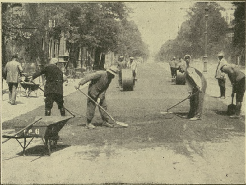
Rys. 5. Rozścielenie sztucznego asfaltu.
