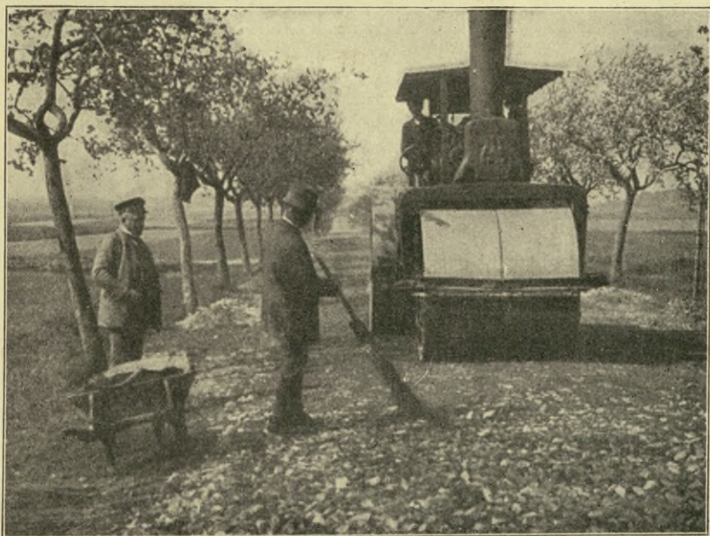
Rys. 10. Wałowanie drogi komdrobitowo-szutrowej.
