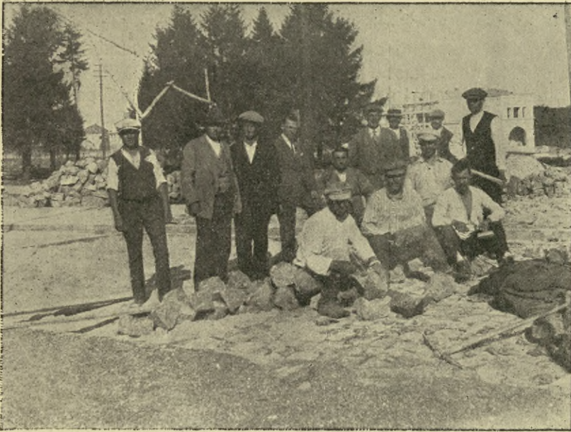
Rys. 12. Działka Nr. 8. podczas budowy.
