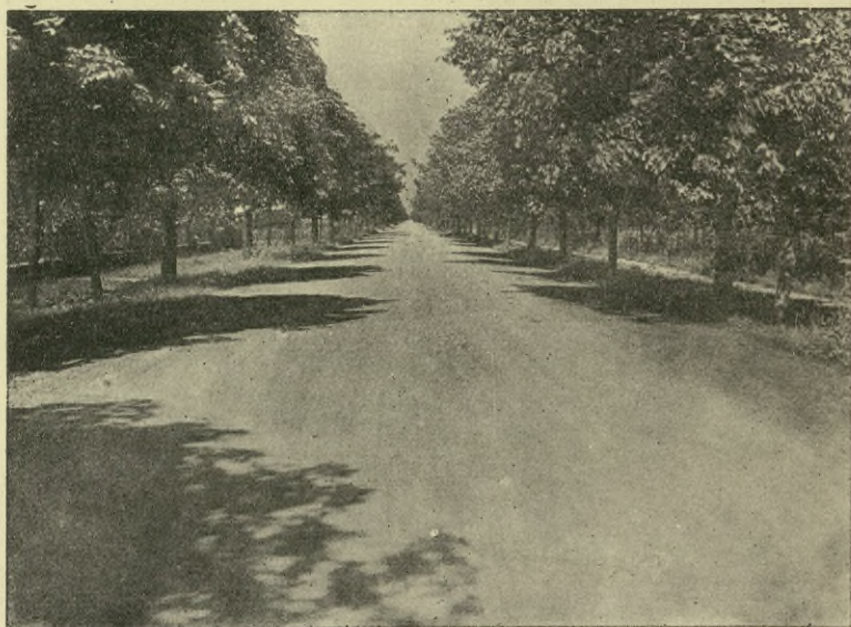
Rys. 19. Droga utrwalona sprameksem.
