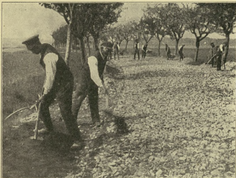
Rys. 9. Dodawanie „Komdrobitu“ do szutrówki.
