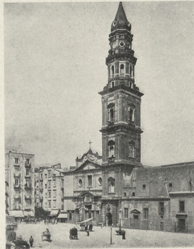
NEAPOL. TARG NAD DOLNĄ ZATOKĄ. PLAC I KOŚCIÓŁ DEL CARMINE.
