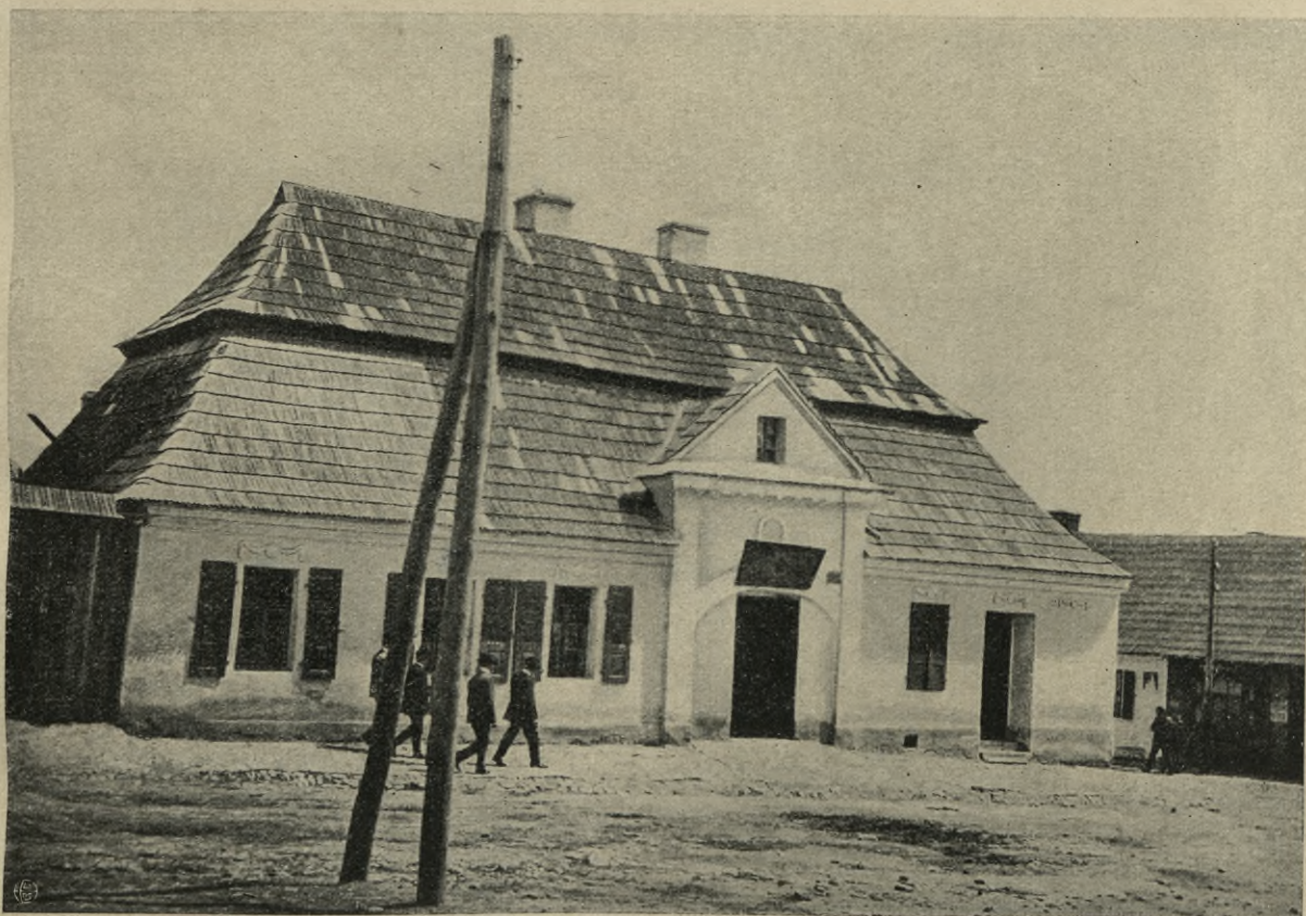
34. SŁAWKÓW, DOM MIEJSKI MUROWANY.
