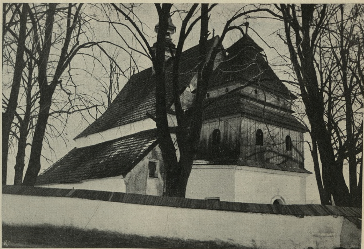
181. ĆMIŃSKO, KOŚCIÓŁ PARAF. p. w. Św. TRÓJCY. PIĘKNA I CHARAKTERYSTYCZNA DZWONNICA DREWNIANA NAD WEJŚCIEM GŁÓWNYM, POCHODZĄCA Z POCZĄTKU XVIII W. ZOSTAŁA ROZEBRANA, A KOŚCIÓŁ CAŁY MA ULEDZ PRZEBUDOWIE.
