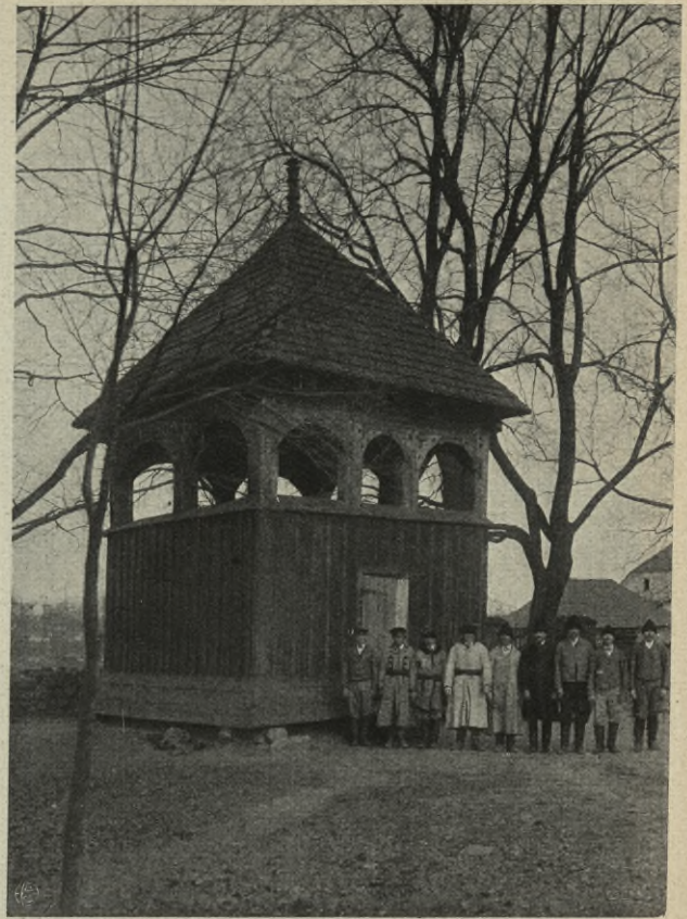
388. LUBOCHNIA, DZWONNICA PRZY KOŚCIELE PARAFIALNYM.
