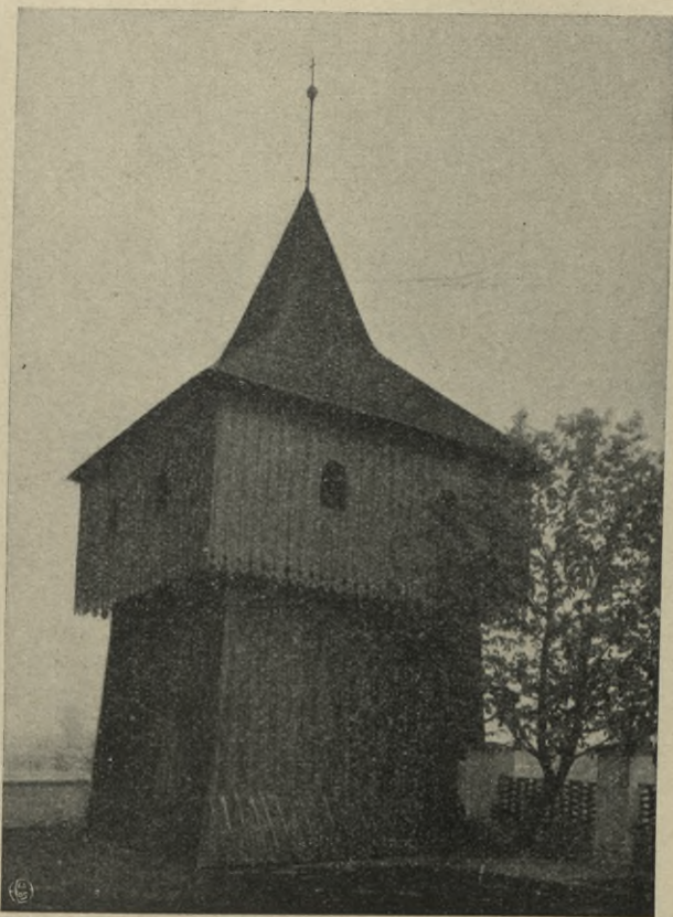
163. BESZOWA, DZWONNICA PRZY KOŚCIELE PARAFIALNYM.
