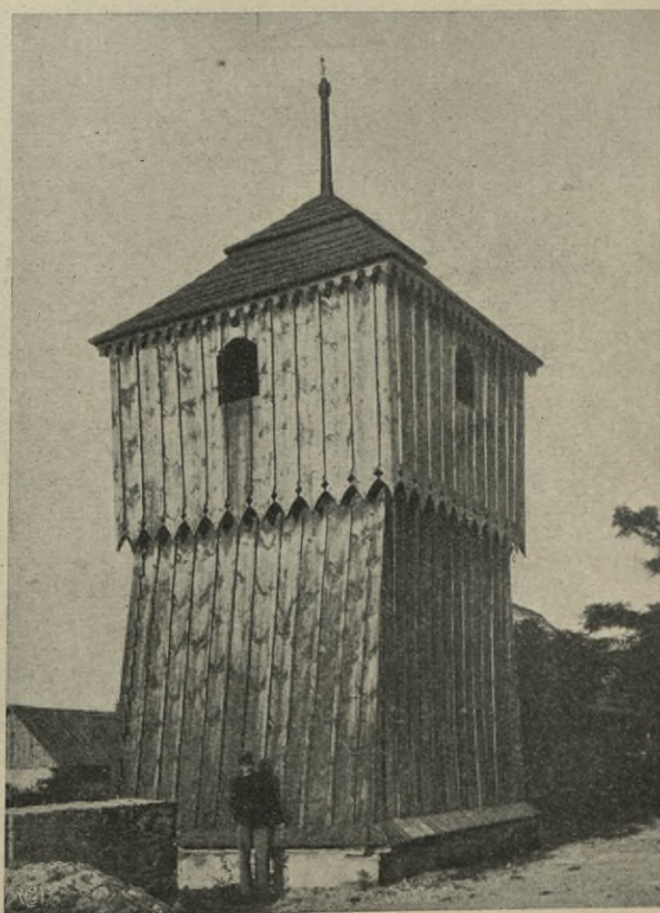
161. ZAGÓŚĆ, DZWONNICA PRZY KOŚCIELE PARAFIALNYM.
