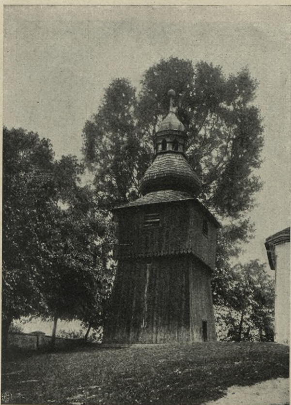
74. KONIUSZA, DZWONNICA DREWNIANA PRZY KOŚCIELE PARAFIALNYM.
