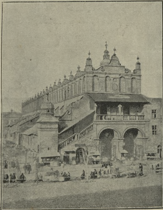
Fig. 26. Sukiennice w Krakowie przed odbudową.
