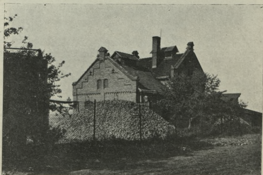
Ryc. 42. Gazownia w Dublanach.
