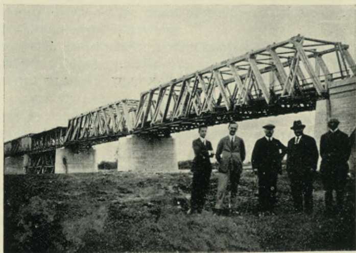
Ryc. 2. Most na Sanie pod Zarzeczem 5 \times 40 = 200 m św. systemu Inż. L. Grocha.
