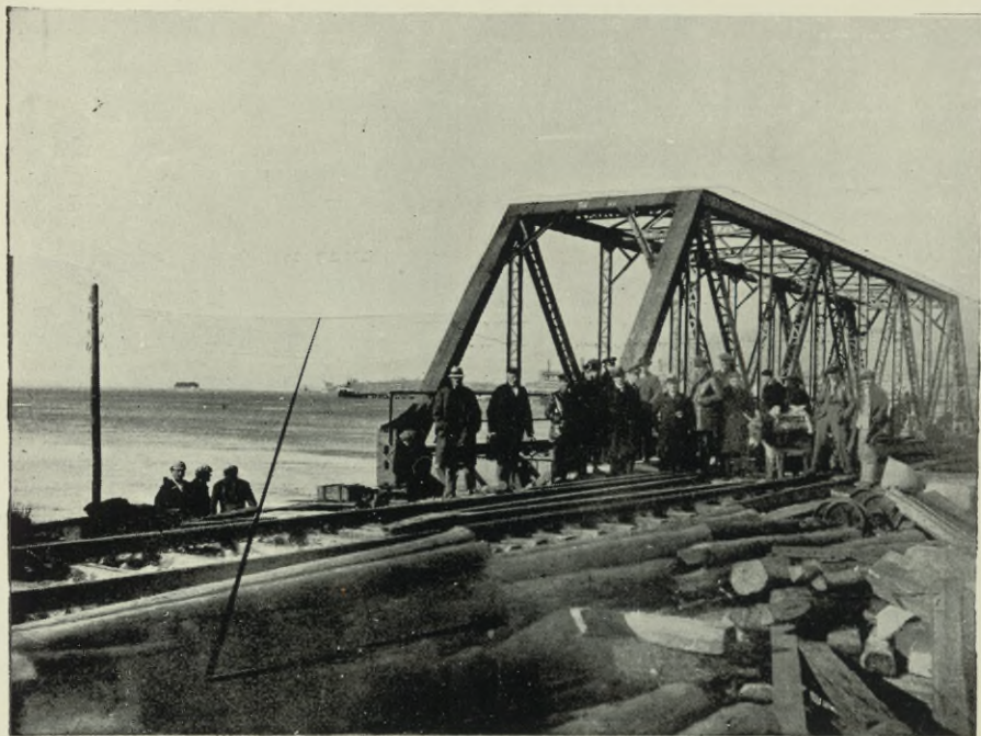
Ryc. 1. Most na rzece Jadro o rozpiętości 39,7 m.
