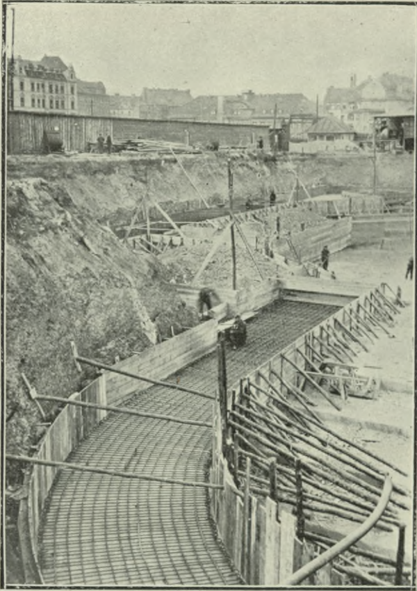
Ryc. 1. Układ wkładek żelaznych fundamentów murów zewnętrznych.
