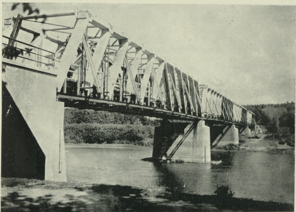
Ryc. 7. Most na Dniestrze pod Żurawnem 4 \times 45 m św.) systemu L. Grocha, zbudowany w r. 1931.
