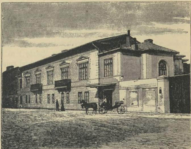
Dom Kraszewskiego przy ulicy Mokotowskiej w Warszawie.
