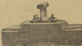
Rys. 13a. Wkładka, wzmacniająca podkład. Rys. 13b.
