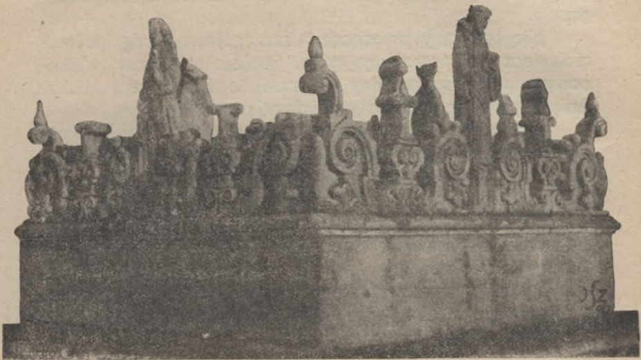
Rys. 67. Ściana czołowa wieży P. P. Benedyktynek we Lwowie.
