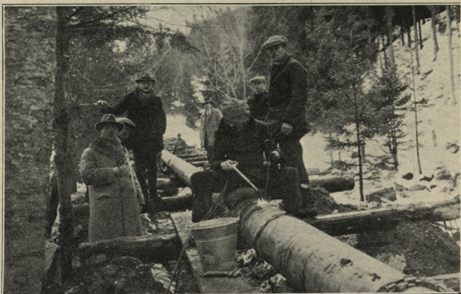
Ryc. 52. Widok spawania rur.
