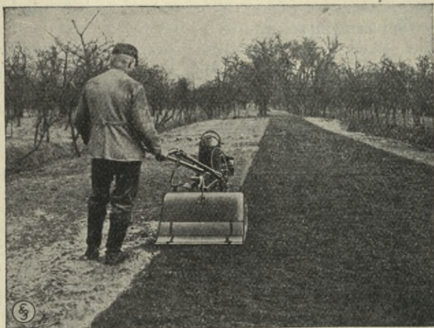
Ryc. 28. Frezarka Siemens-Schuckerta.
