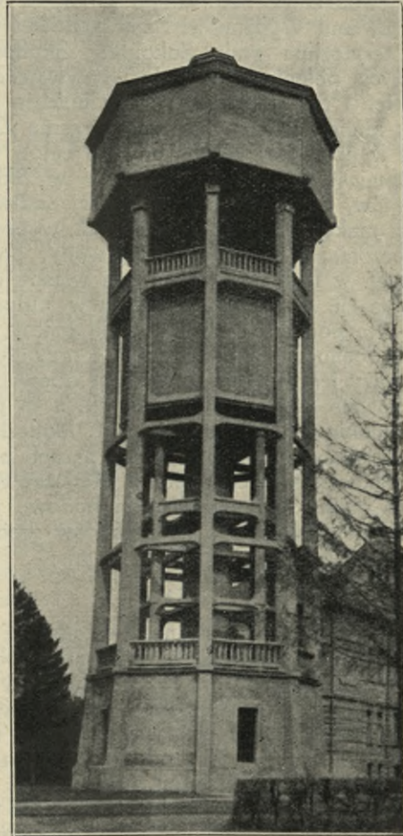
Ryc. 64. Rozbudowana wieża wodna.
