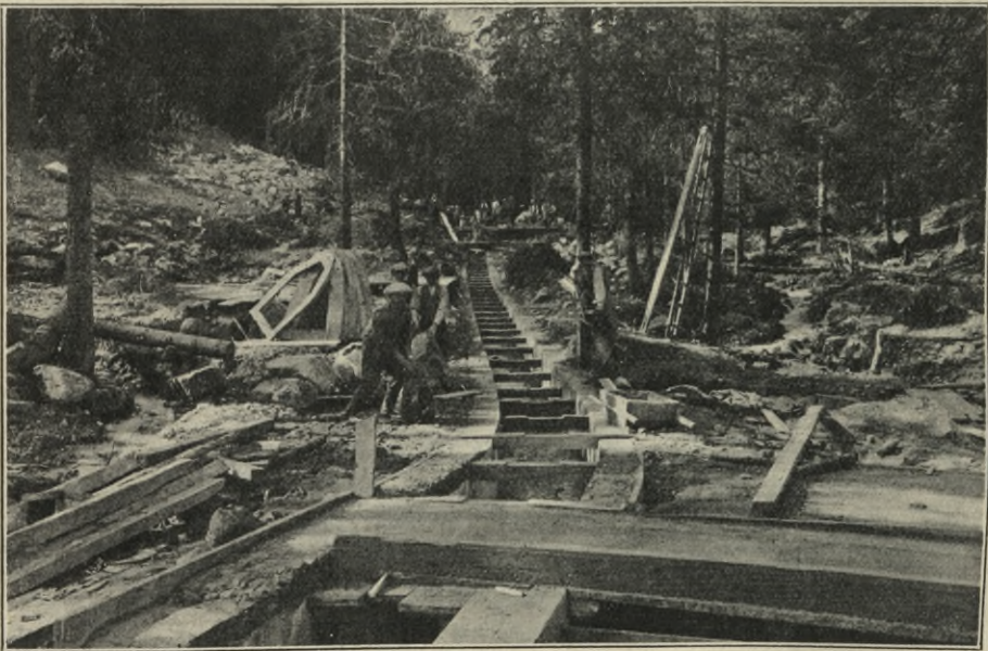
Ryc. 45. Betonowanie dolnej części galerii zbiorczej.
