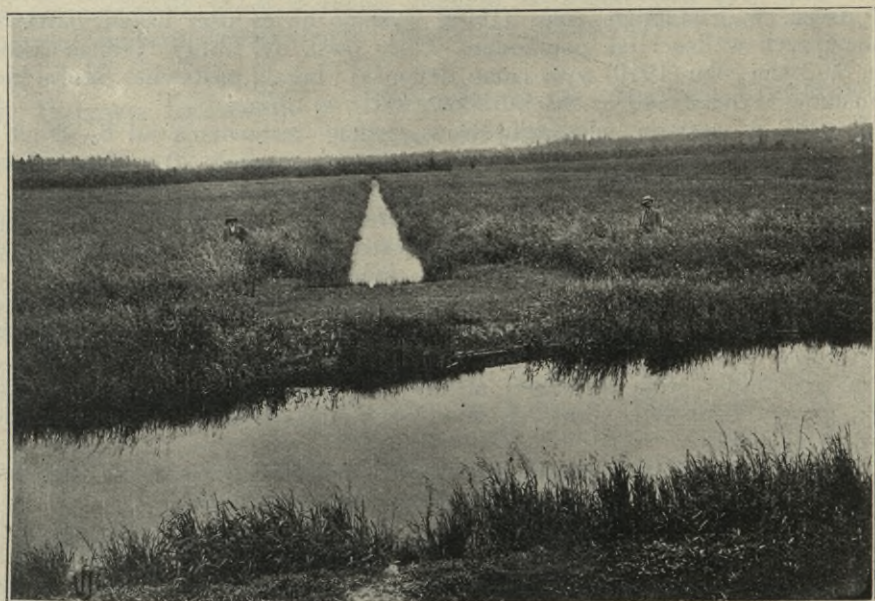
Ryc. 31. Widok zakulturowanej łąki torfowej z potokiem Blizną i jednym rowem grzędowym z wodą spiętrzoną powyżej przepustu betonowego.
