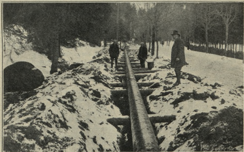
Ryc. 53. Widok rurociągu przygotowanego do spuszczenia na dno rowu.
