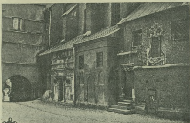
Widok ściany bocznej kościoła św. Barbary w Krakowie.
