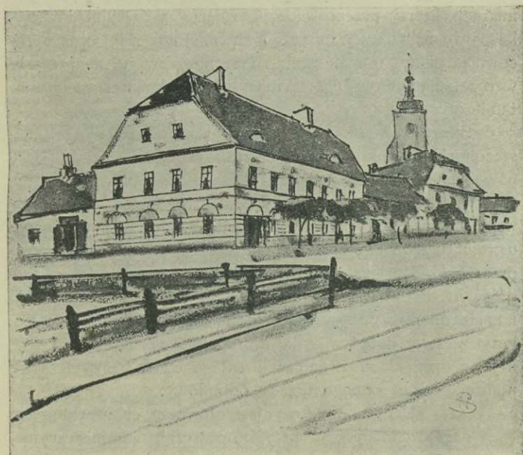
Ryc. 2. Grupa budynków małomiasteczkowych łączących się w małowniczą, często spotykaną całość (rysunek tuszem Stanisława Nokańskiego).
