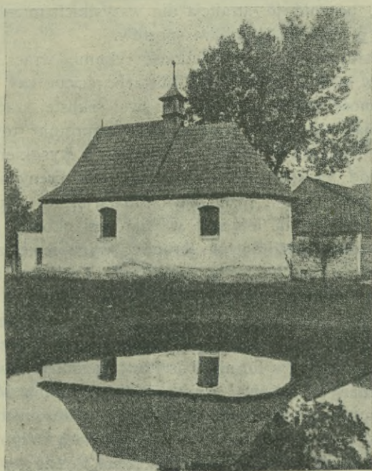
Ryc. 100. Kościółek wiejski w Żarkach (pow. będziński). Zwierciadło stawu przyczynia się znakomicie do podniesienia artystycznego wrażenia wywieranego przez ten skromny budynek.
