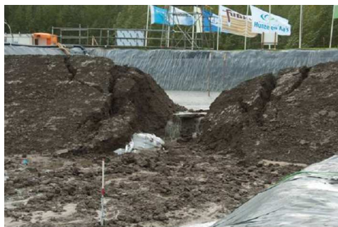
Rys. 7. Katastrofa wału ziemnego na skutek przebicia hydraulicznego, projekt Ijkdijk (fot. Deltares)
