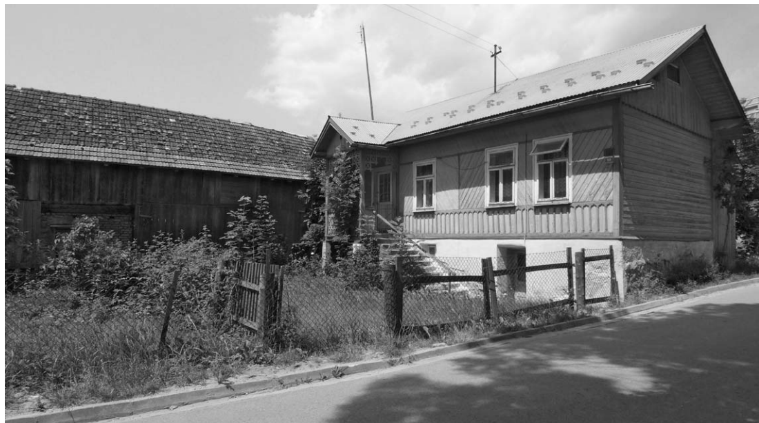
Fot. 4. Tradycyjna zwarta forma zabudowy i usytuowania na działce jest bardzo elastyczna funkcjonalnie. Pozwala ona na stworzenie atrakcyjnych apartamentów dostępnych z poziomu terenu, przy wykorzystaniu dawnej struktury zagrody. (Fot. U. Forczek-Brataniec)
