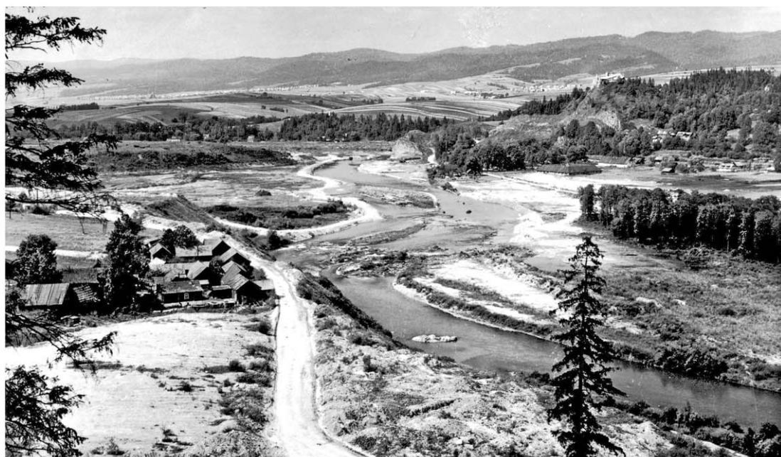
Ryc. 2. Krajobraz w trakcie budowy zbiorników wodnych. Układ komunikacyjny ulega zmianie, z doliny stopniowo przenosząc się na stoki wzgórz. Osadnictwo podąża za strukturą komunikacyjną, stając się silnie eksponowanym elementem krajobrazu. (Oprac. U. Forczek-Brataniec, fot. S. Michalczuk)
