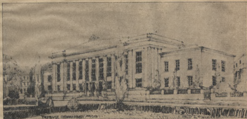
Nowy Gmach Biblioteki Politechniki Lwowskiej wybudowany w r. 1934.
