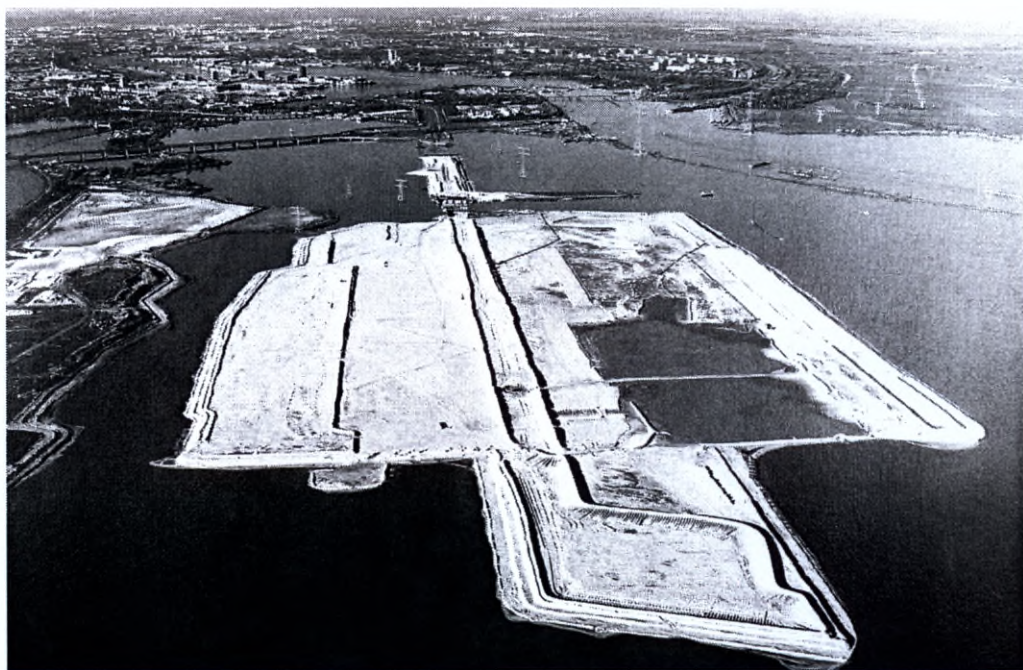
Ryc. 381. Realizacja jednej ze sztucznych wysp dla rozbudowy Amsterdamu [160]
