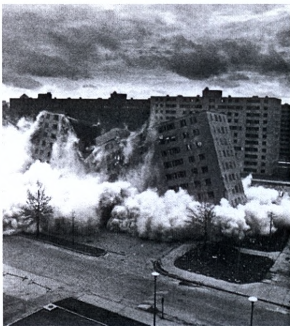
Ryc. 382. Lipiec 1972 r. – moment wysadzenia dynamitem osiedla Pruitt-Igoue [26]
