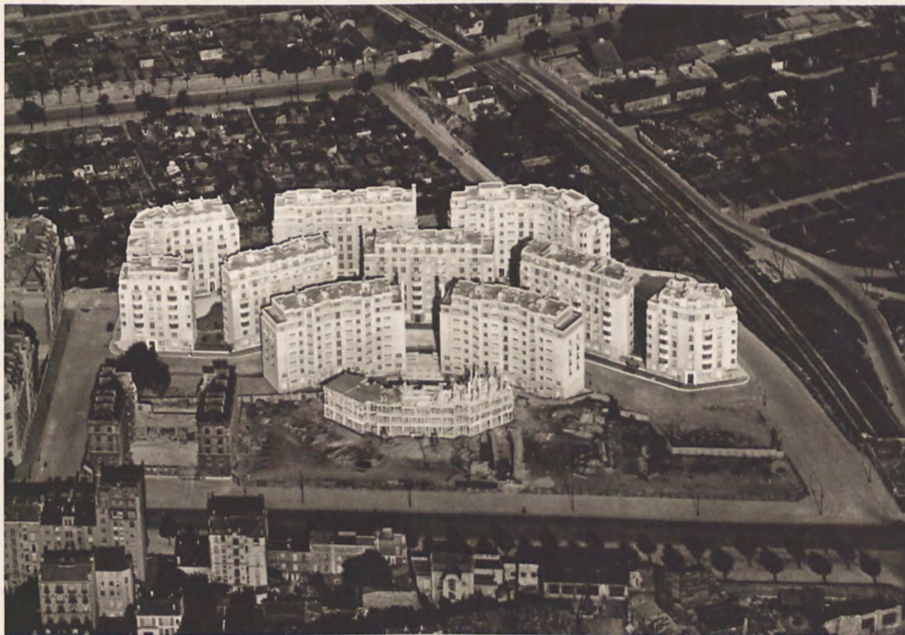
VUE D'ENSEMBLE, PRISE EN AVION à gauche : bâtiments militaires non encore démolis, au centre : bâtiment en cours de construction sur la rue Ernest Lavisse.
