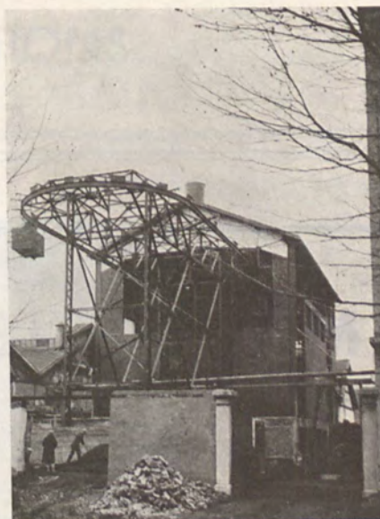
Canalisation Électrique. MM. Labussière et Reby, Architectes
