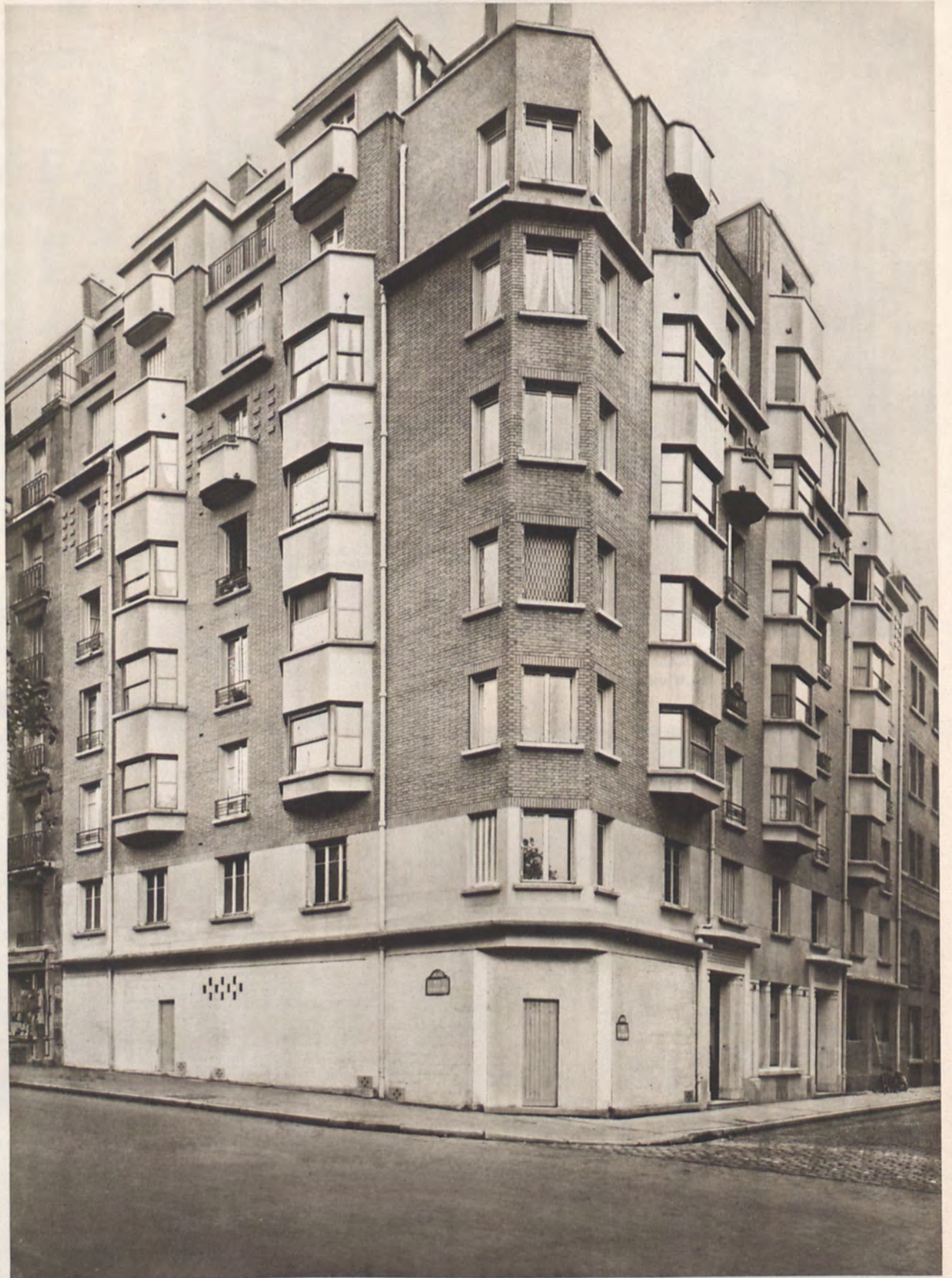
Façades sur les rues de la Roquette et de la Croix Faubin.
