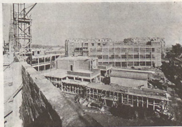
Groupe scolaire Porte d'Ivry
