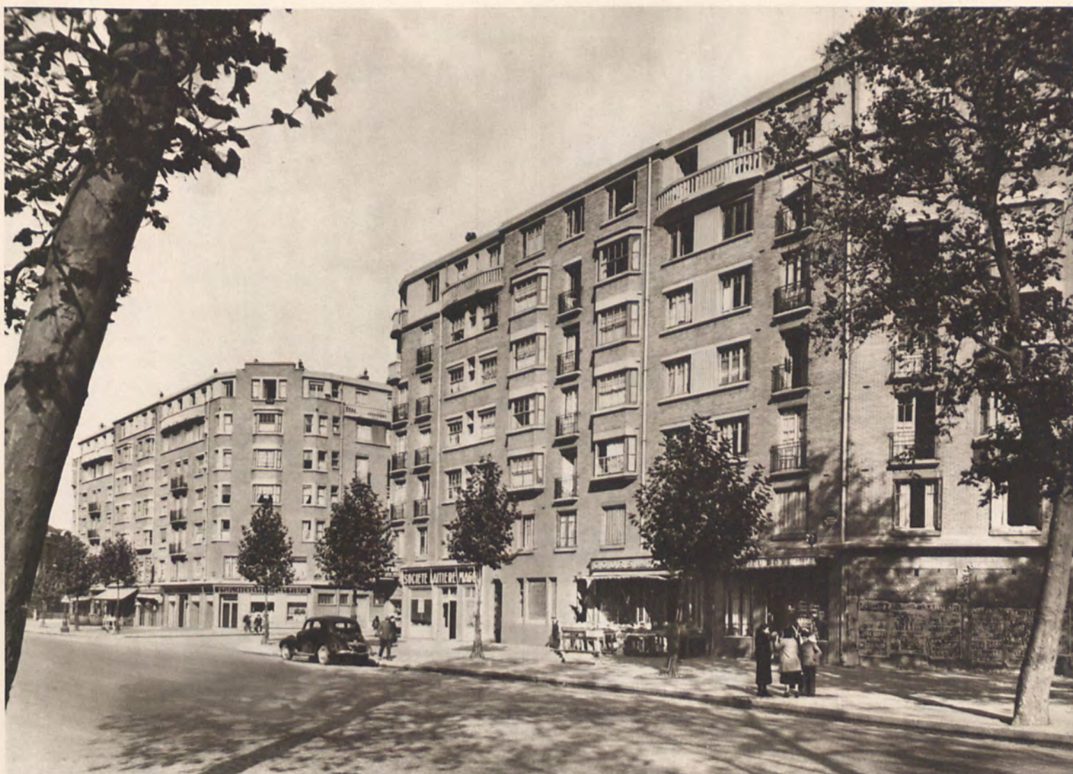
Vue sur l'avenue de la Porte d'Ivry.
