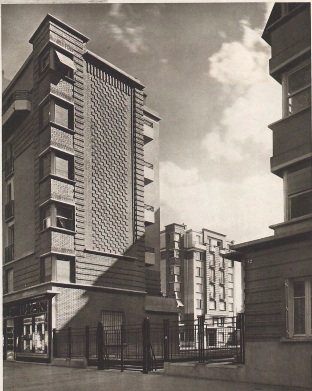
Entrée de l'immeuble : 12 boulevard Victor.
