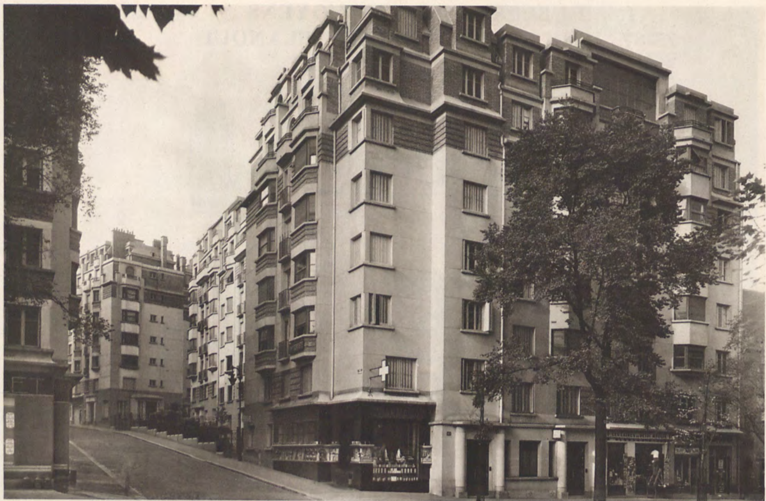
Façade sur le boulevard Auguste Blanqui.
