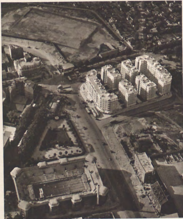
VUE D'ENSEMBLE, PRISE EN AVION En avant : la Piscine des Tourelles.
