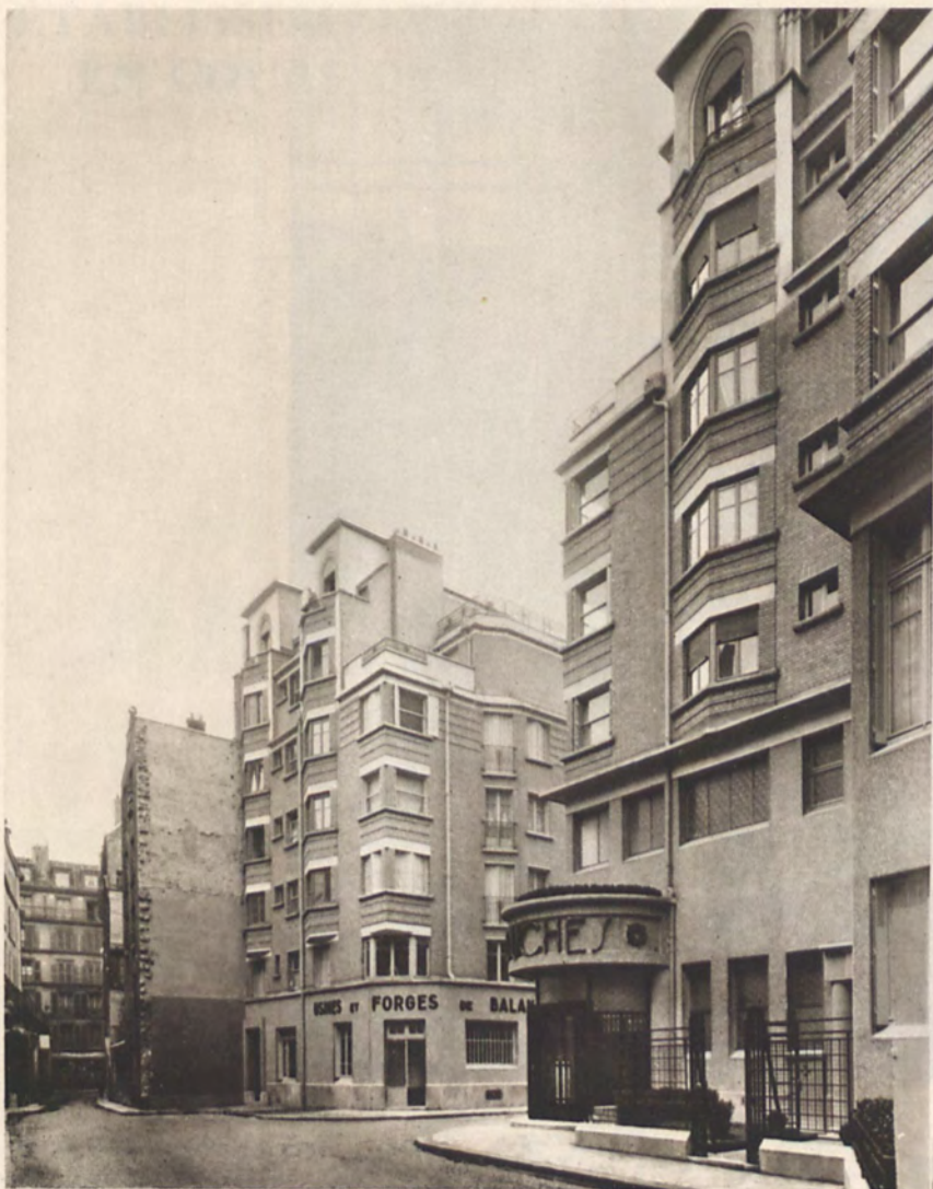
Les habitations du type intermédiaire de la rue Legouvé. Entrée de l'établissement de douches.
