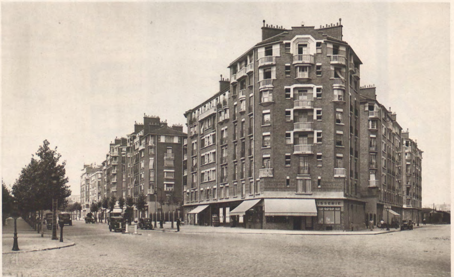
Angle du boulevard Davout et de la rue Eugène Reisz.
