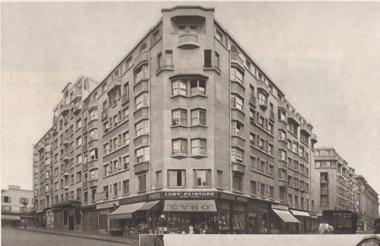
Façade sur les rues de la Roquette et Gerbier.
