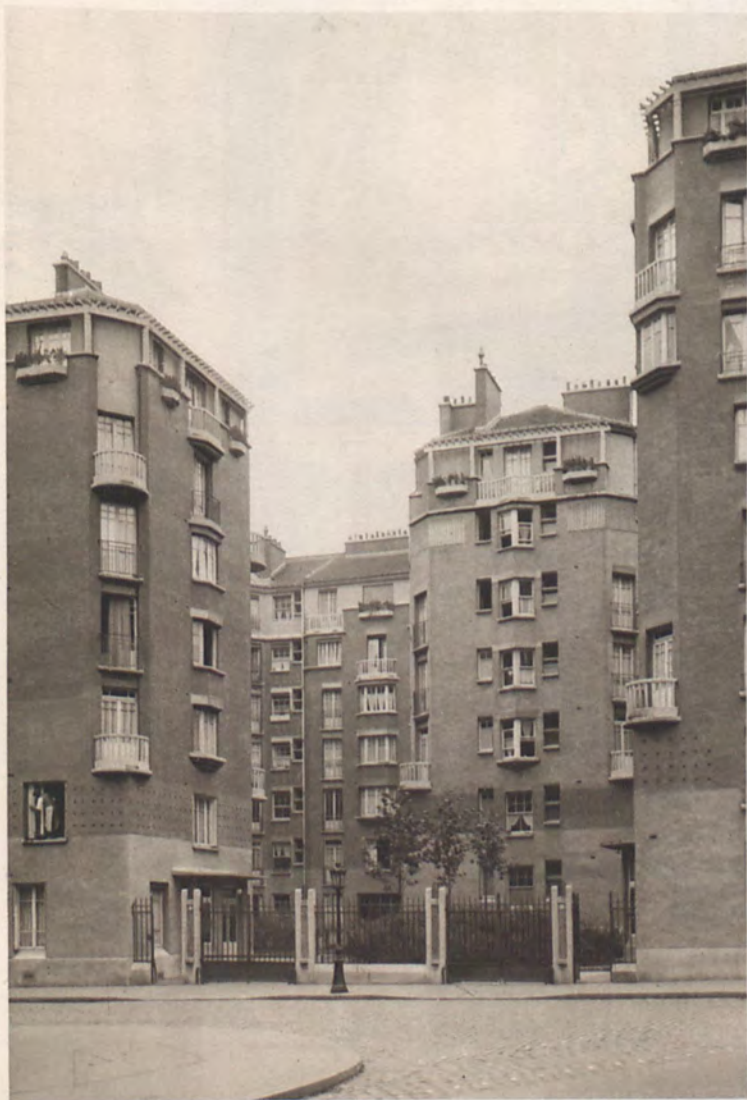
Entrée de l'immeuble, 2 et 4, rue André Messager.
