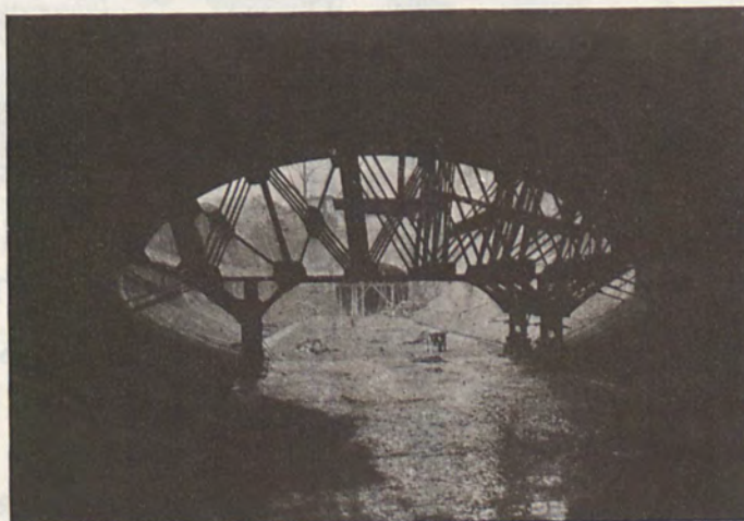
Construction de la ligne métropolitaine n° 7, station Porte de Choisy
