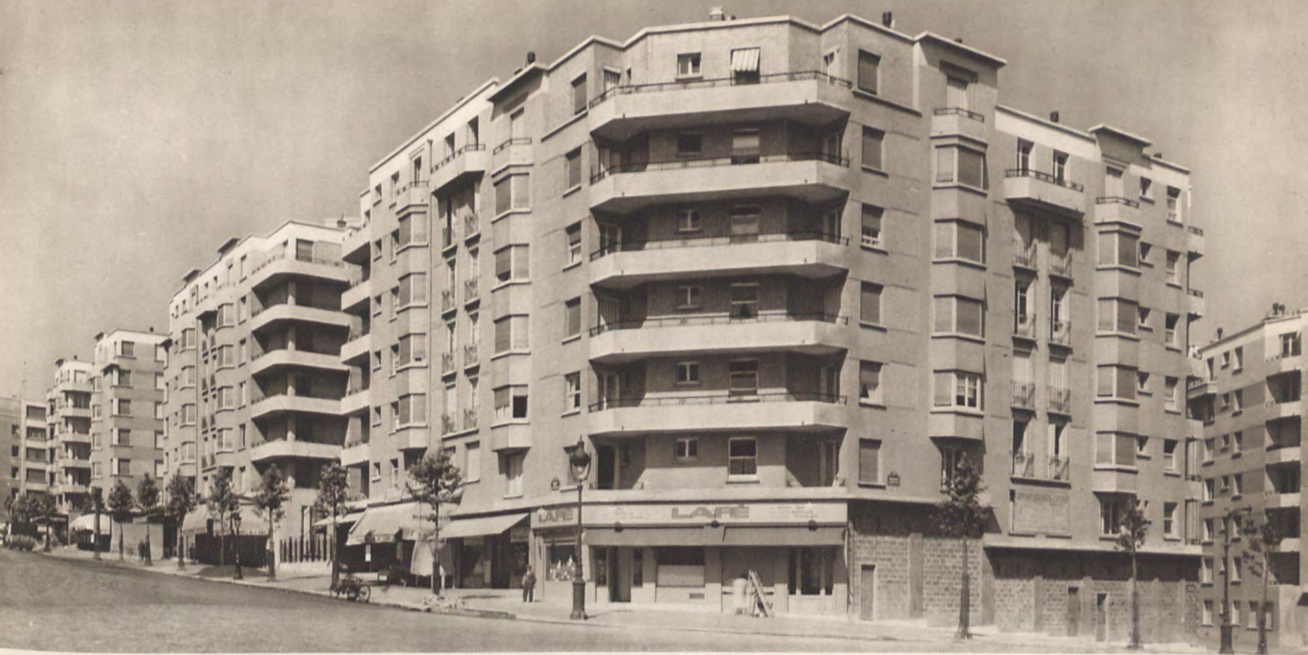
Façade sur l'avenue de la Porte Brunet.
