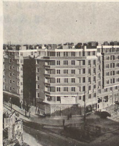
Ph. Chevojon Bastion 18. OFFICE d'H. B. M. DE LA VILLE DE PARIS, 6 immeubles. M. Maline, Architecte.
