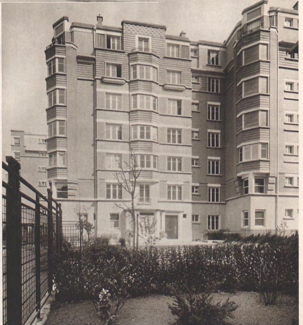
Détail de façade.
