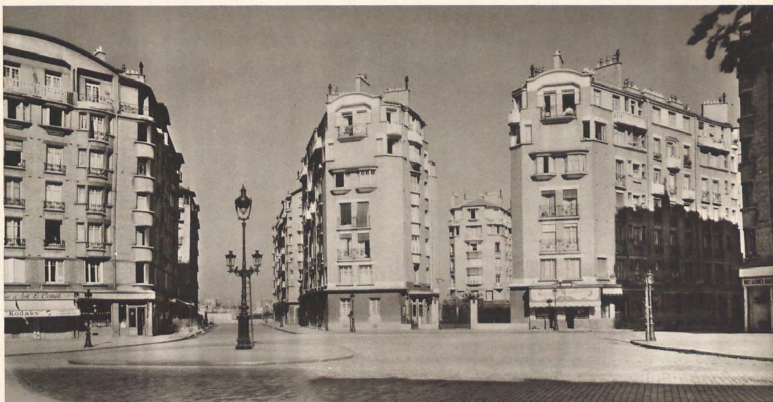
Carrefour du boulevard Ney et des rues Jean Varenne et Henri Brisson.
