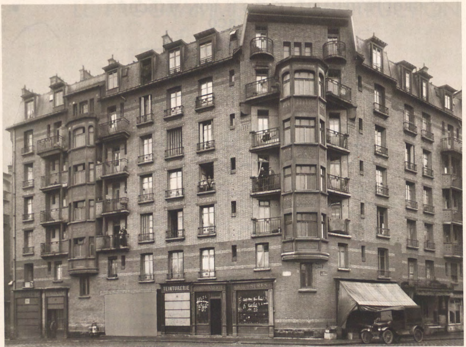
Façade sur les rues de l'Ourcq et de l'Oise.
