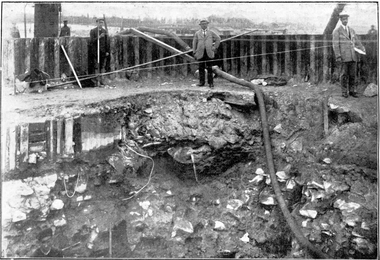
ILUSTR. 109. POMPOWANIE WODY Z GRODZY FILARU № 3.
