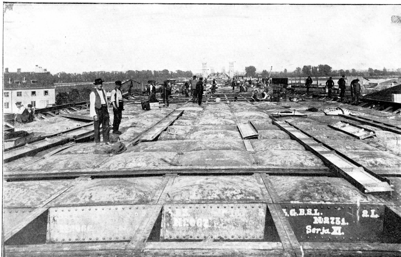
ILUSTR. 64. MONTAŻ BELECZEK PODŁUŻNYCH I POPRZECZNYCH WIADUKTU.
