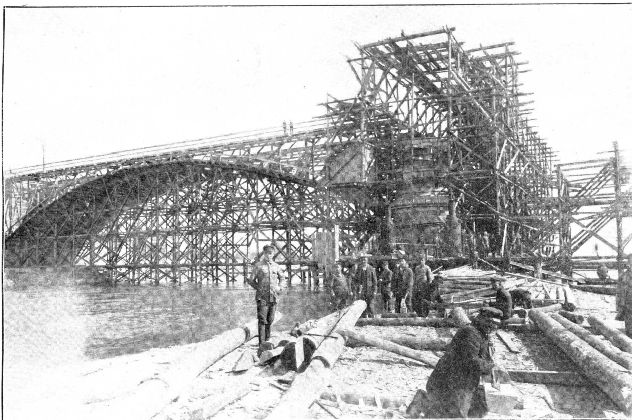
ILUSTR. 132. BUDOWA GÓRNYCH RUSZTOWAŃ.
