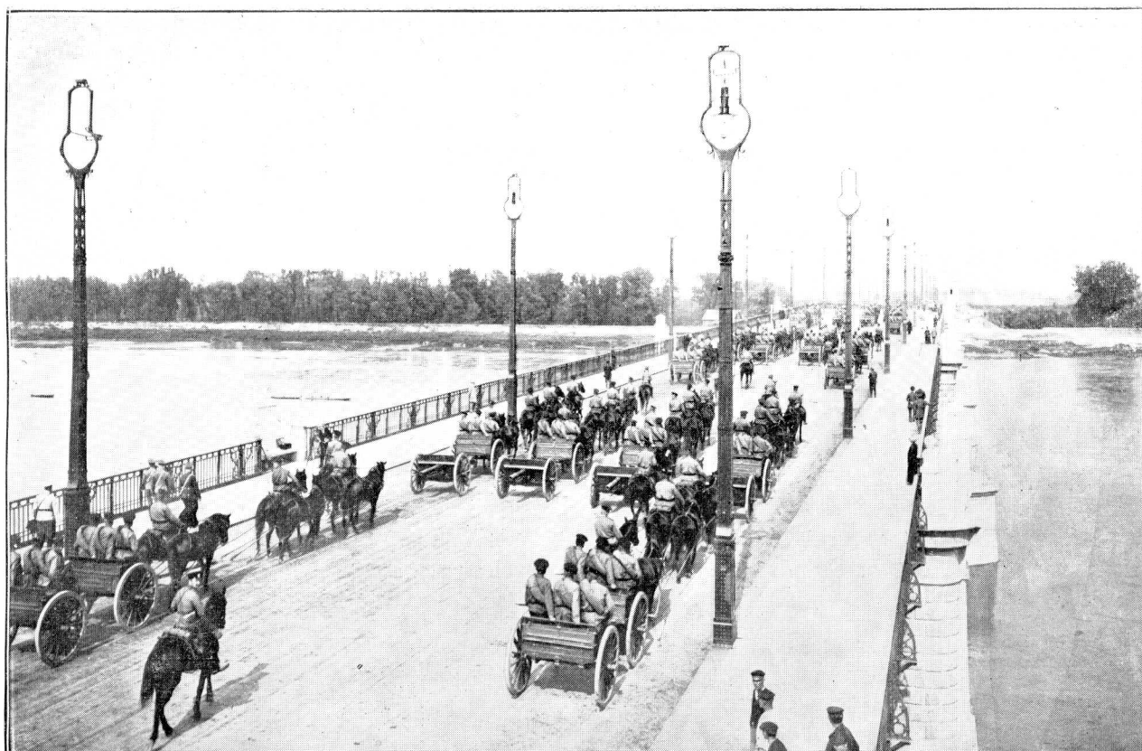
ILUSTR. 69. PRÓBA OBCIĄŻENIA MOSTU ARTYLERJĄ KONNĄ.
