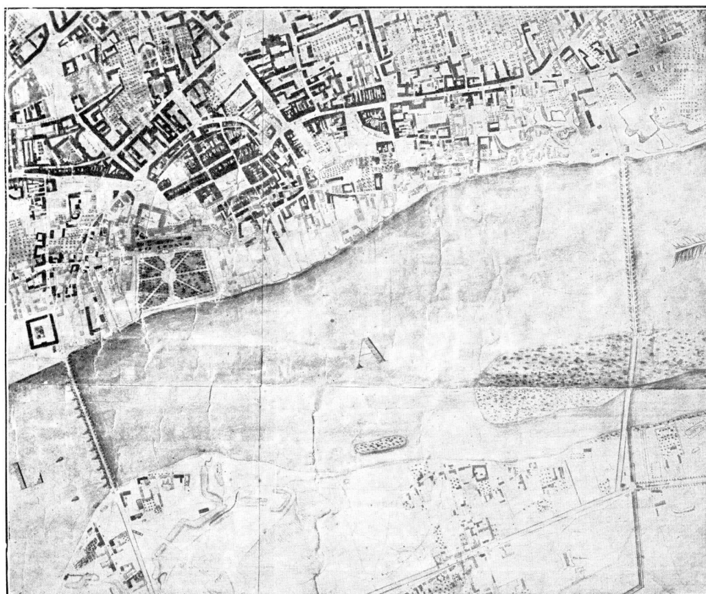
ILUSTR. 7. WIDOK MOSTU ŁYŻWOWEGO.
