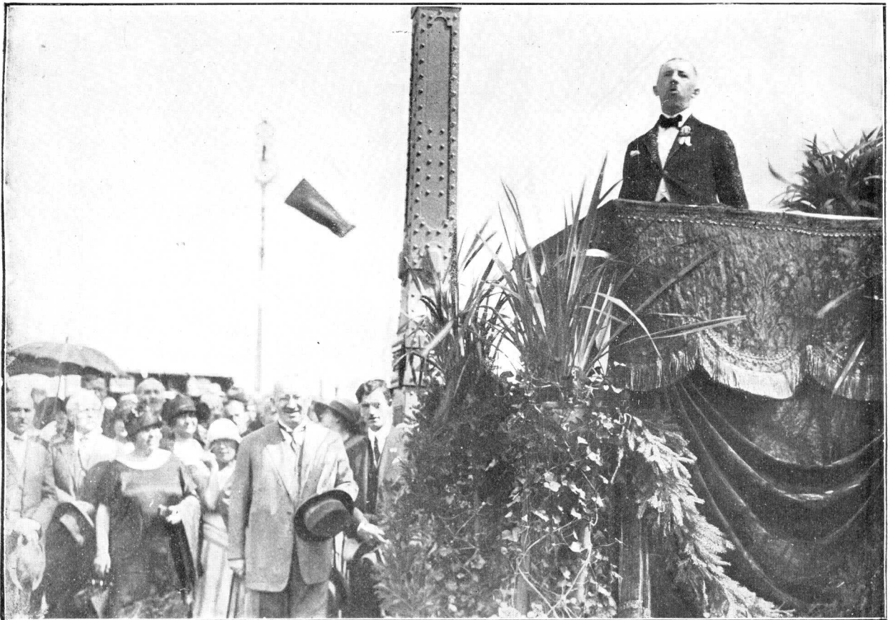
ILUSTR. 122. PRZEMÓWIENIE KIEROWNIKA ODBUDOWY MOSTU INŻ. B. PLEBIŃSKIEGO.
