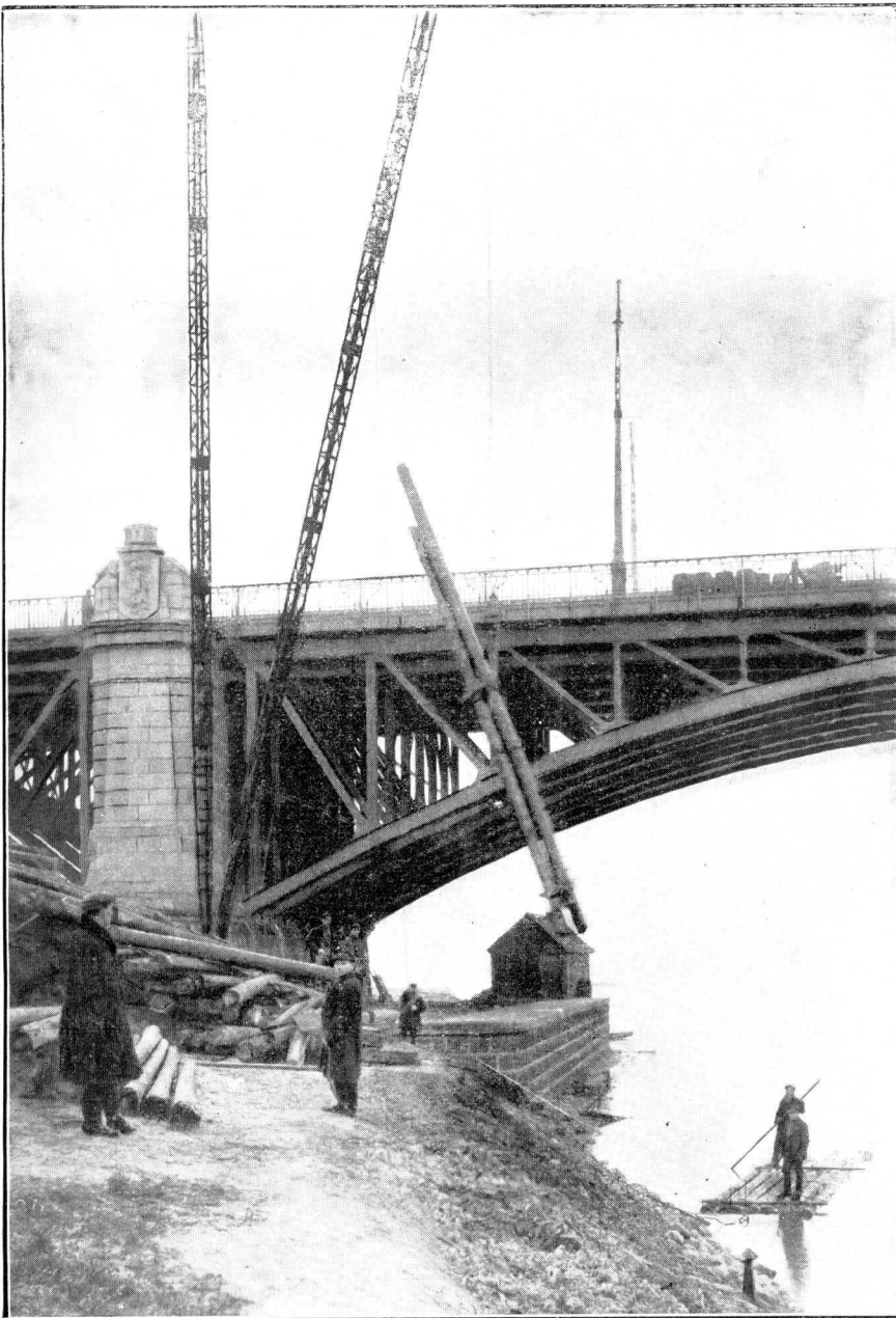
ILUSTR. 154. ROZBIÓRKA RUSZTOWAŃ I WYCIĄGANIE PALI ŻÓRAWIEM NA BRZEG.
