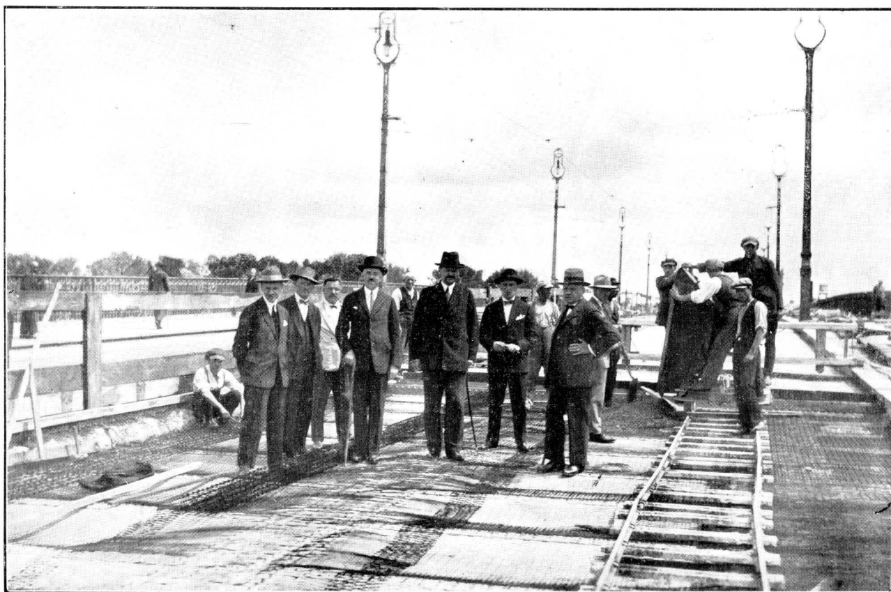
ILUSTR. 170. UKŁADANIE SIATKI I BELEK ŻELAZOBETONOWYCH POD SZYNY TRAMWAJOWE W OBECNOŚCI CZŁONKA KOMISJI TECHNICZNEJ INŻ. ST. KALINOWSKIEGO ORAZ PERSONELU KIEROWNICTWA
