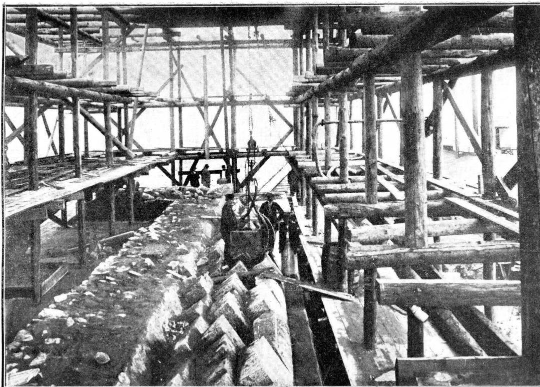
ILUSTR. 28. UKŁADANIE PRZEKŁADNIKÓW GRANITOWYCH POCHYŁYCH NA FILARZE.
