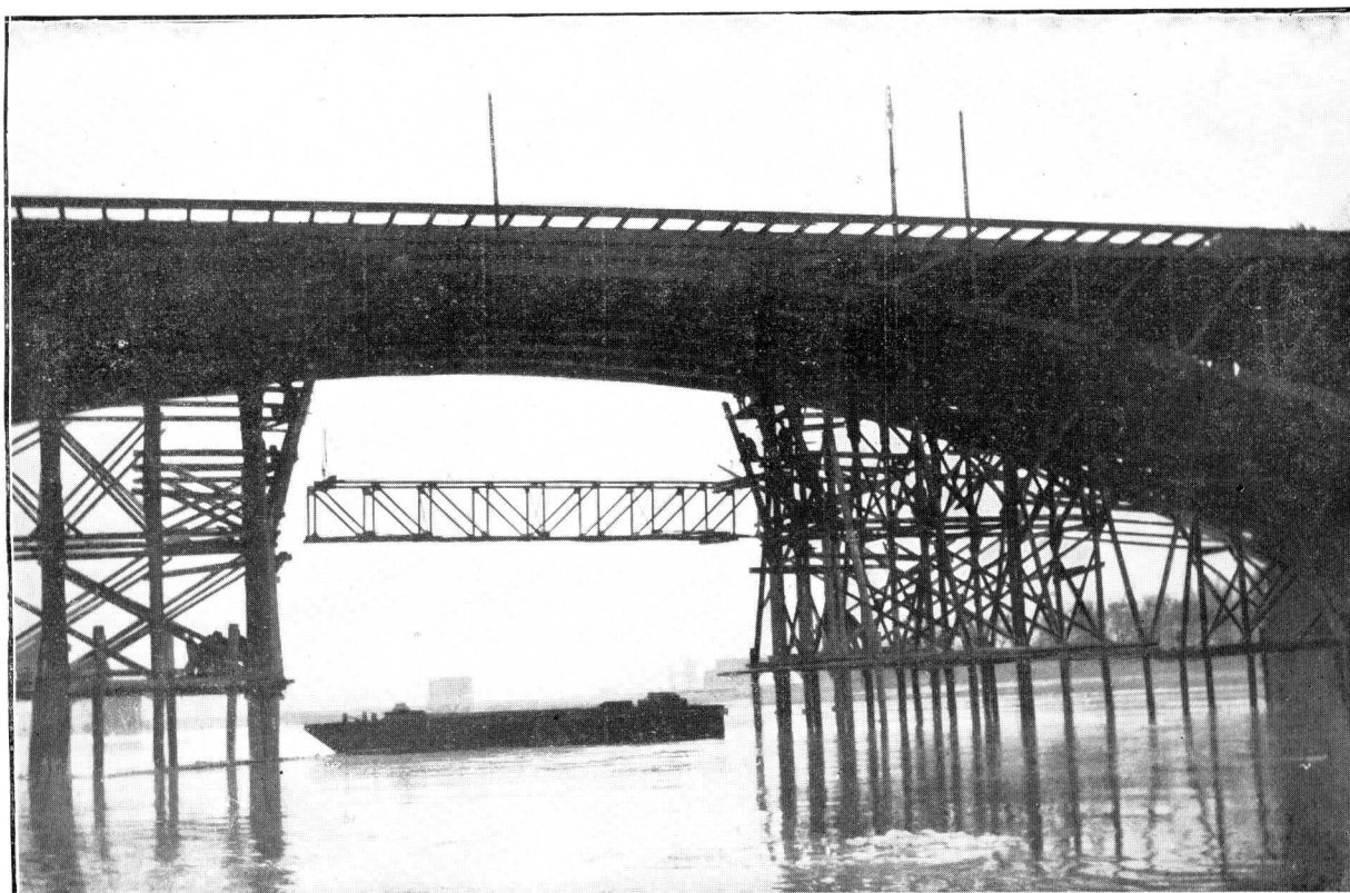
ILUSTR. 155. OPUSZCZANIE PRZĘSELKA ŻELAZNEGO Z RUSZTOWAŃ PRZĘSŁA № 4.
