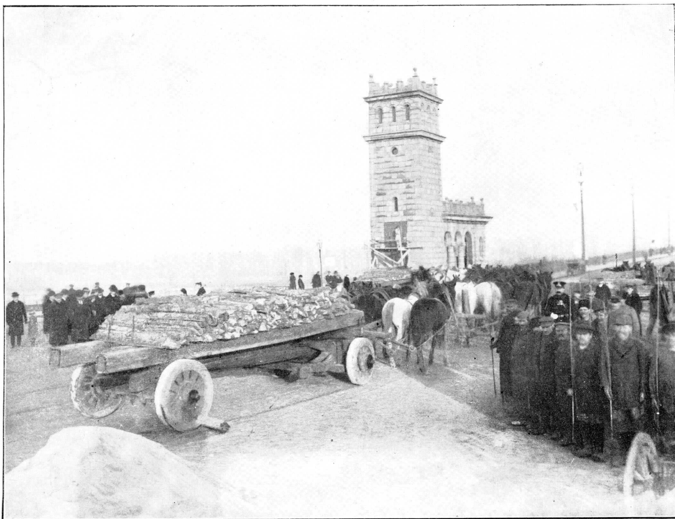
ILUSTR. 68. PRÓBA OBCIĄŻENIA MOSTU WOZAMI ŁADOWNYMI.
