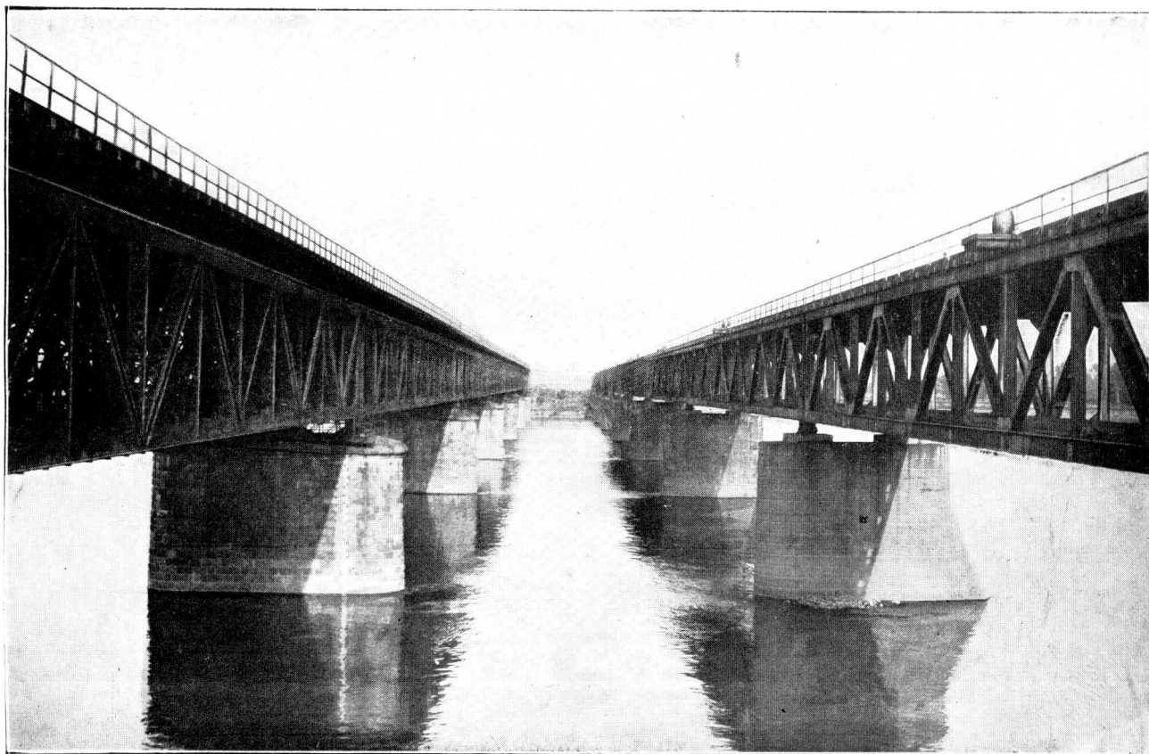
ILUSTR. 12. WIDOK OBYDWU MOSTÓW KOLEJOWYCH POD CYTADELĄ.
