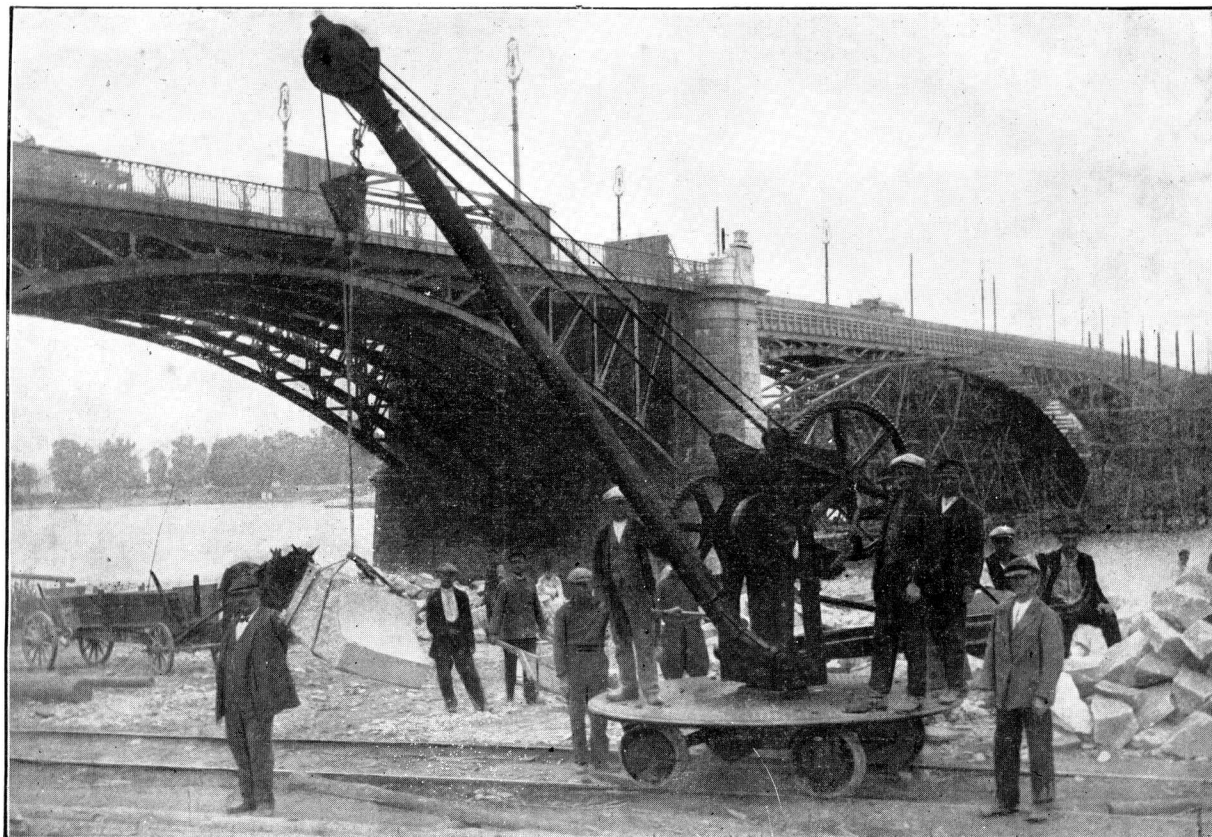
ILUSTR. 166. MOMENT PODNOSZENIA CIOSU GRANITOWEGO PRZY POMOCY DŹWIGU MECHANICZNEGO.
