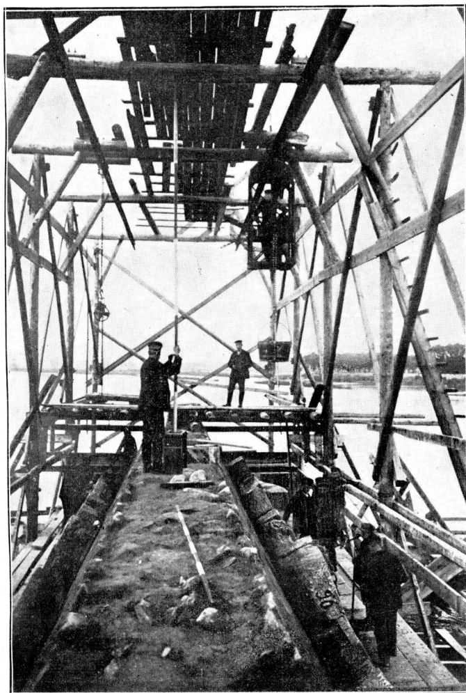
ILUSTR. 29. MUROWANIE FILARÓW.
