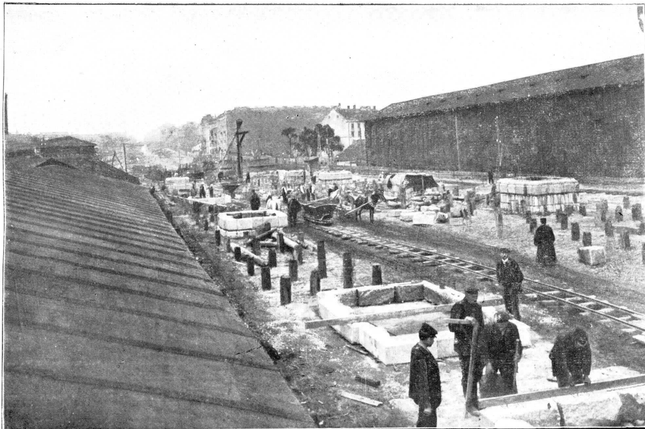
ILUSTR. 54. BUDOWA FUNDAMENTÓW FILARÓW WIADUKTU.
