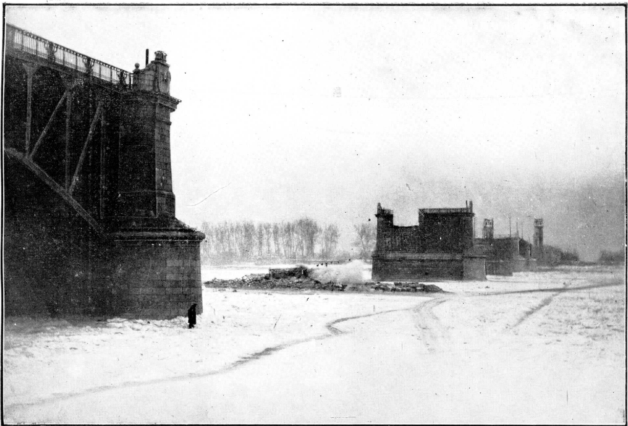
ILUSTR. 108. WYSADZANIE W POWIETRZE RUMOWISK FILARU № 5.
