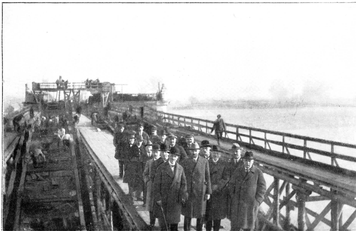
ILUSTR. 152'. INSPEKCJA ROBÓT MONTAŻOWYCH.
