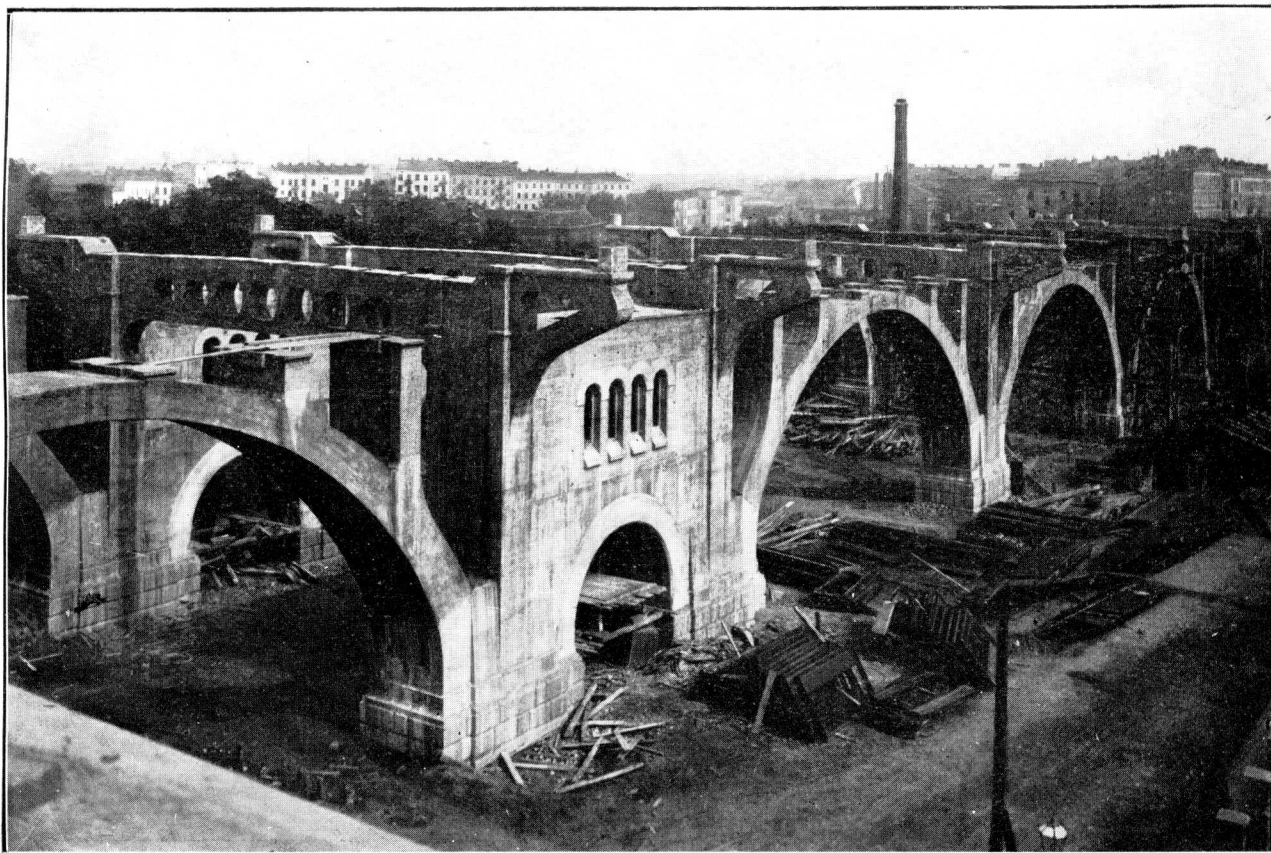
ILUSTR. 62. FILARY PRZYCZÓLKÓW I BELKI ARKADOWE WIADUKTU.
