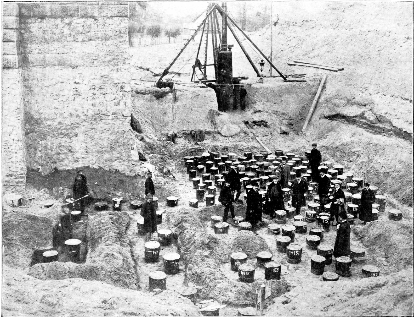
ILUSTR. 37. PALE BETONOWE „STERNA”.
