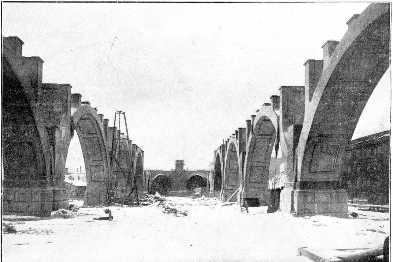
ILUSTR. 61. WIDOK GOTÓWYCH ŁUKÓW ŻELAZOBETONOWYCH WIADUKTU.
