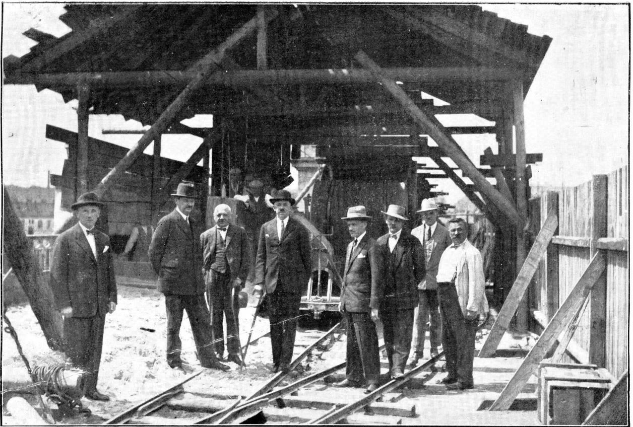
ILUSTR. 171. PRACA MIESZARKI (BETONIERKI) BĘBNOWEJ.
