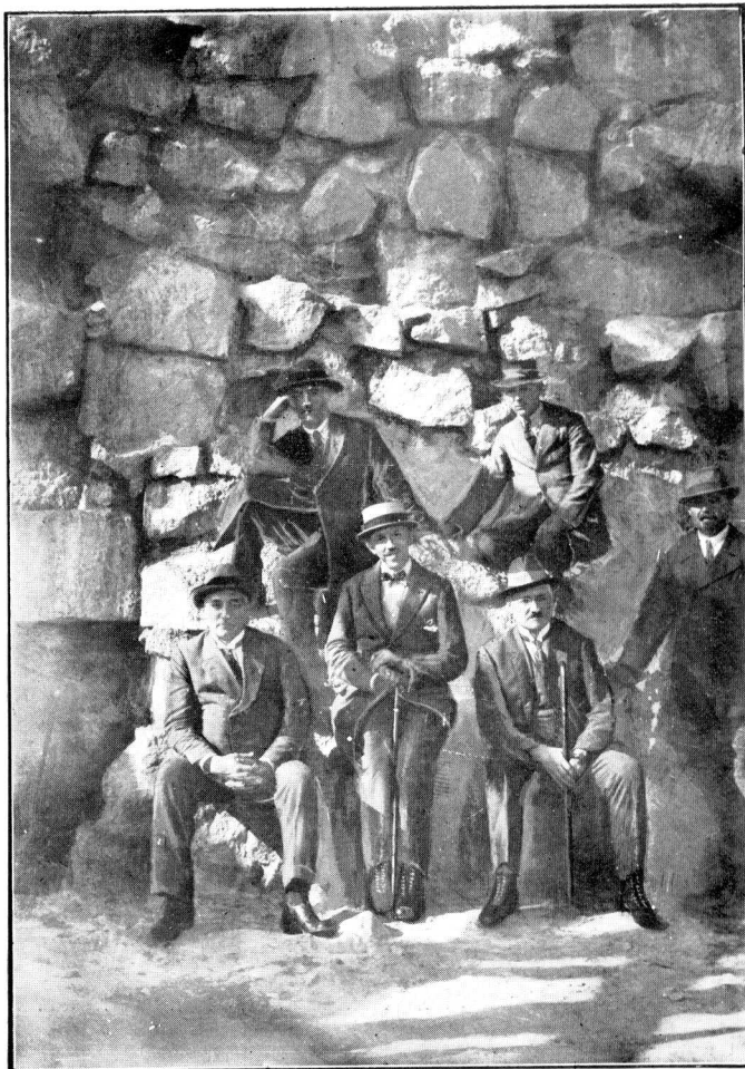
ILUSTR. 174. INSPEKCJA ROBÓT PRZEZ PREZYDENTA MIASTA WŁ. JABŁOŃSKIEGO PRZY ODBUDOWIE FILARU № 5.
