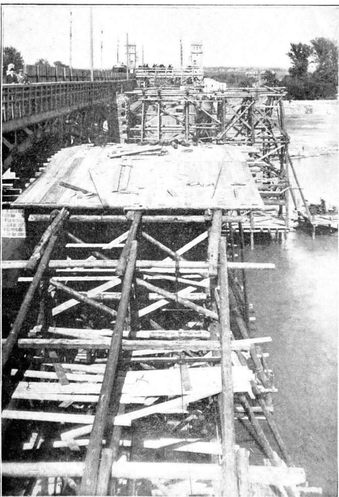
ILUSTR. 131. USTAWIANIE POMOSTU PARABOLICZNEGO RUSZTOWAŃ.
