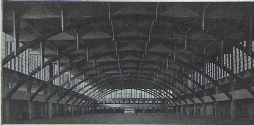
Messehalle in Gelsenkirchen → Ansicht des Gerippes
