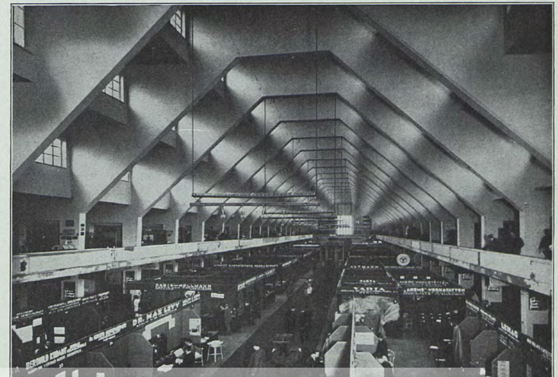
Radiohalle Berlin — Innenansicht der verkleideten und verputzten Halle
