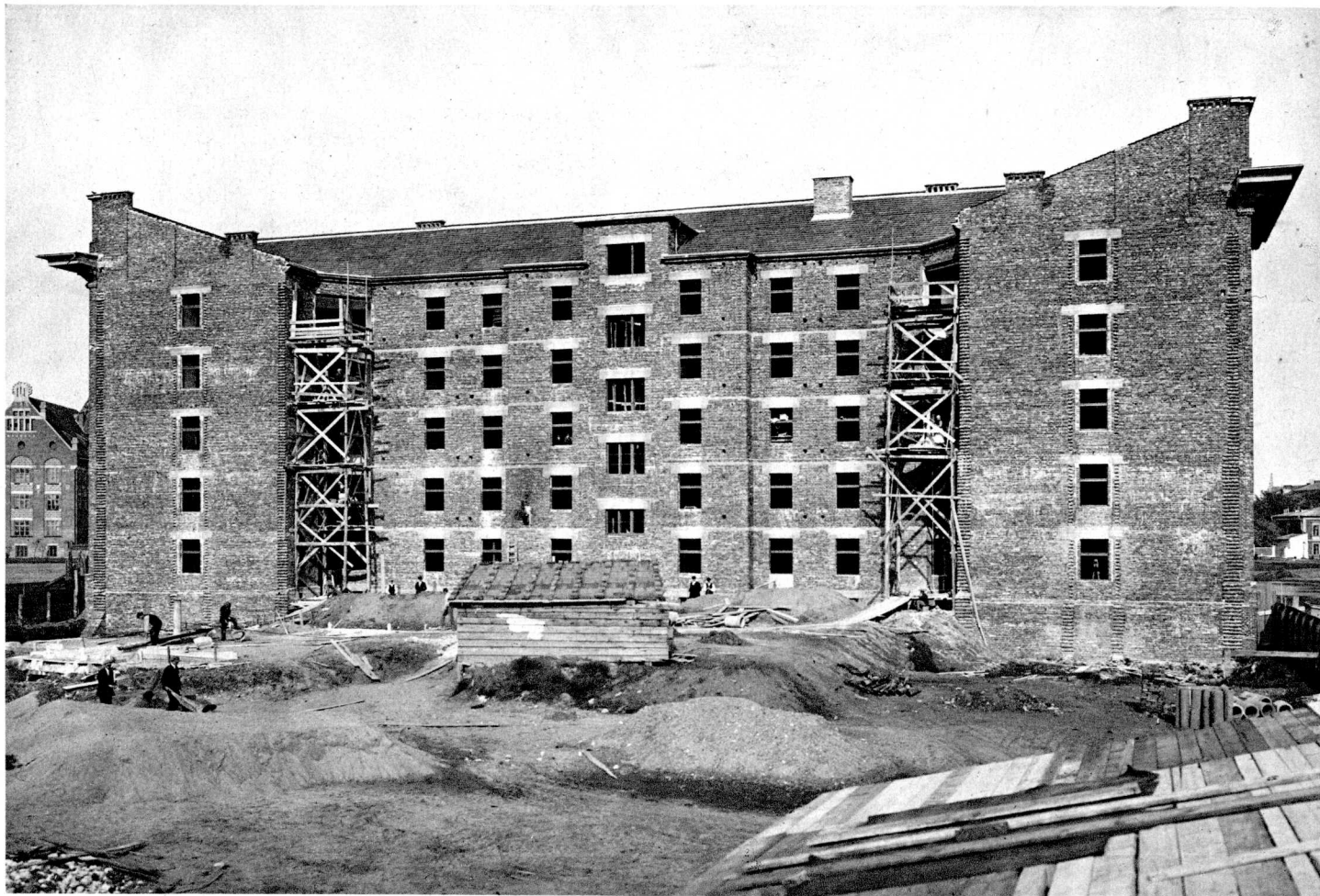
Budowa II Domu Akademickiego: Stan budowy w grudniu 1925.
