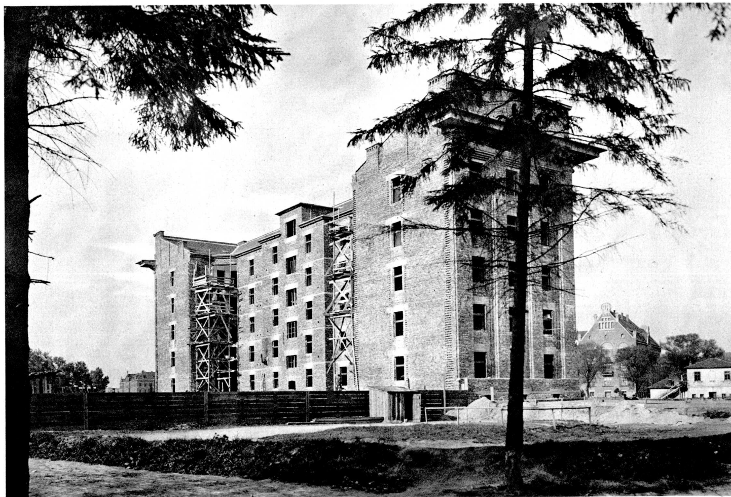
Budowa II Domu Akademickiego: Skrzydło wschodnie od strony południowo-zachodniej.
