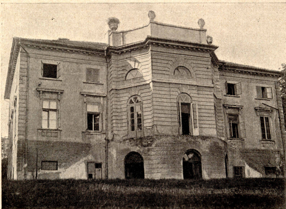
Fig. 20. PAŁAC W IGOŁOMJI. Widok od strony ogrodu.
