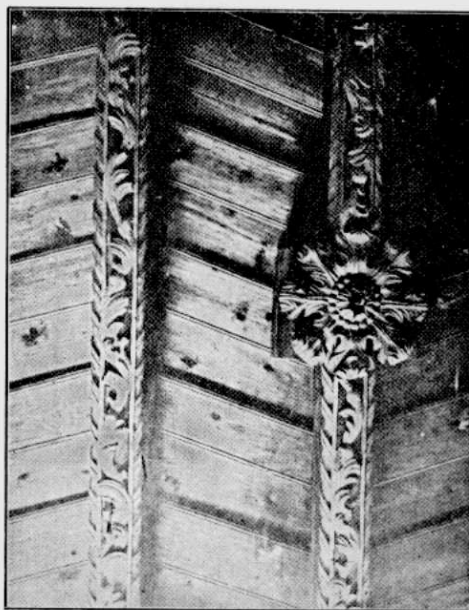
Fig. 24. Rogów. Dwór, szczegół stropu w pokoju nr. 3.
