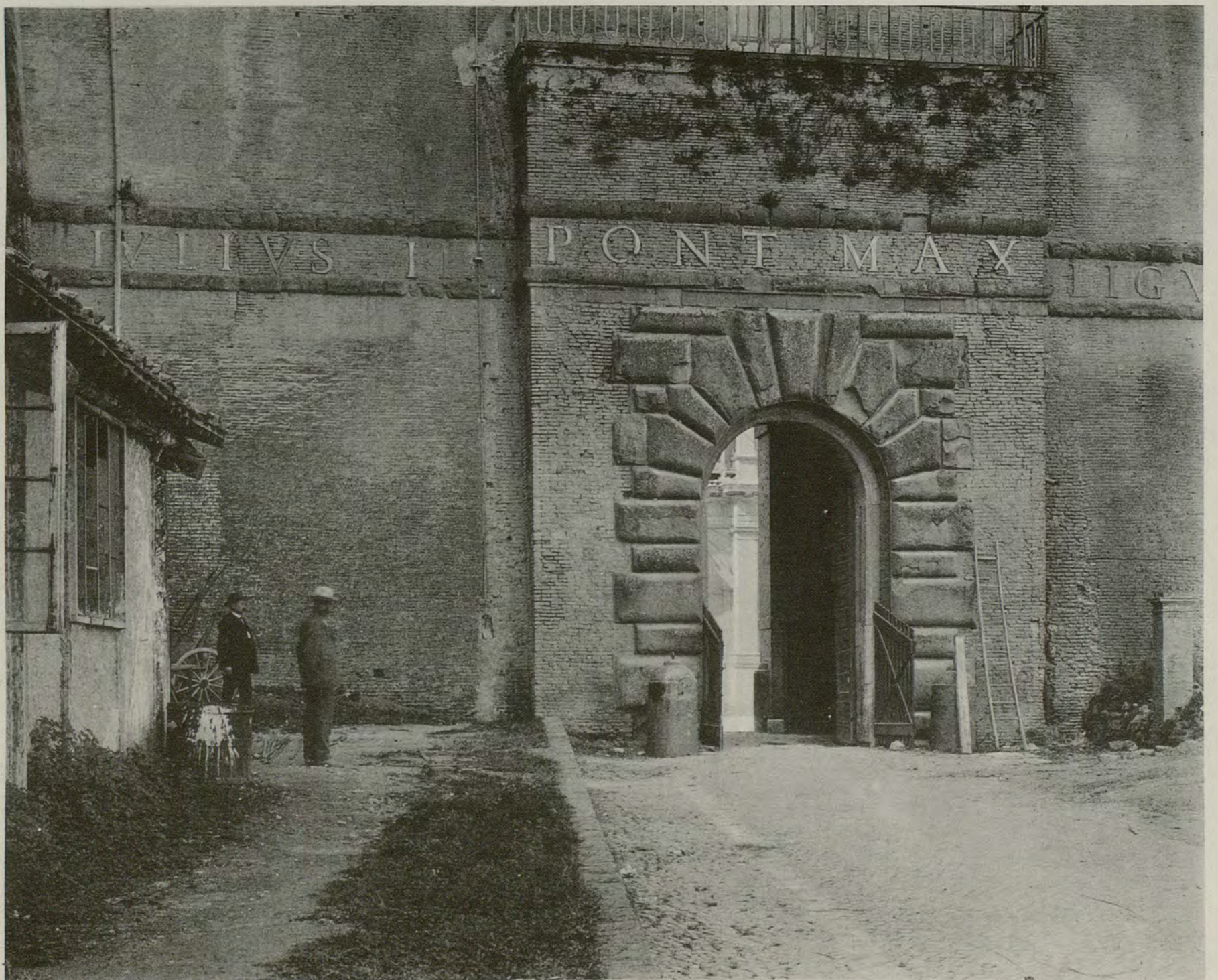
2 Tor des Ostflügels in Rustika, mittlerer Zugang zum ehemaligen Turnierhofe.
