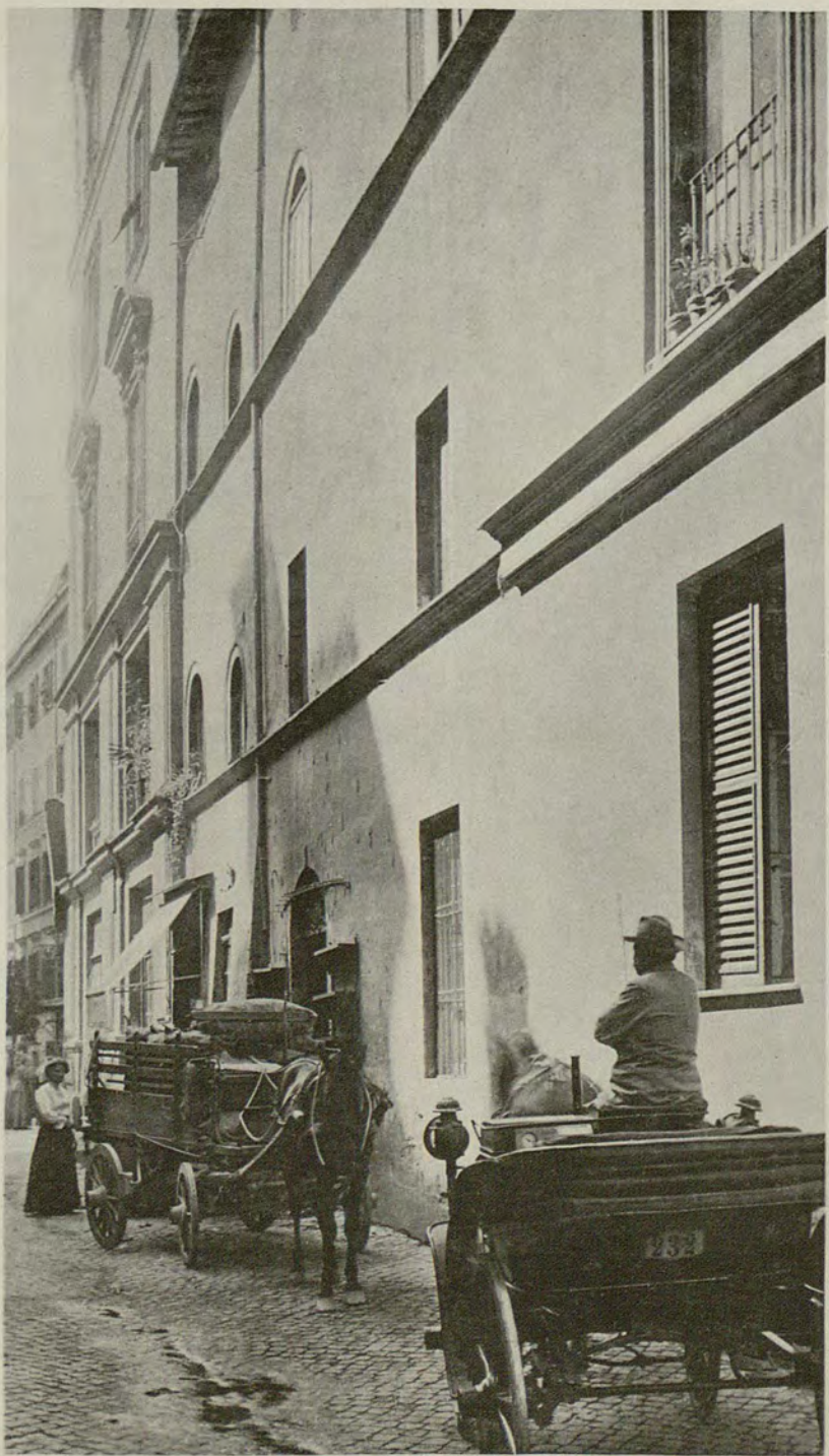
3 Vierfensterhaus im Vicolo del Campanile Nr. 4 und 5.
