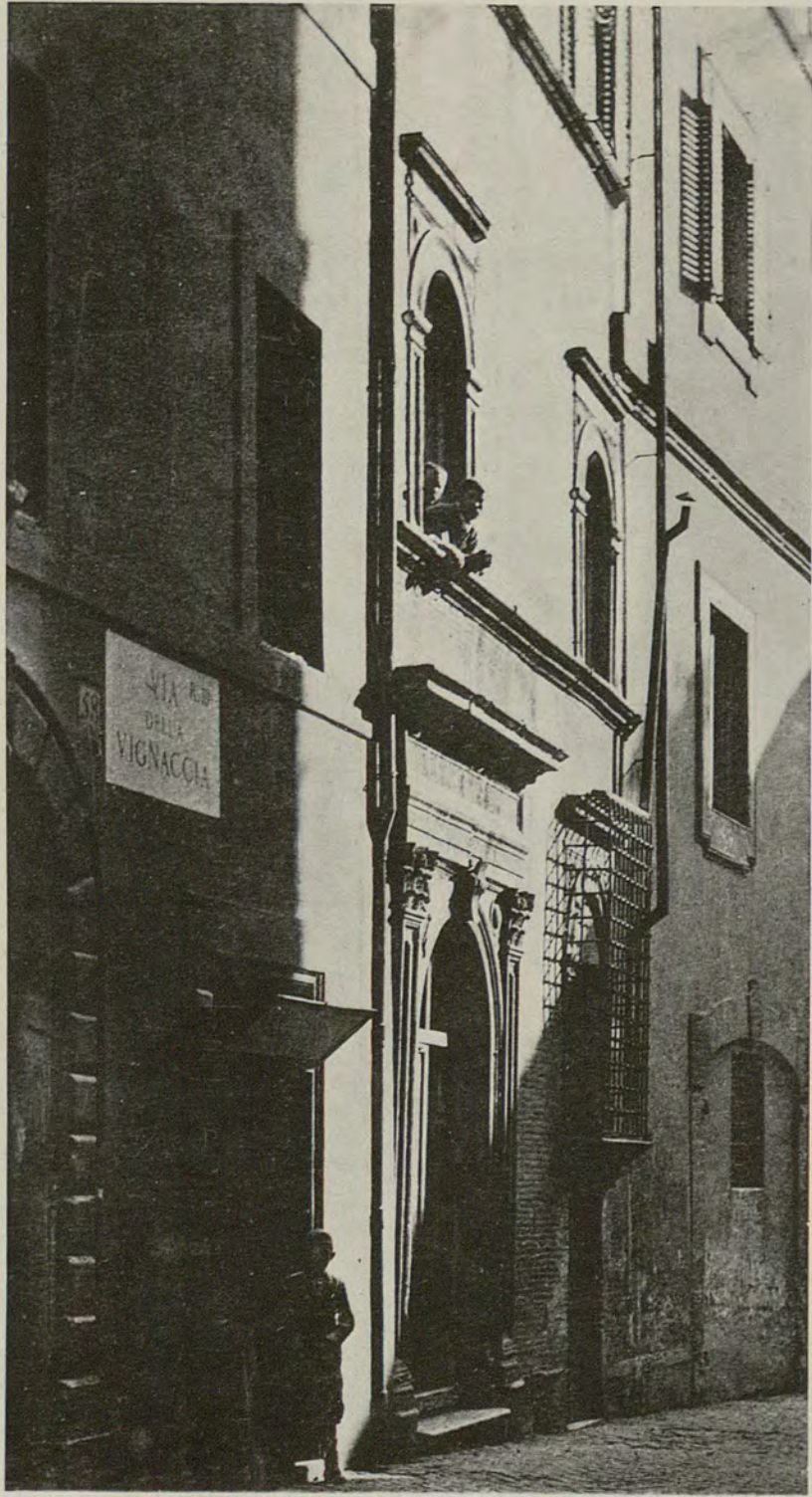
1 Zweifensterhaus in Via della Vignaccia Nr. 60 und 60 A.
