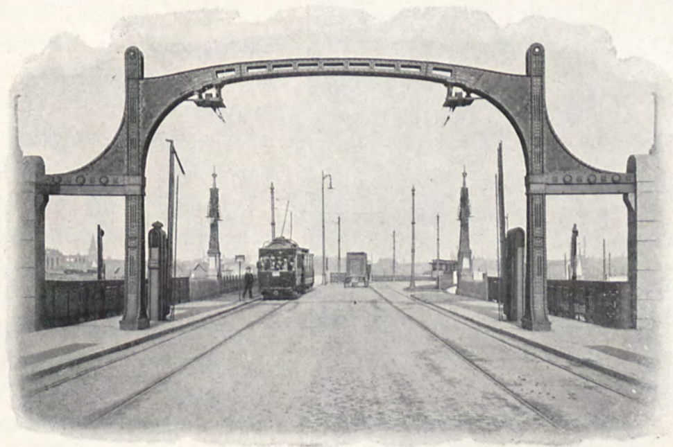
Portal über dem Klappbrücken-Keller.
