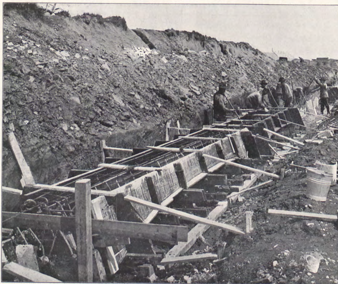
Herstellung des Holmes der Eisenbeton-Uferbefestigung.
