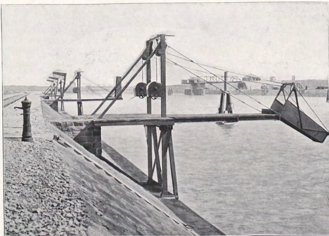
Kohlenladebühne in Betriebsstellung.
