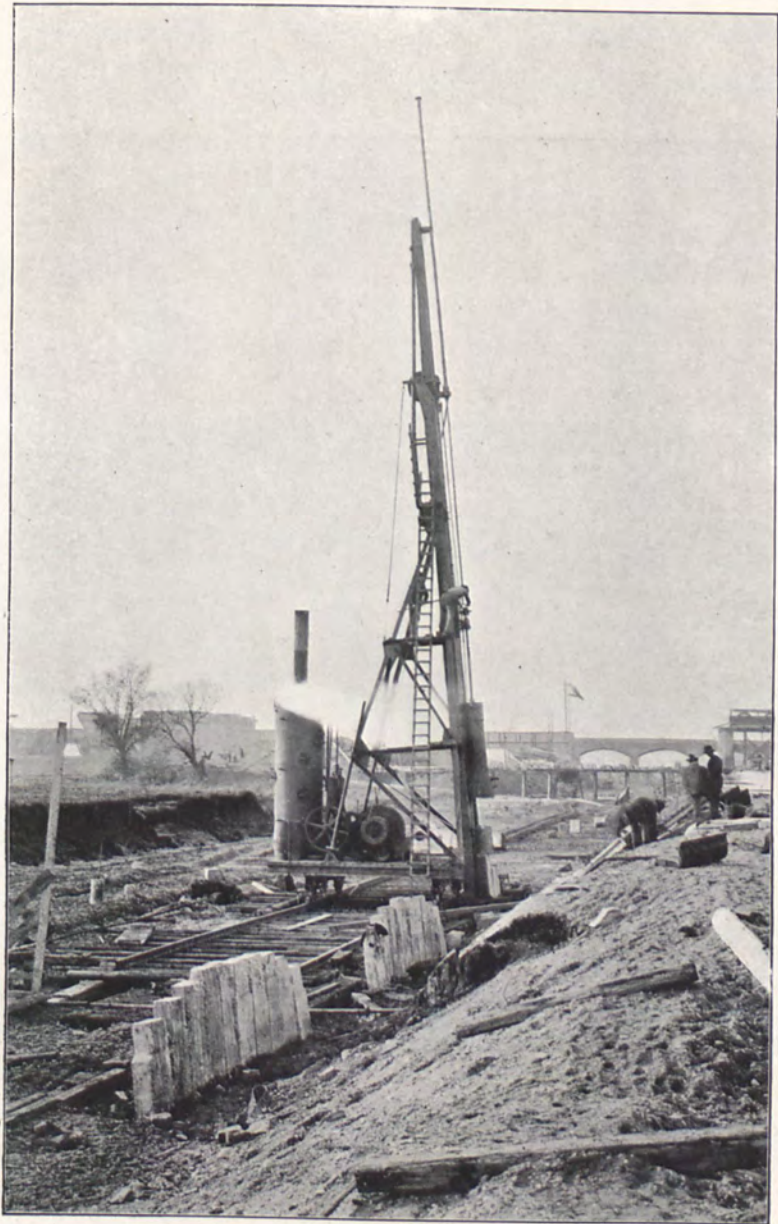
Einrammen der Eisenbeton-Spundwand der Kaimauer.
