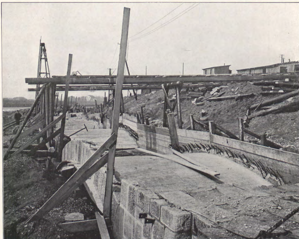
Die Eisenbeton-Spundwand der Kaimauer.
