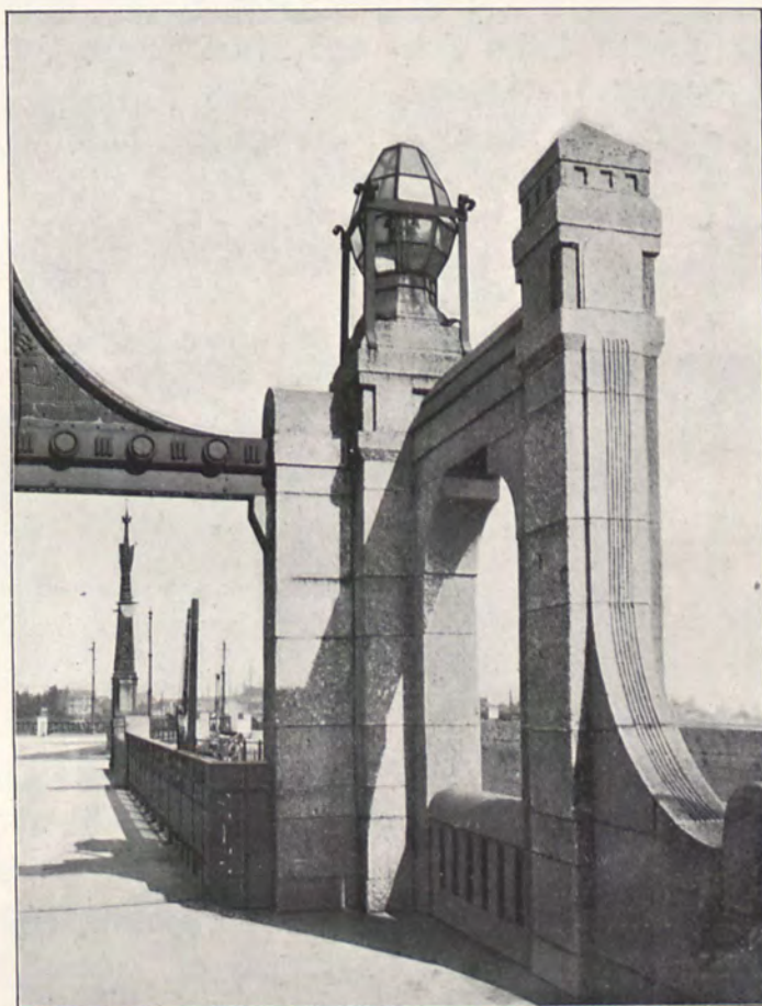
Granitaufbau an den Klappbrücken.
