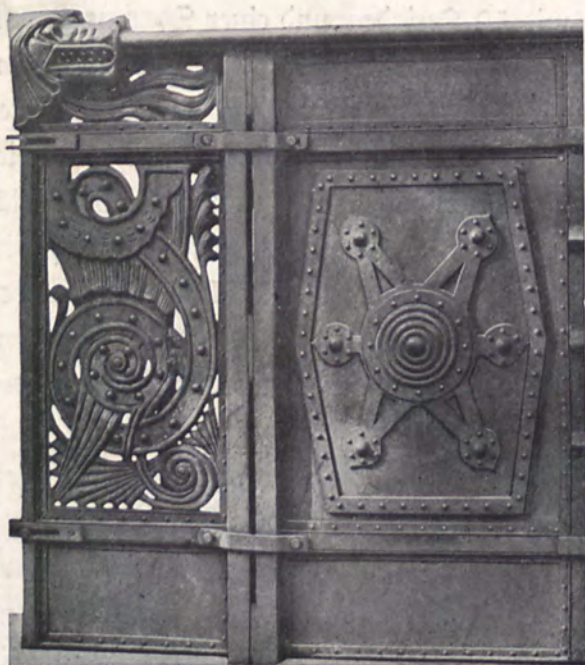
Geländer der Ruhrbrücke.
