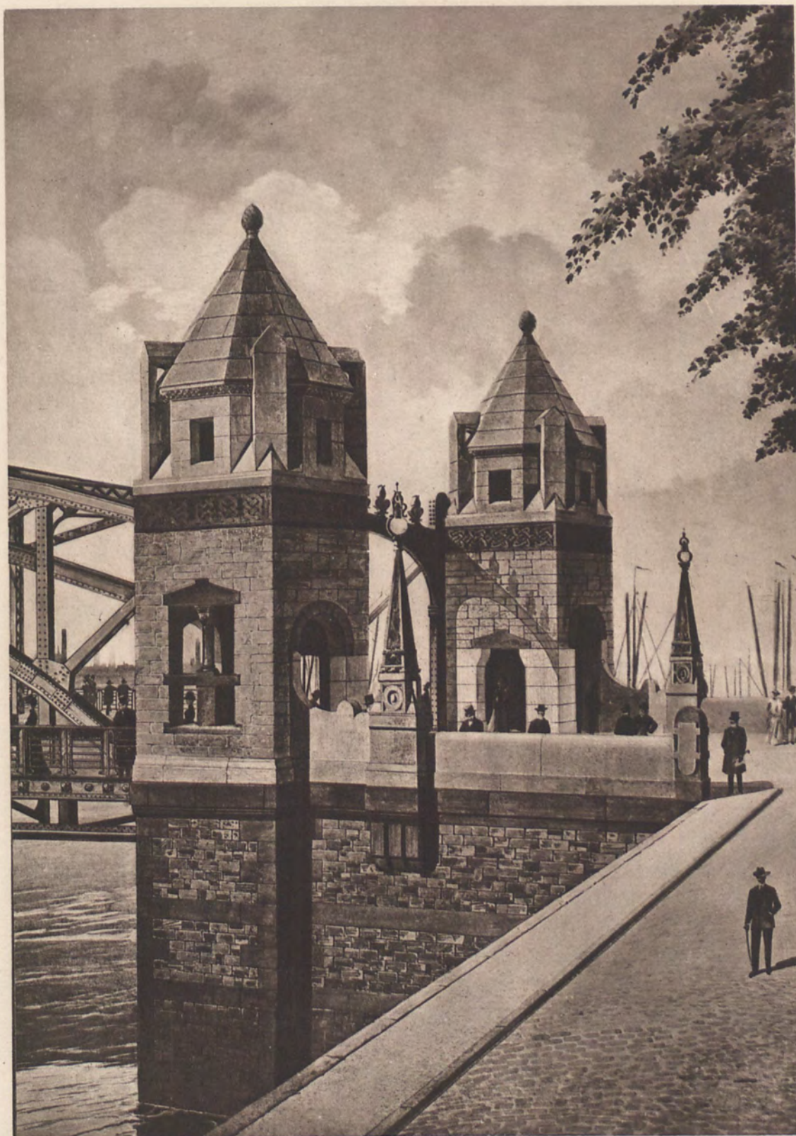
Nordpfeiler der Ruhrbrücke.
