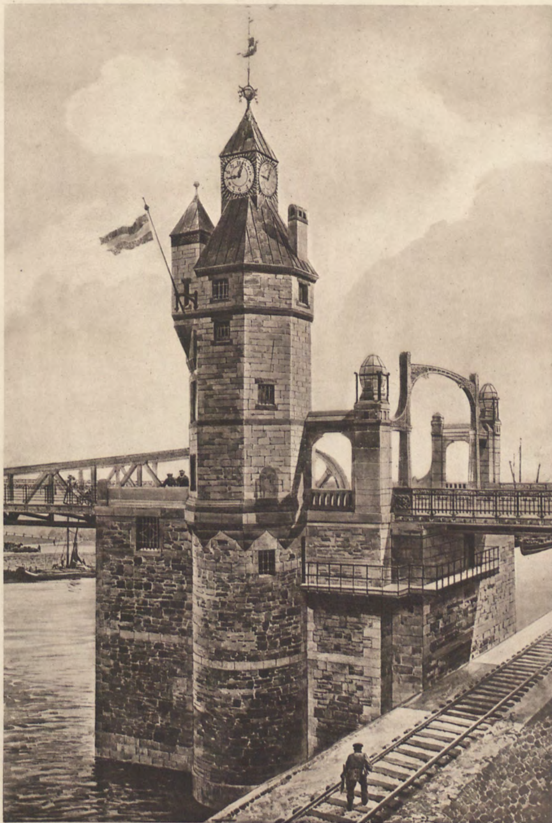
Klappbrücken-Pfeiler des Hafenkanals.
