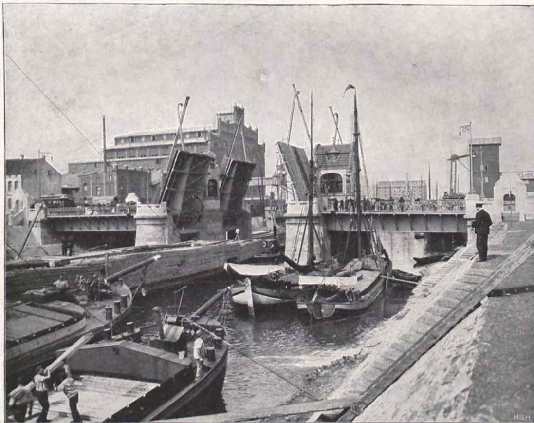
Schwanentorbrücke des Innenhafens.
