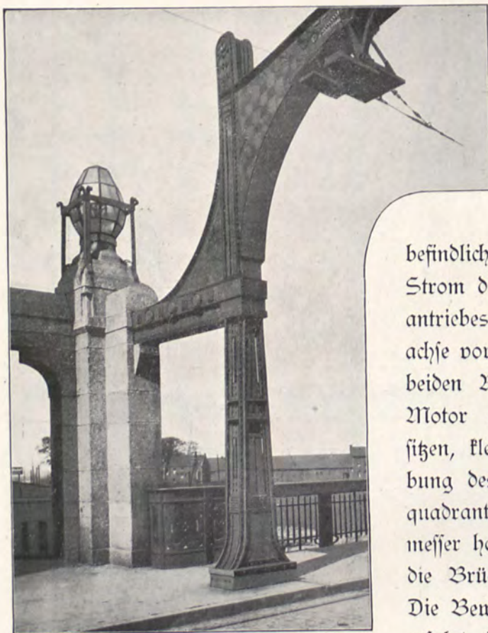
Aufbau über dem Klappbrücken-Keller.
