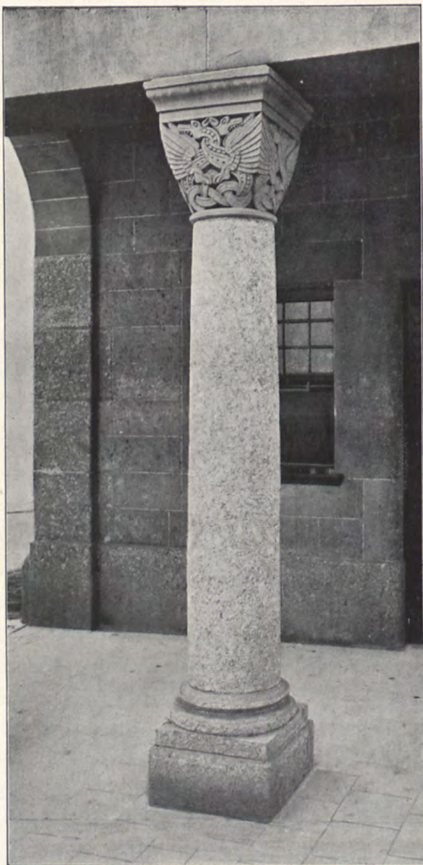
Eingang zum Brückenwärter-Häuschen.
