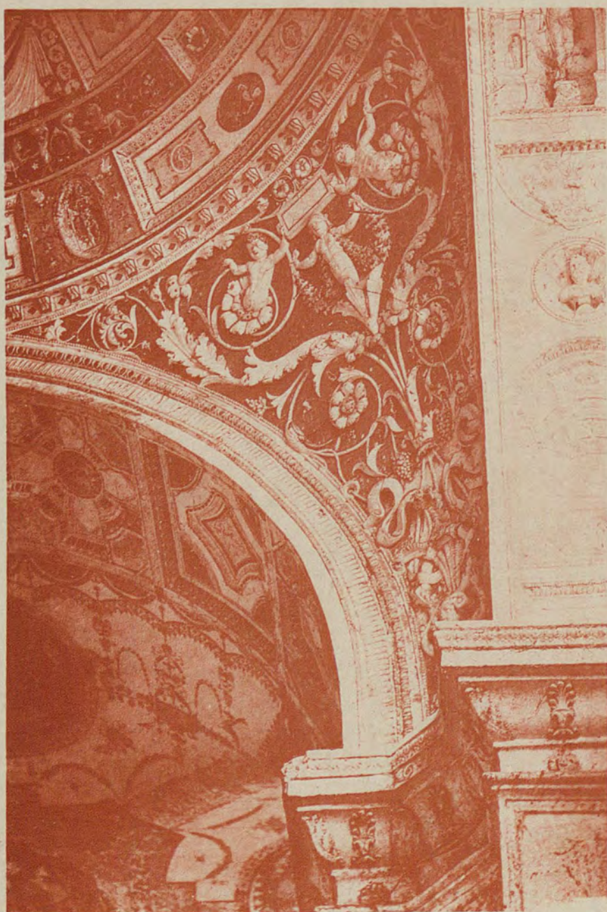
Nordwestlicher Kuppelzwickel der Mittelhalle.
