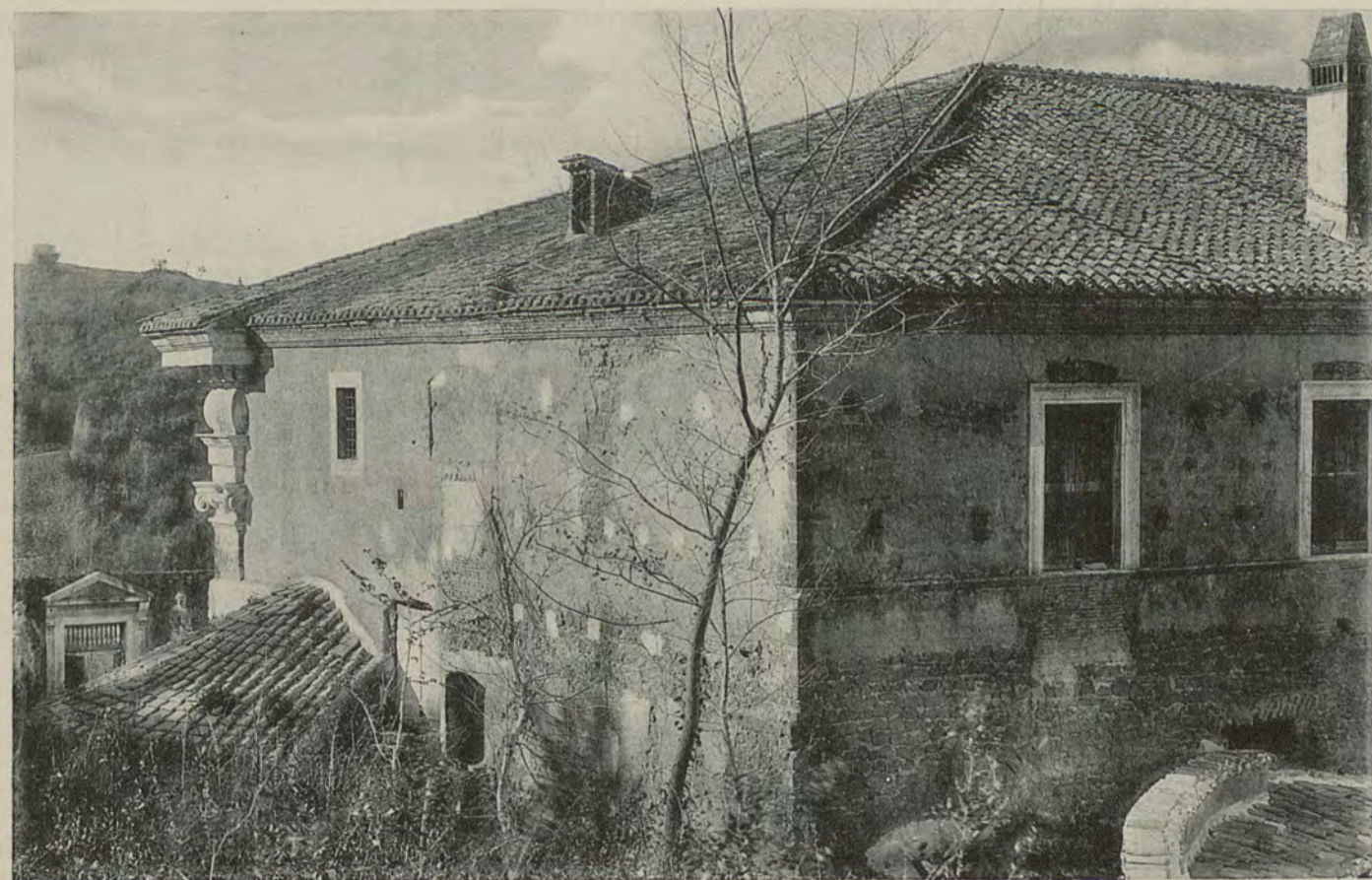
Die Villa von Südwesten.
