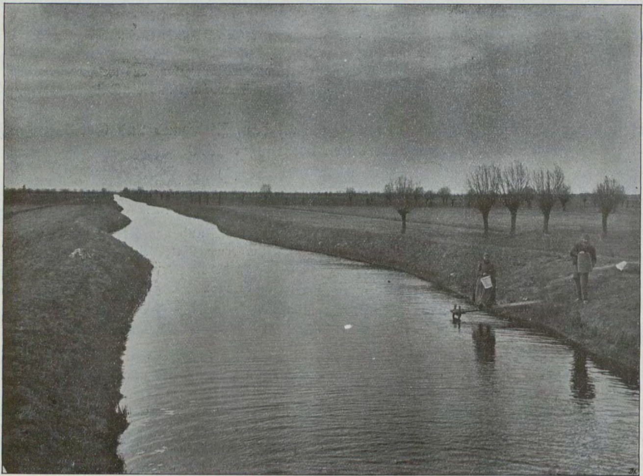
Blick auf die alte oder leege Vorflut von der Geschworenbrücke am Scheerkrug aus gesehen, ein typischer, künstlich hergestellter Entwässerungskanal.
