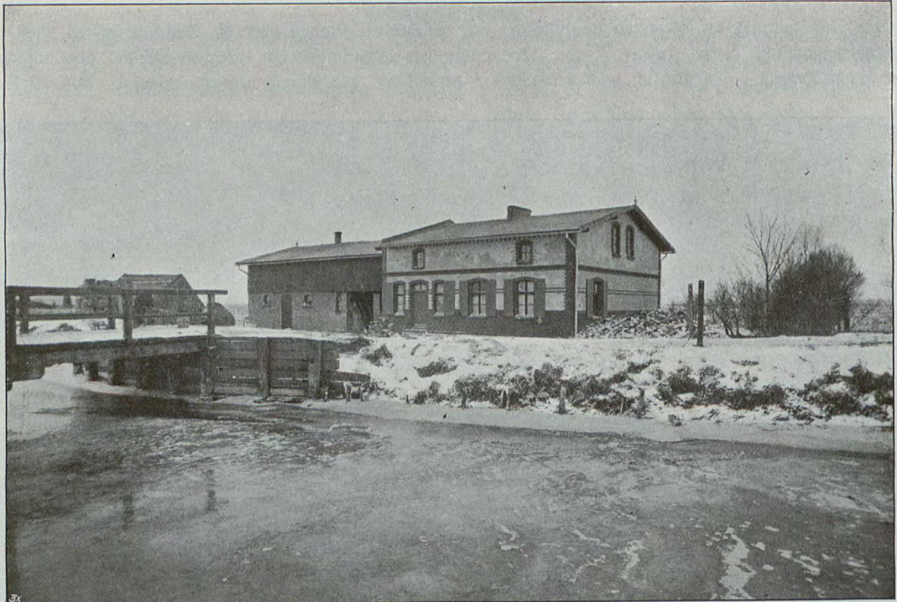
Das im Jahre 1905 neuerbaute Dammauffsehergehöft an der Cladau.
