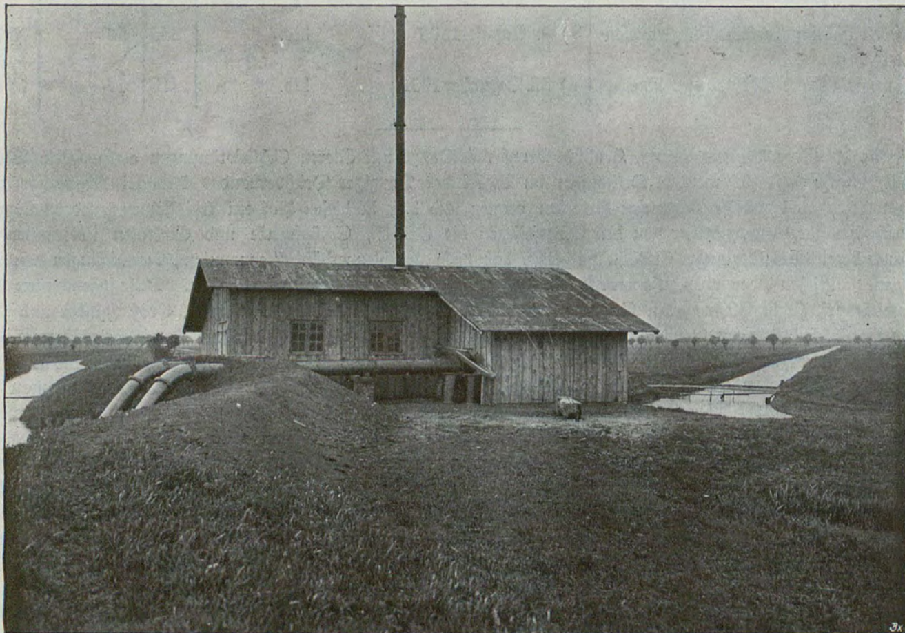
Das im Winter 1906/07 neu erbaute Dampfschöpfwerk für Großzünder, links der leere Schlickgeschworenengraben, rechts der tiefliegende Polder Großzünder mit dem Hauptentwässerungsgraben.
