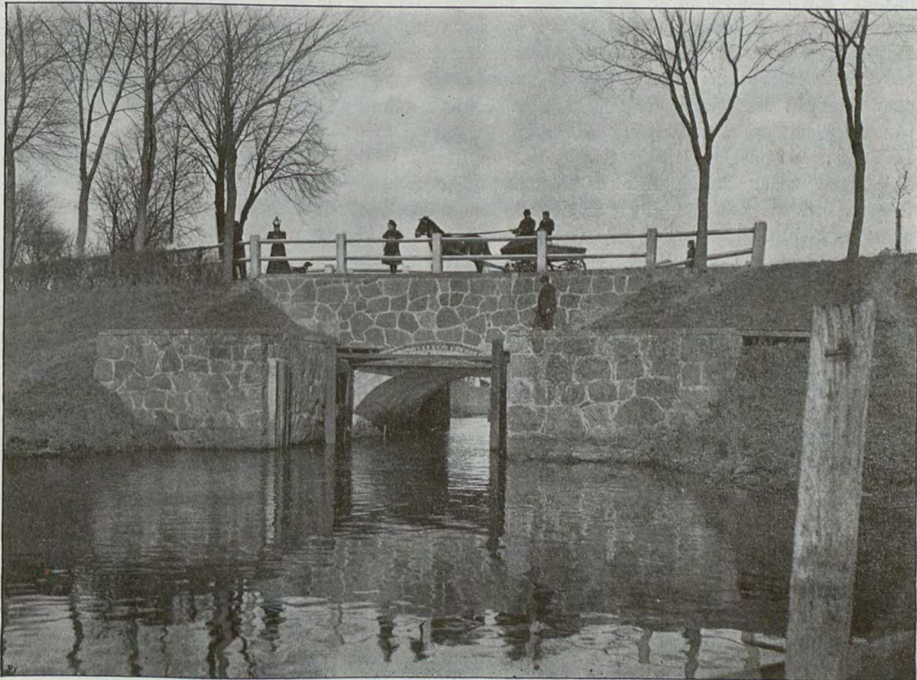
Die Rückforter Dammschleuse.
