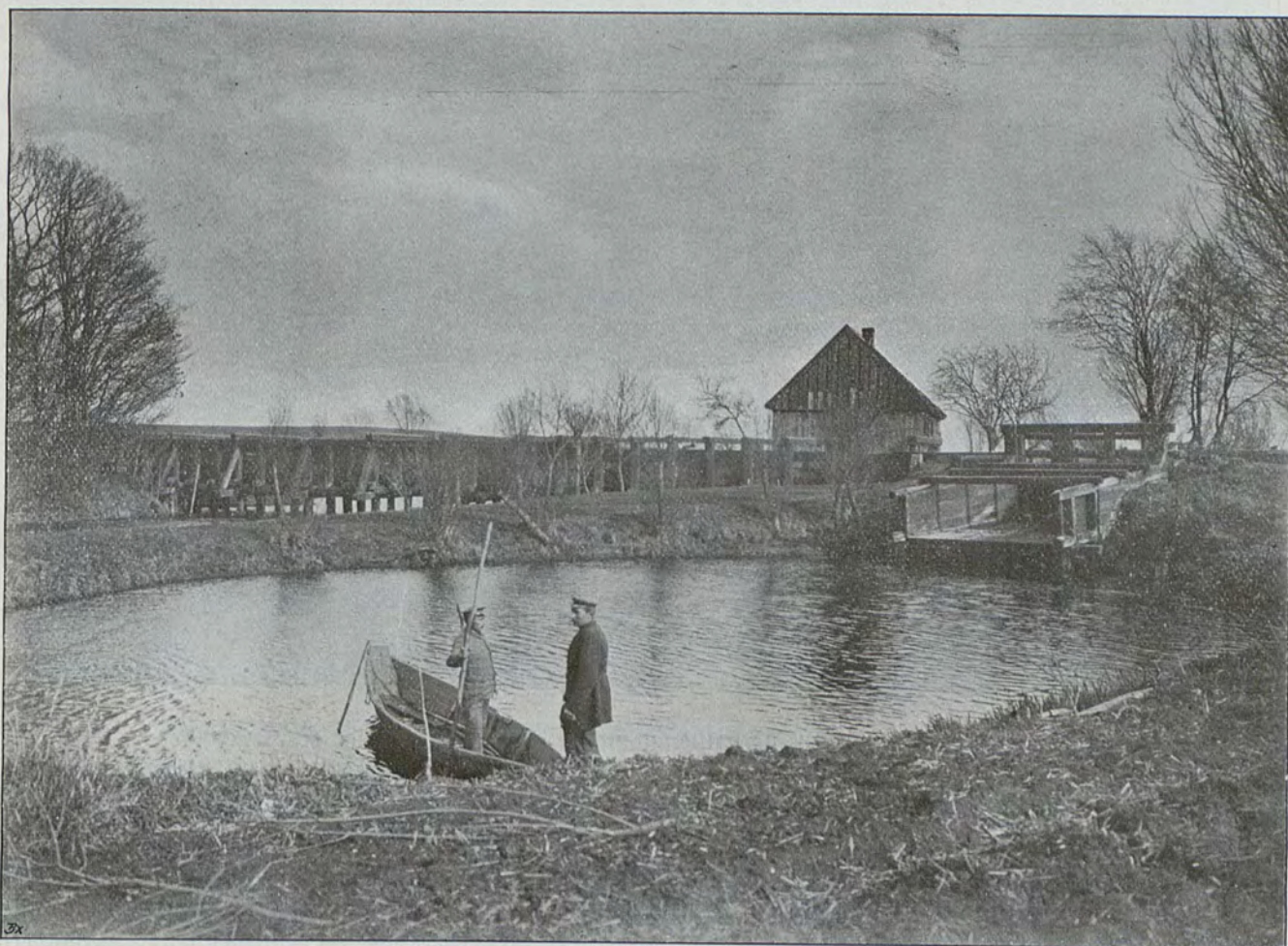
Die sogenannte „Riedwand“ bei Herrengrebin, eine hölzerne Kanalbrücke, auf welcher die Kladau über die Mottlau geführt wird. (Links die Riedwand, rechts die Freischleufe, daneben das dem Deichverband gehörende Schleusenmeisterwohnhaus.)
