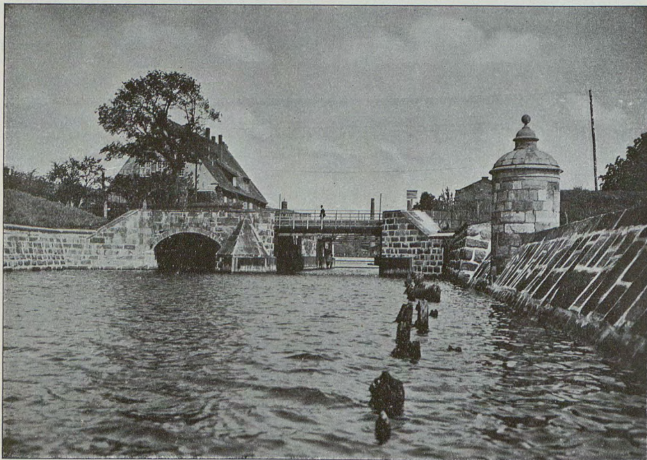
Die Steinschleuse, eine der beiden Mottlauausmündungen.
