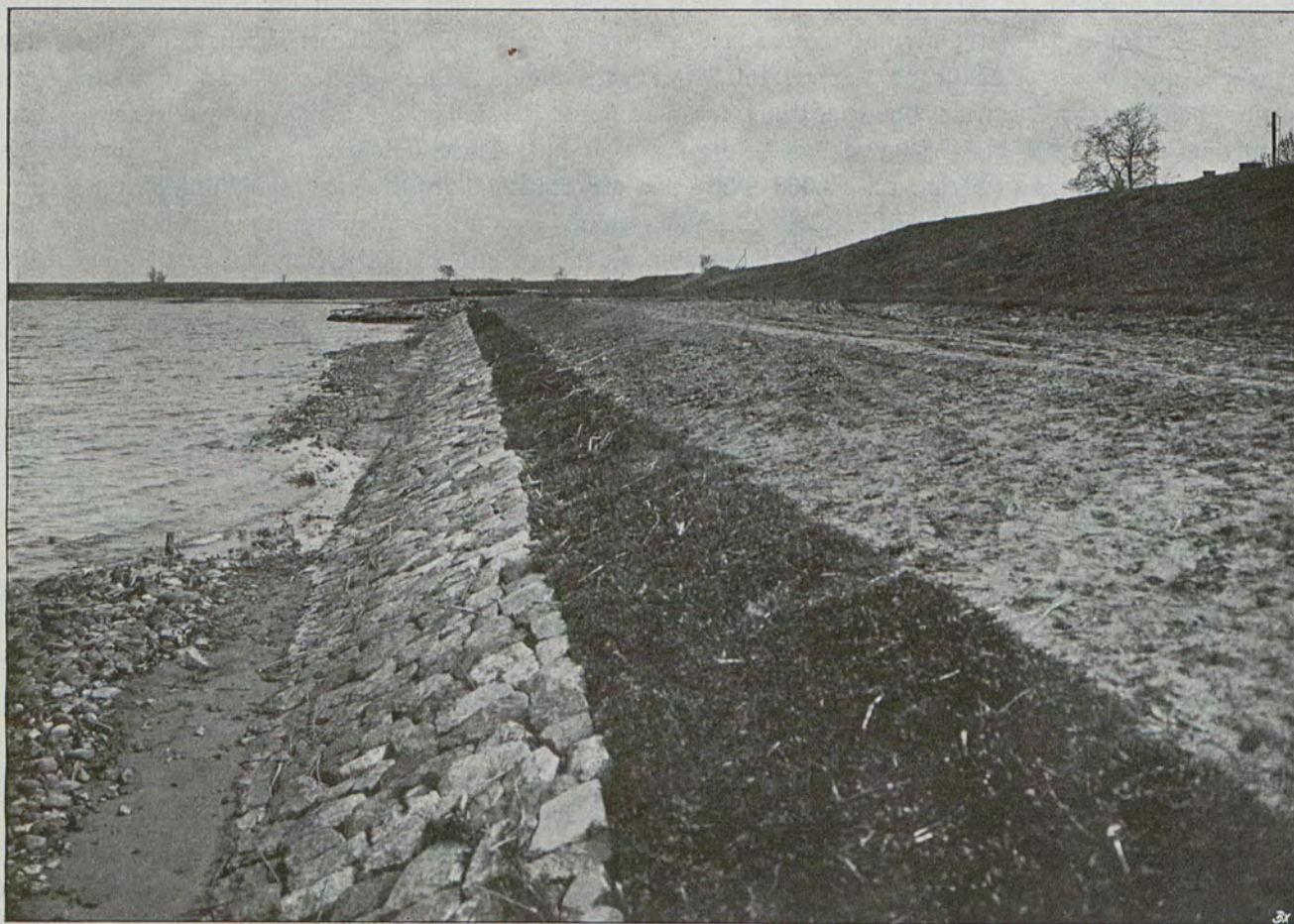
Steindeckwerk am Weichfeldeich oberhalb des Heringskruges (hergestellt im Jahre 1906.)
