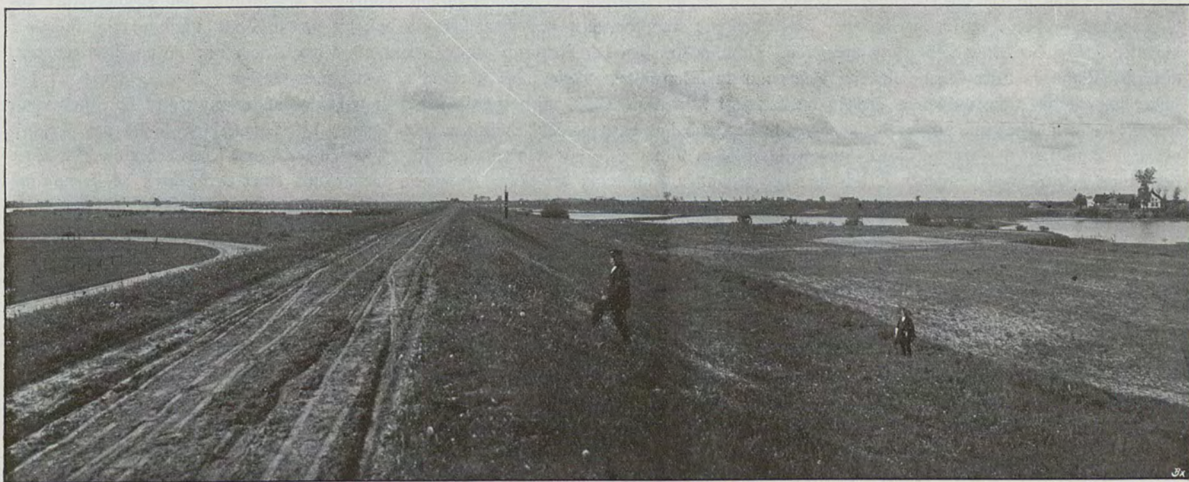
Die Kupierung der Danziger Weichsel bei Siedlersfähre, links die Stromweichsel, rechts im Hintergrunde der durch die Kupierung in Schlaf gelegte alte Weichseldeich, rechts am Rande die Vollenbude.
