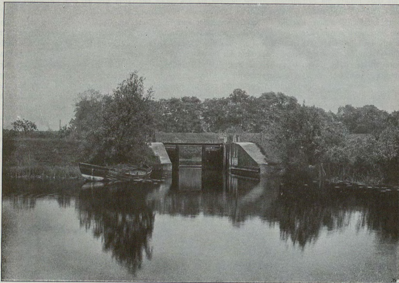
Die Einhornschleuse bei Danzig, die zweite Ausmündung der Mottlau.
