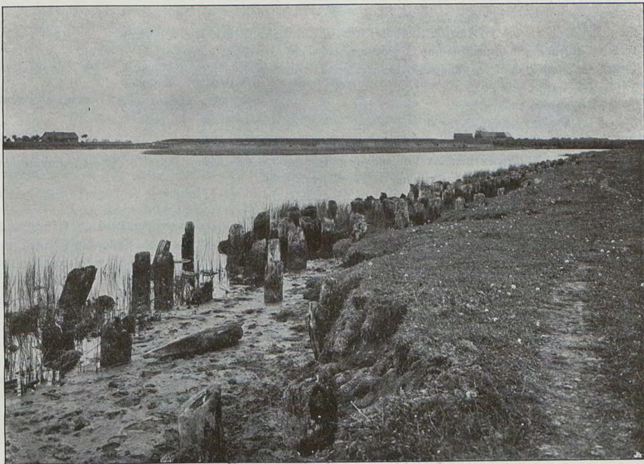
Überreste einer alten „Futterung“ an der jetzigen toten Weichsel oberhalb des Schusterkruges. (Der Deich, welchen die Futterung stützte, ist im Jahre 1871 (?) weiter landeinwärts verlegt worden.)
