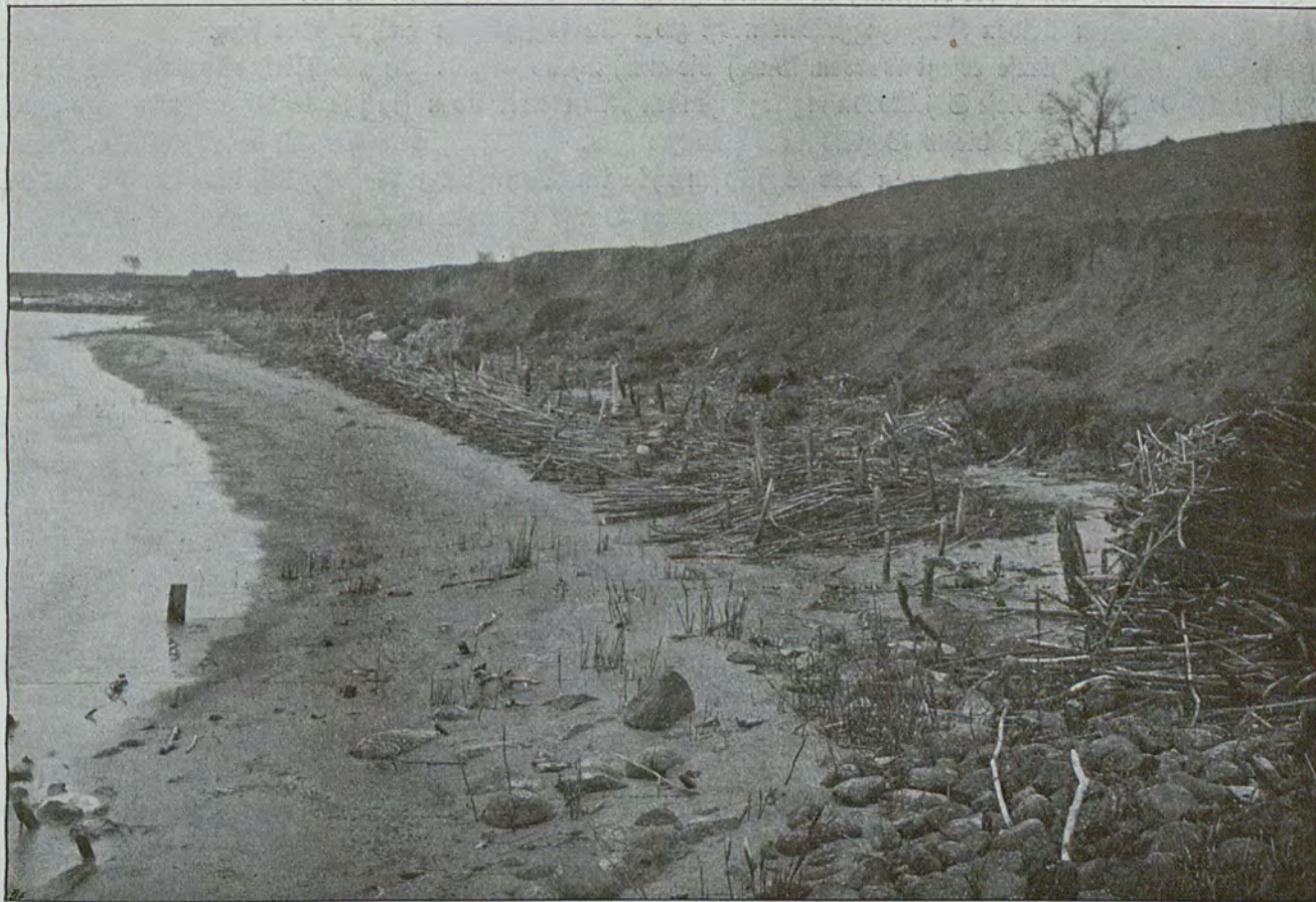
Deichbeschädigung am Heringskrug im Jahre 1905.
