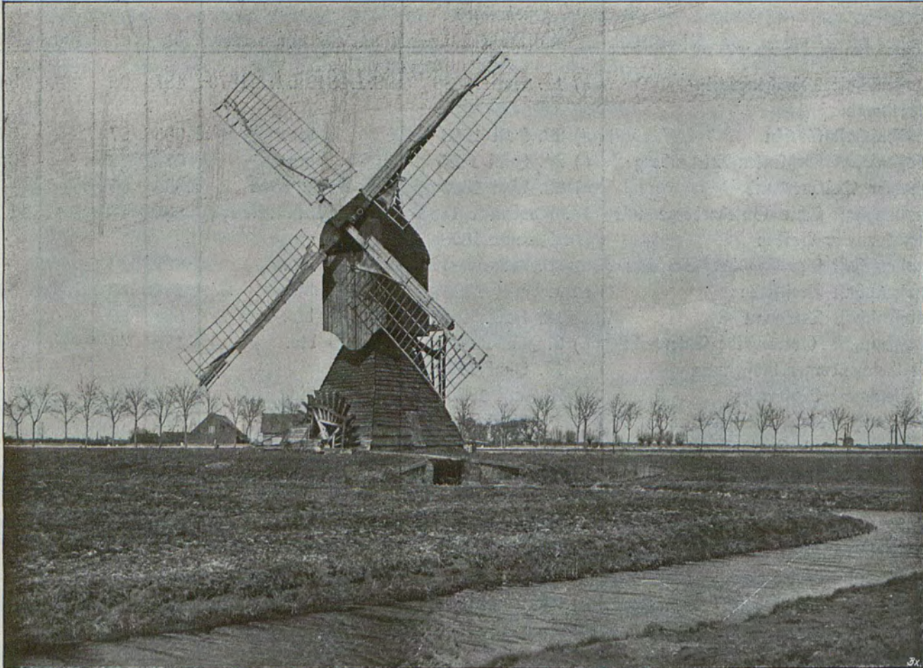
Altes Windschöpfwerk in Neuendorf.
