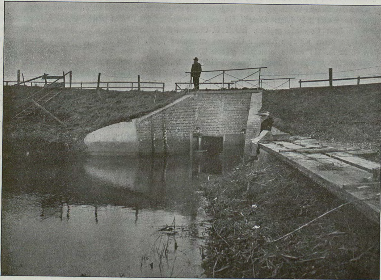
Das in den Jahren 1902/03 für die Neue Binnenehrung neu erbaute massive Deichsiegel bei Bohnsack.
