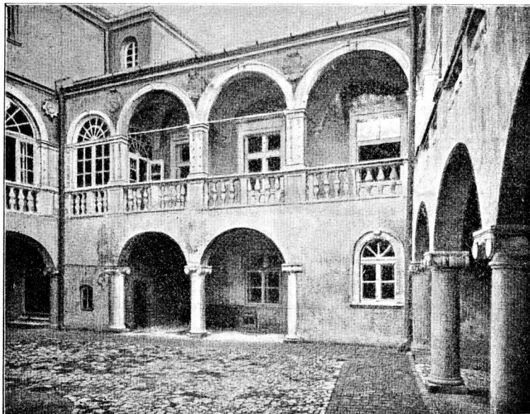
Fig. 190. Podwórze domu przy ulicy Kanoniczej.
