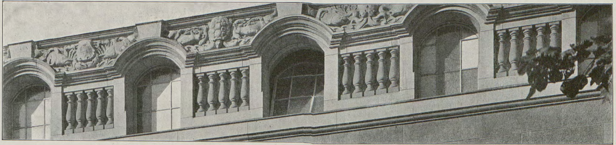
Abb. 39. (Fassadenfries. Fenster der Badezellen.)
