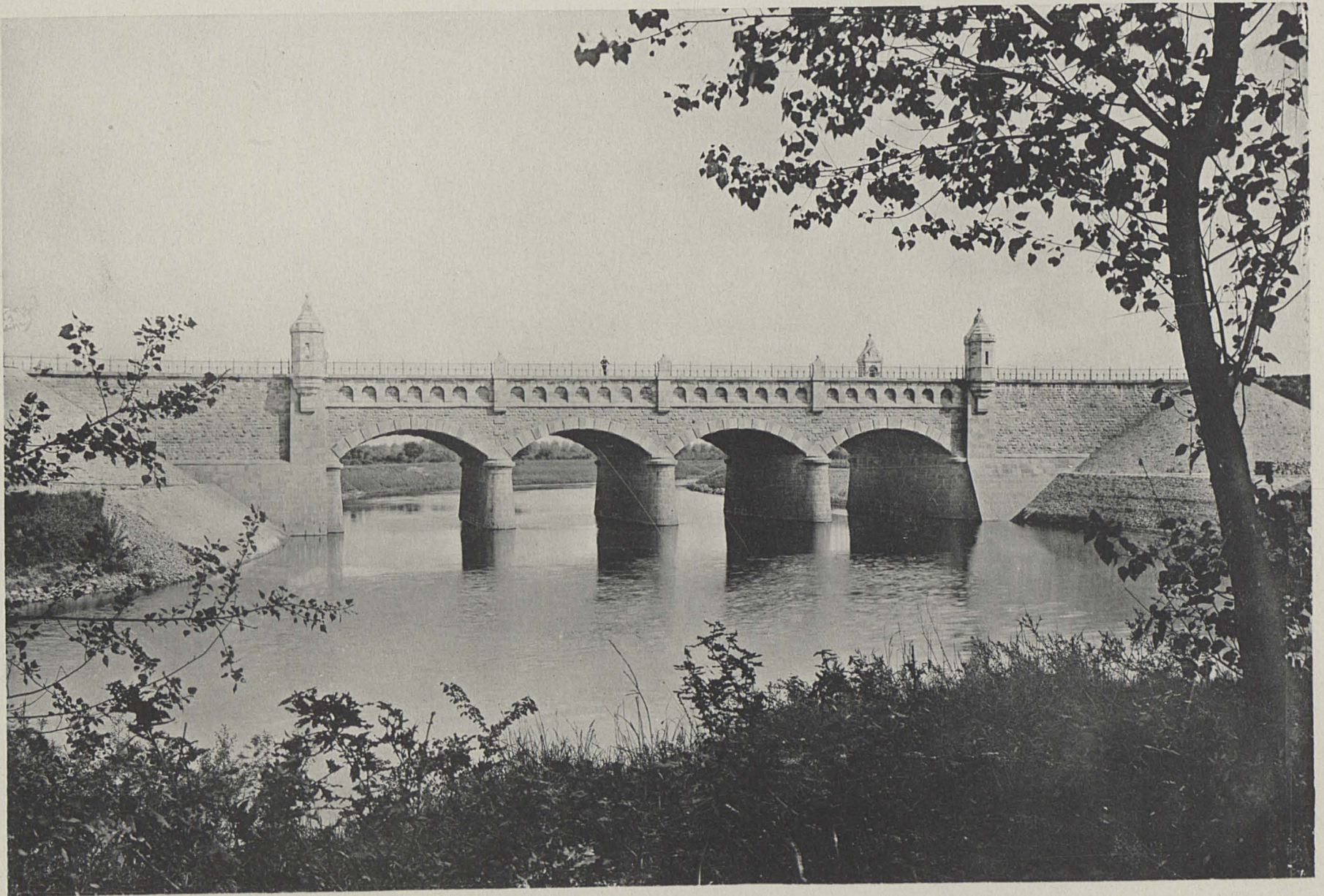
Abb. 2. Brücken canal über die Ems.
