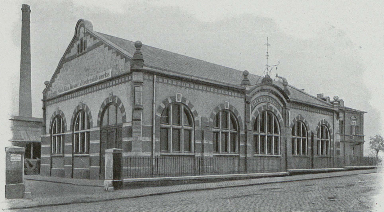
USINE CENTRALE DE ST. JOHANN-SAARBRÜCKEN.
