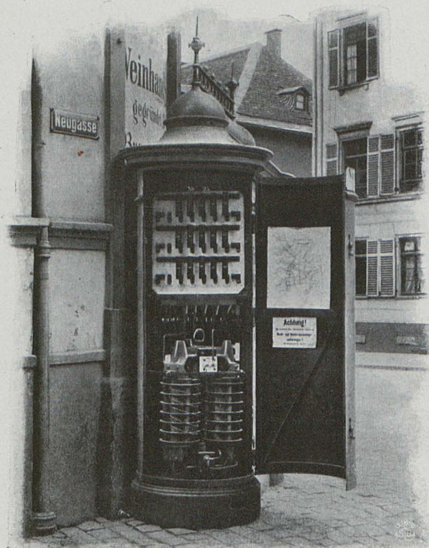
WIESBADEN TRANSFORMATEUR AVEC GUÉRITE.
