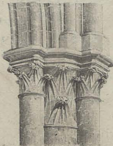
Chapiteaux des grosses Piles
