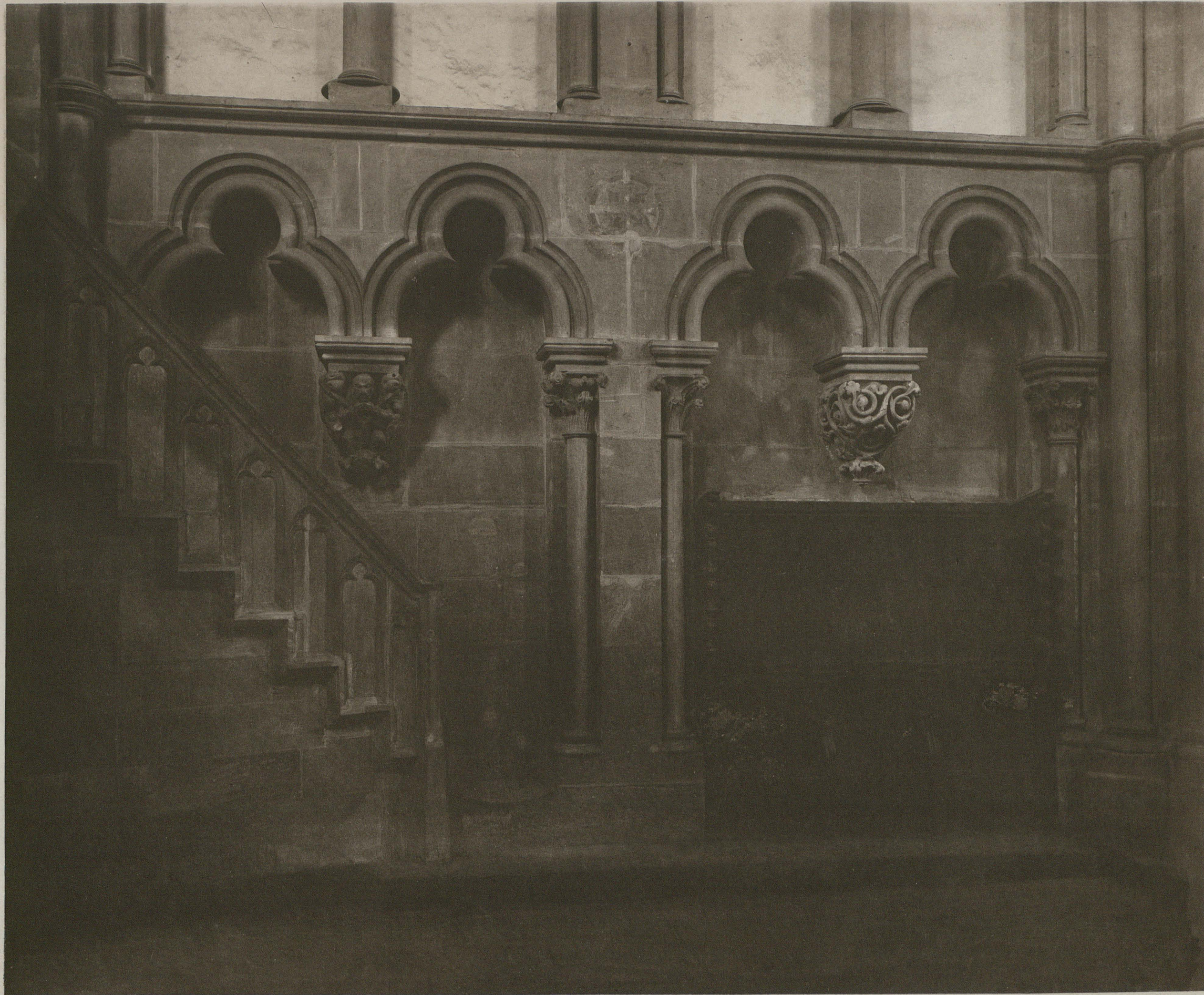
GELNHAUSEN — PFARRKIRCHE ST. MARIA, ERBAUT 1230—1260 — BLENDNISCHEN IN DER NORDWAND DES CHORS — UNTERER TEIL.
