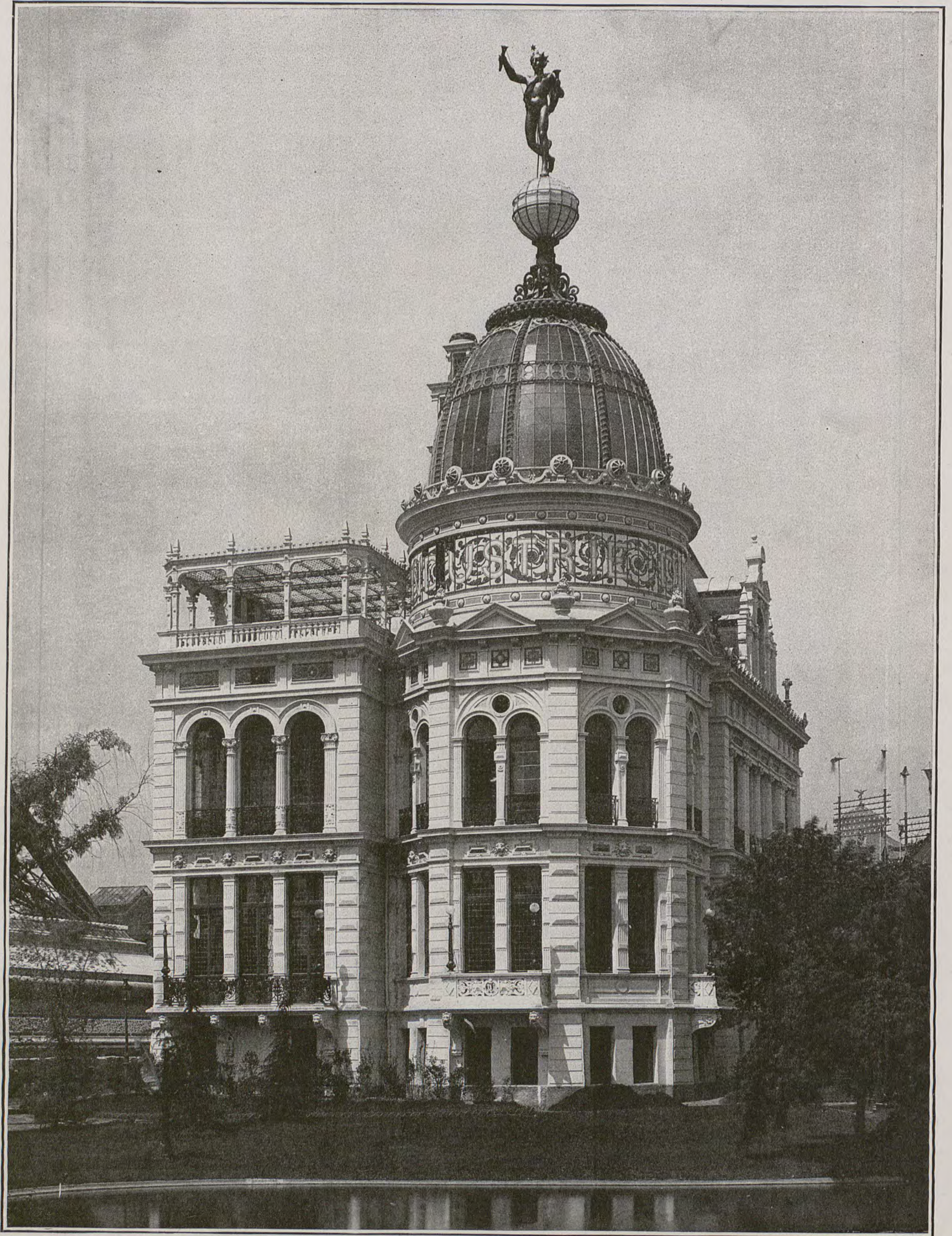
LE PAVILLON DE LA COMPAGNIE DU GAZ.
