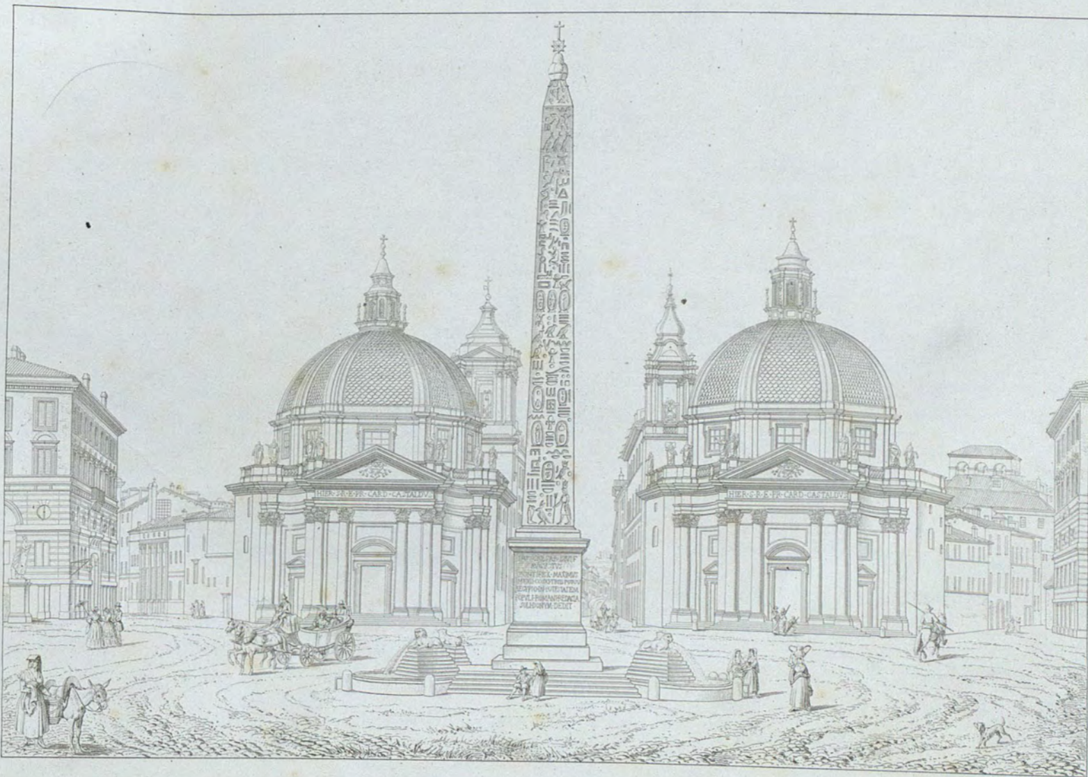
VUE DE LA PLACE DEL POPOLO ET DES DEUX ÉGLISES S.M. DI MONTE SANTO ET S.M. DE MIRACOLI. IV. 5.
