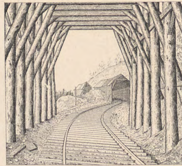
Vue d'ensemble près de Cisco.
