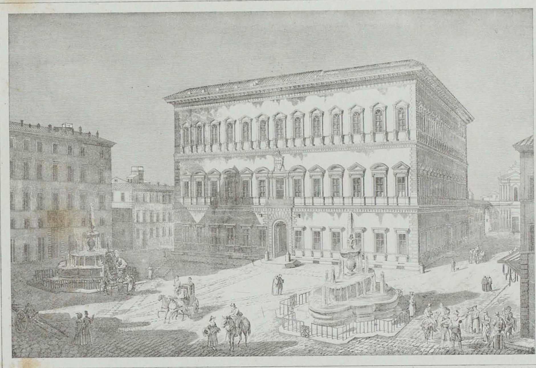
Vue générale de la Place et du Palais
