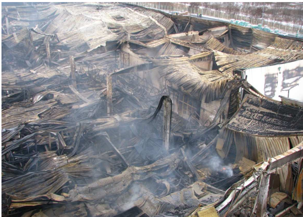
Rys. 10.2 Zniszczenie w sposób totalny po pożarze podstawowego ramowego ustroju nośnego hali stalowej galerii handlowej (na podstawie [Biczyski A. et al., 2012], fotografia A. Biczyski).
