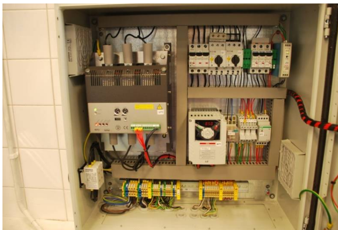
Rys. 4.6. Szafa zasilająco–sterująca.
