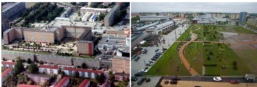
Ryc. 2.49, ryc. 2.50. Kształtowanie przestrzeni publicznych w centralnej części osiedla Neustadt w Hoyerswerdzie w miejscu wyburzonych obiektów; sytuacja przed wyburzeniem 11-piętrowych bloków (po lewej); park powstał w miejscu ich wyburzenia; źródło: < www.hoyerswerdsche.de > [dostęp: styczeń 2017].
