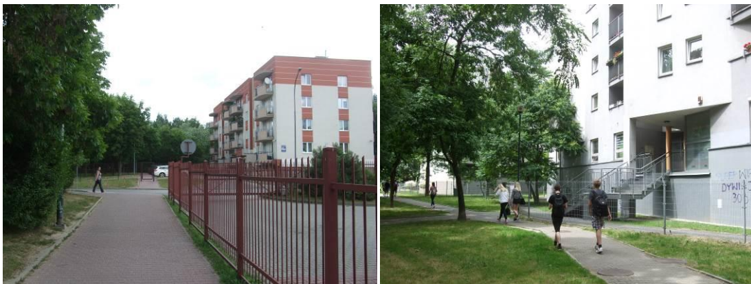
Ryc. 4.31, ryc. 4.32. Ogrodzenia obiektów wielorodzinnych, powodujące fragmentaryzację przestrzeni publicznej między pasem startowym a parkiem gen. Skalskiego; obiekt mieszkalny „wetknięty” między budynek szkoły i przedszkola oraz park, niszcząc czytelność idei placówek oświaty w ścisłym powiązaniu z zielenią (po lewej). Współczesne „dogęszczenia” z ogrodzeniem fragmentaryzujące przestrzeń osiedla (po prawej) (fot. E. Szczerek).
