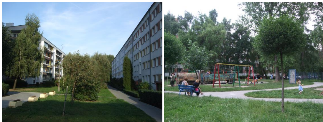
Ryc. 4.18, ryc. 4.19. Kameralne wnętrza pomiędzy liniowym układem zabudowy klatkowej (po lewej); zieleń jako ważny potencjał osiedla Podwawelskiego – tereny zielone wzdłuż ulicy Szwedzkiej (po prawej) (fot. E. Szczerek).
