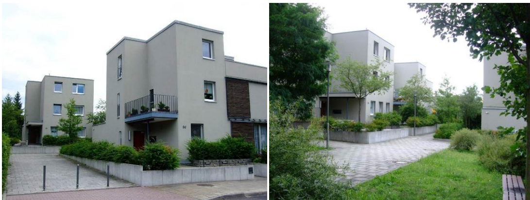
Ryc. 2.61, ryc. 2.62. Stadt Villas w osiedlu Sachsendorf-Madlow w Cottbus – obiekty mieszkalne powstałe z ponownie użytych elementów wielkopłytowych (fot. E. Szczerek, 2012).
