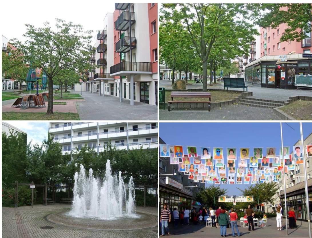
Ryc. 2.81–2.84. Hellersdorfer Promenade – nowa aranżacja przestrzeni publicznej o lokalnym charakterze w osiedlu Hellersdorf (fot. E. Szczerek, 2011, 2016); zdjęcie u dołu przedstawia promenadę podczas trwania imprezy skierowanej do lokalnej społeczności; źródło: Das Berliner Quartiersmanagement, Informationen zum Programm „Soziale Stadt“ , Senatsverwaltung für Stadtentwicklung, Berlin 2010, s. 1.
