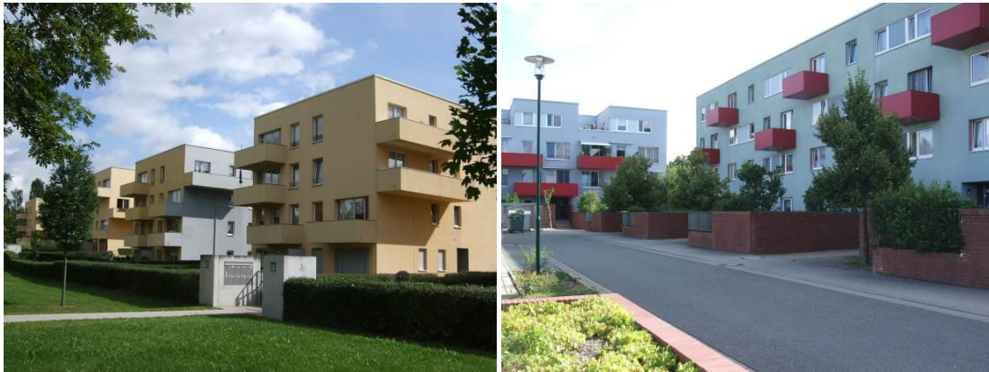
Ryc. 2.57, ryc. 2.58. Nowa forma wielopłytkowych bloków mieszkalnych po eliminacji fragmentów obiektów (fot. E. Szczerek, 2012).
