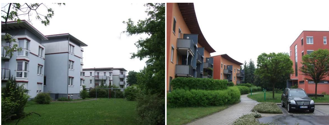
Ryc. 2.47, ryc. 2.48. Nowe obiekty mieszkaniowe powstałe w miejscu wyburzonego obiektu mieszkaniowego (po lewej) i obiektu placówki publicznej (po prawej) w osiedlu Neustadt w Hoyerswerda (fot. E. Szczerek, 2013).
