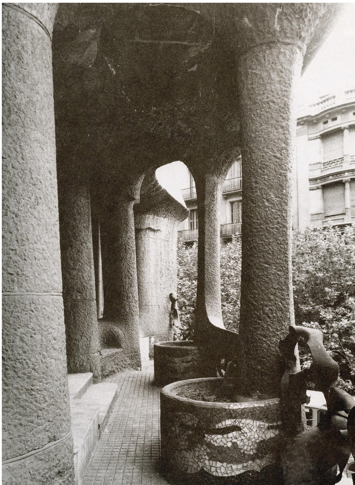
Ilustracja 133 - Wdoczne obniżenie posadzki tarasu w stosunku do poziomu mieszkania oraz donice na rośliny.
