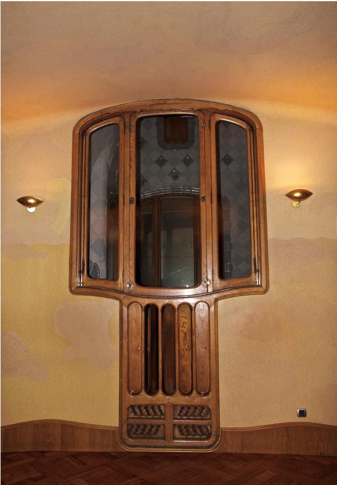
Ilustracja 88 - Większość okiem wychodzących na wewnętrzne patio ma dwu członową konstrukcję, zadaniem części górnej jest dostarczenie światła do pomieszczeń, natomiast dolna część wyposażona została w zmyślny system wentylacji grawitacyjnej.
