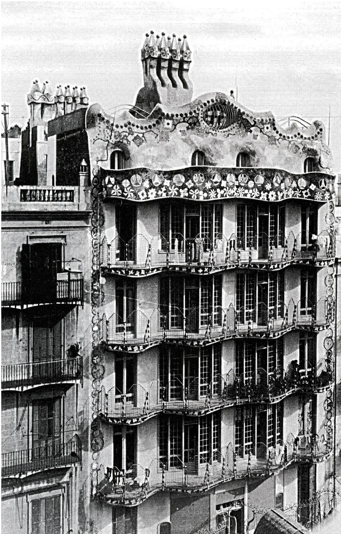
Ilustracja 107 - Cassa Batllo - Elewacja od strony tarasu - w prawym dolnym rogu widoczny fragment salonu ogrodowego (fotografia z początku XX w.)
