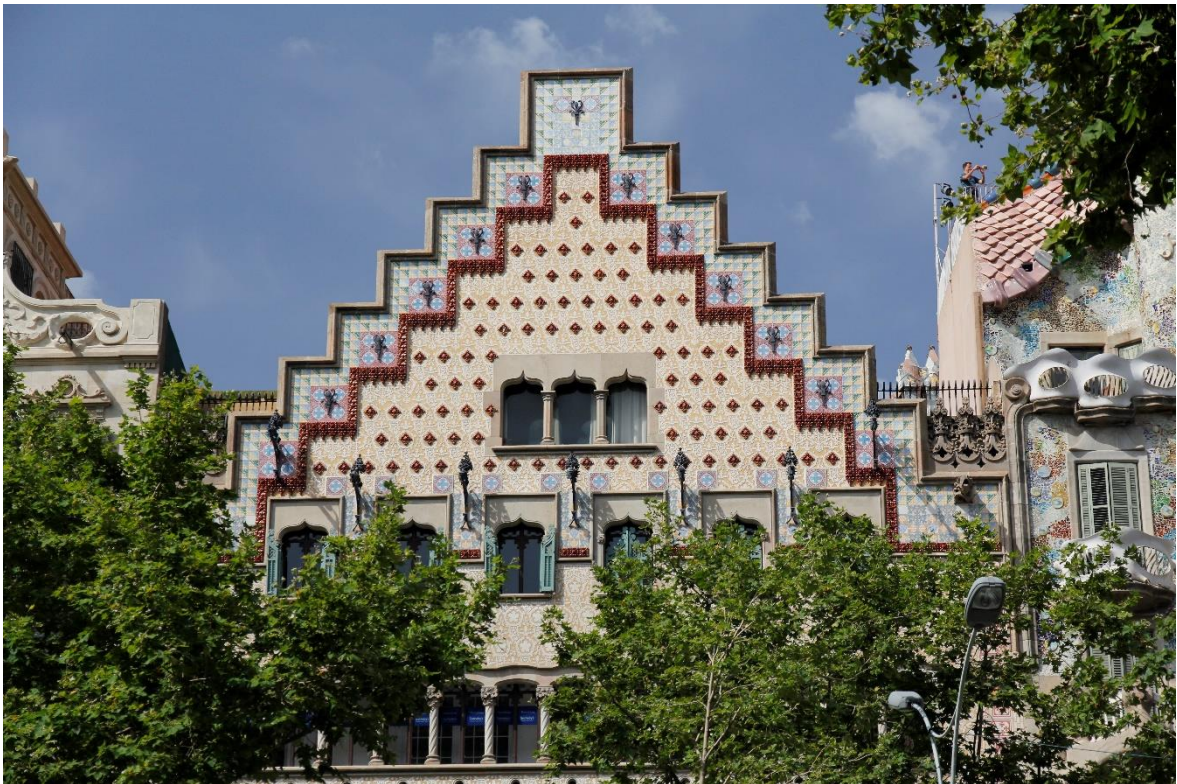
Ilustracja 114 - Casa Amatller z widocznym "wspólnym" elementem elewacji zaprojektowanym przez Gaudiego.
