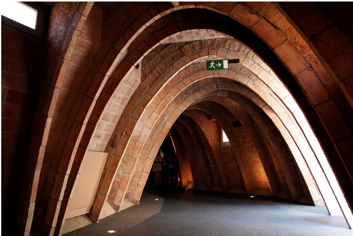
Ilustracja 141 - La Pedrera, ceramiczna konstrukcja struktury poddasza.
