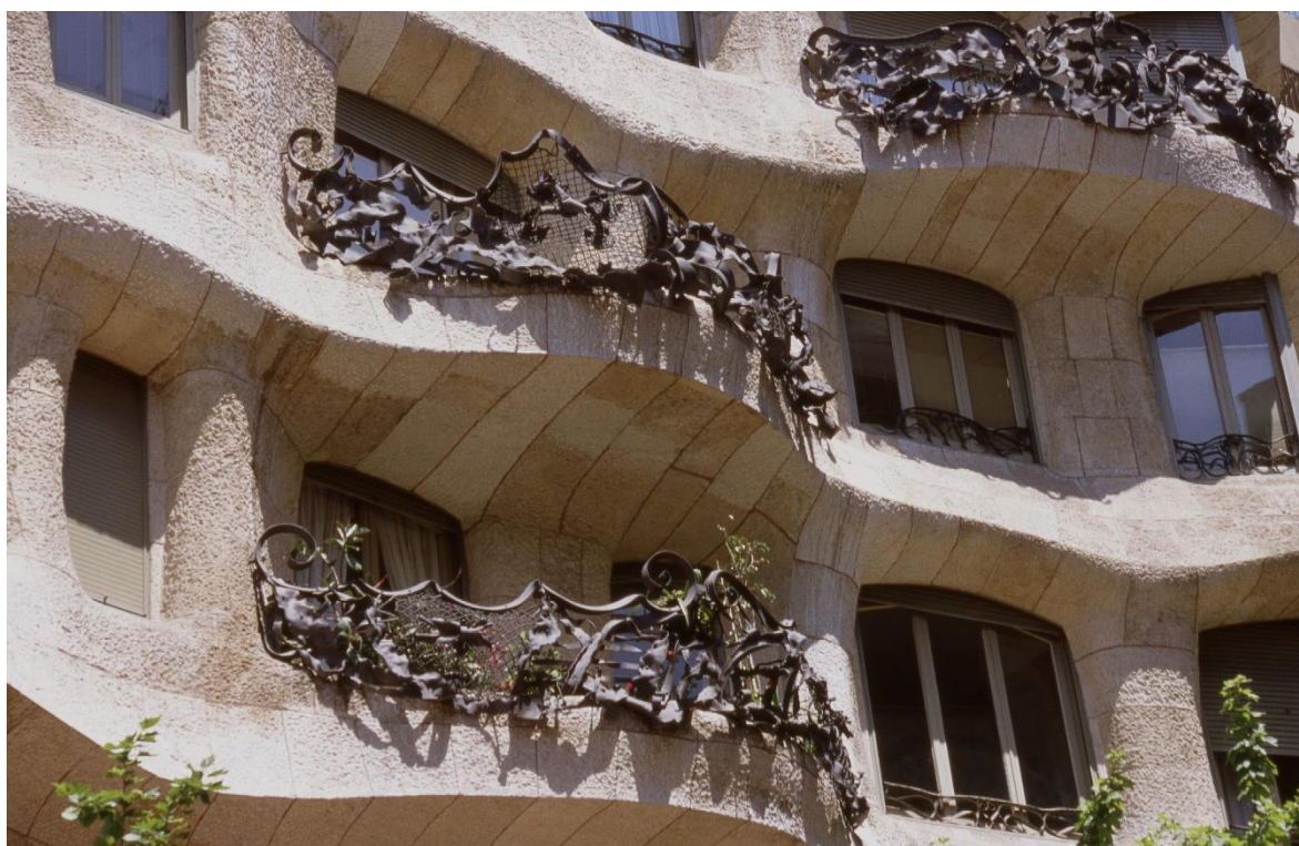
Ilustracja 117 - La Pedrera - fragment elewacji
