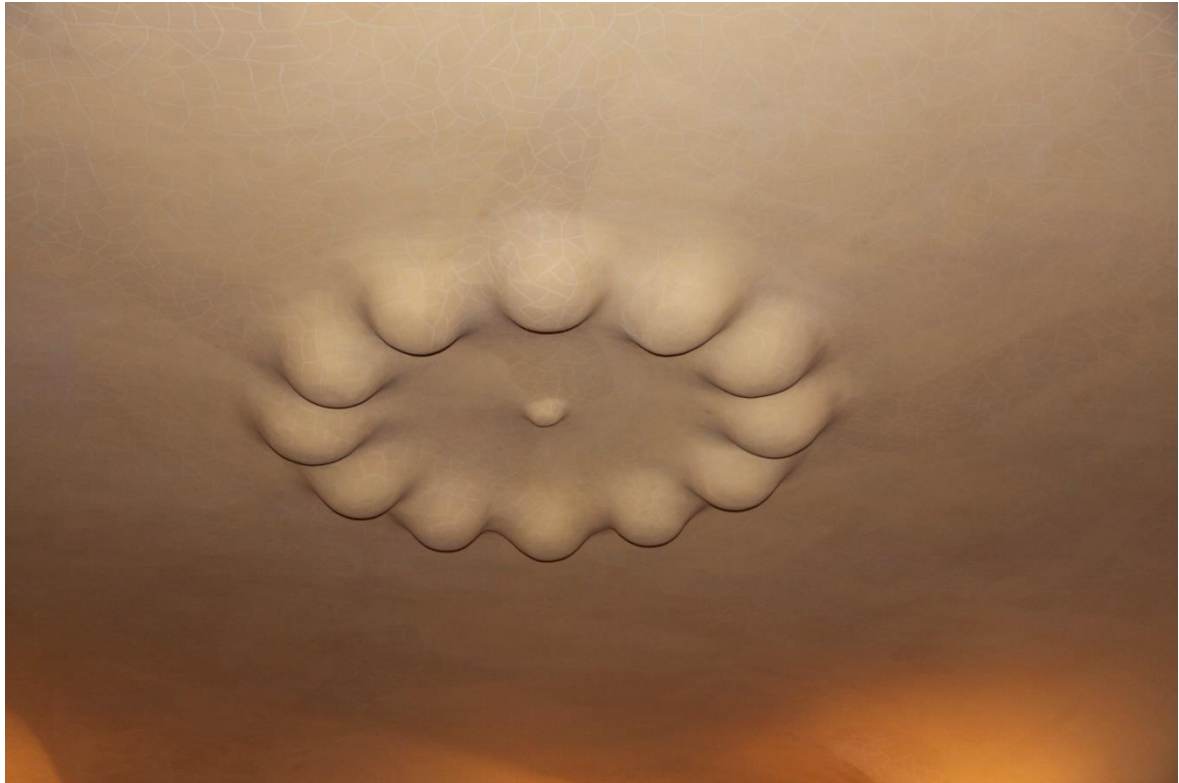
Ilustracja 89 - Fragment gipsowej dekoracji sufitu jednego z pomieszczeń apartamentów rodziny Batllo.
