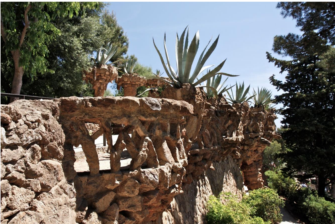
Ilustracja 149, 150, 151, 152 Schody, mury, siedziska, donice na rośliny, struktura wiaduktów oraz inne elementy architektoniczne Parku zostały wykonane z kamienia pozyskanego z miejscowej góry.
