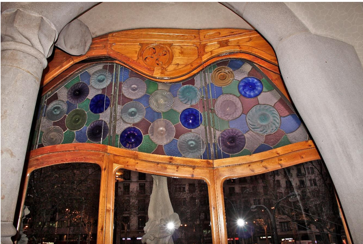
Ilustracja 99 - Drewniana oprawa witraży okien wykusza salonu głównego.
