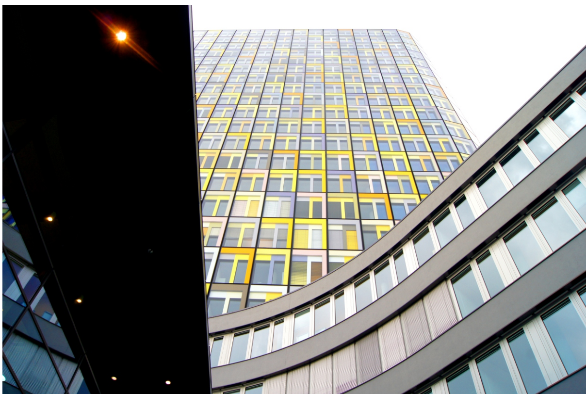
Rys. 22. Przykład podwójnej elewacji. Siedziba główna ADAC, proj. Sauerbruch Hutton Architekten, Monachium 2012. Fot.: Anna Taczalska.
