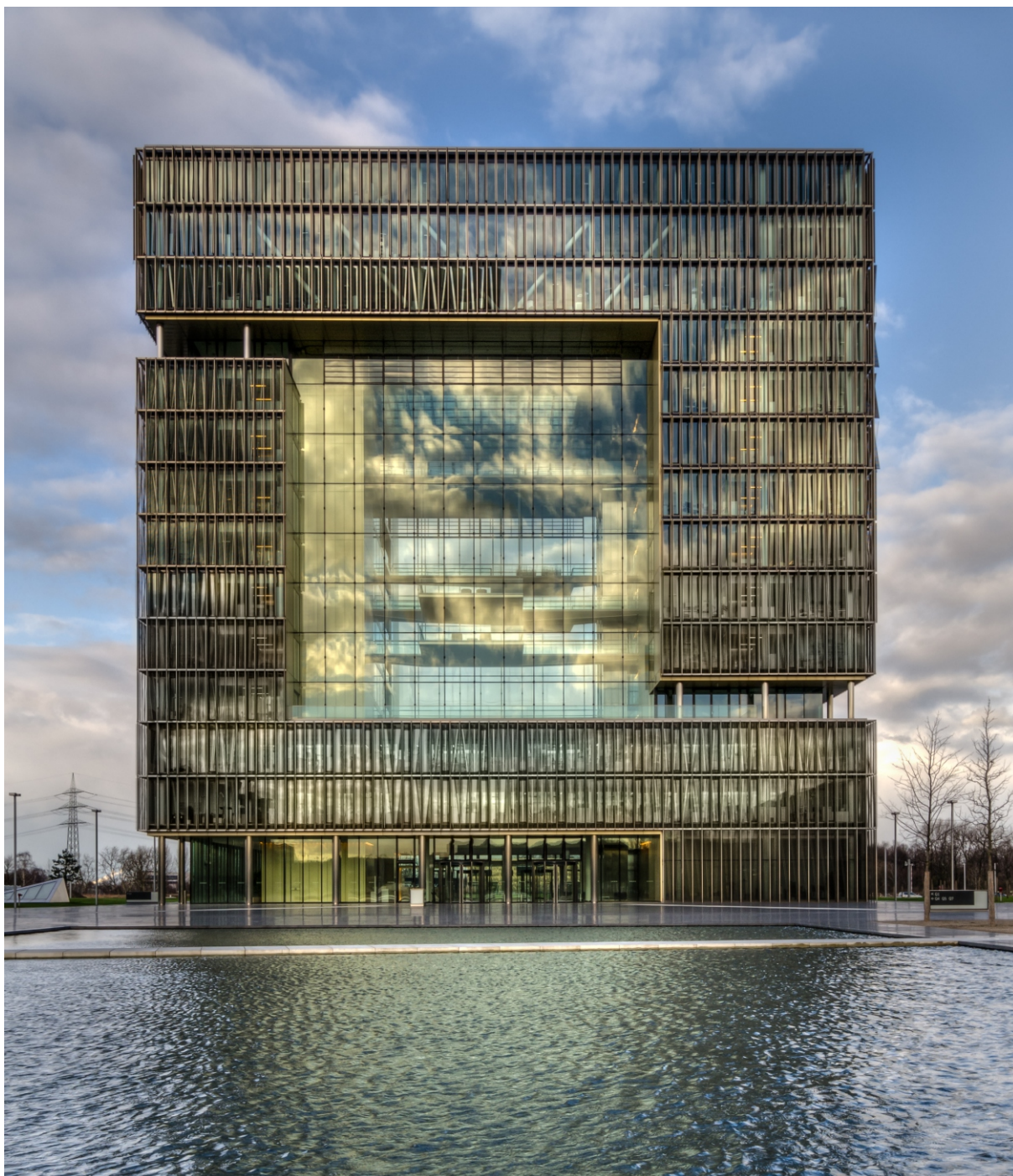
Rys. 24. Przykład zastosowania zewnętrznych, ruchomych, sterowanych automatycznie elementów zacinających elewację. Budynek Q1 kompleksu ThyssenKrupp, proj. JSWD Architekten + Chaix & Morel Associés, Essen 2010. Źródło: en.wikimedia.org/wiki/ThyssenKrupp (dostęp: 03.01.2016 r.).
