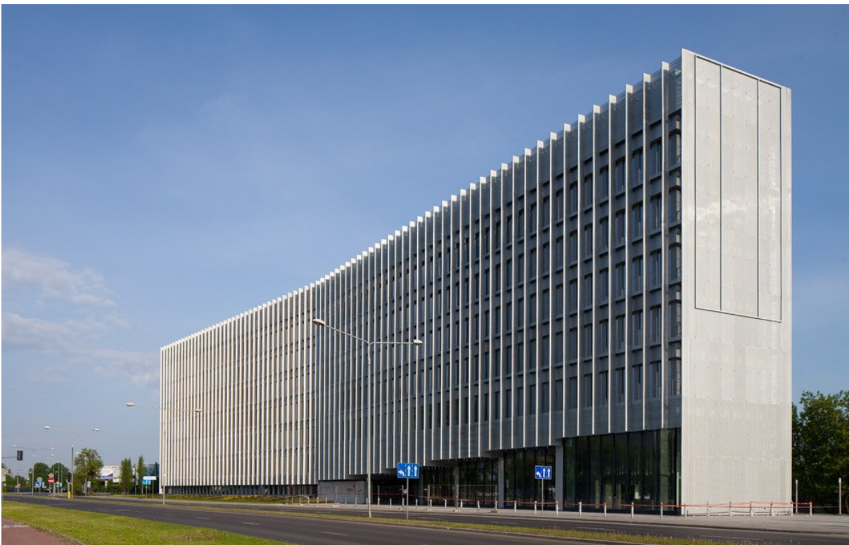
Rys. 24. Przykład zastosowania zewnętrznych, stałych elementów zacinających elewację. Budynek Green Wings, proj. JEMS Architekci, Warszawa 2014. Źródło: www.urbanity.pl/mazowieckie/warszawa/greenwings-offices,b6455 (dostęp: 04.03.2015 r.).
