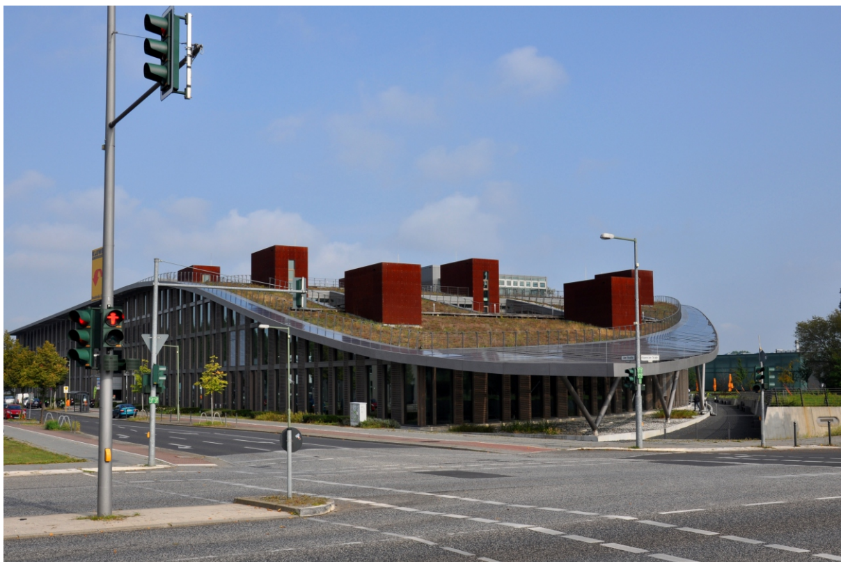
Rys. 21. Przykład zielonego dachu, oraz dodatkowo - montażu paneli fotowoltaicznych na odpowiednio ukształtowanej polaci. Biurowiec firmy SOLON (obecnie na sprzedaż), proj. SFA Schulte-Frohlinde Architekten, Berlin 2009. Fot.: Anna Taczalska.
