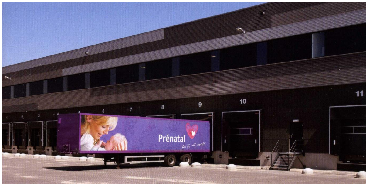
Rys. 2.4 Magazyn o układzie przelotowym – doki centrum dystrybucyjnego w Almere (Holandia) Źródło: [75]
