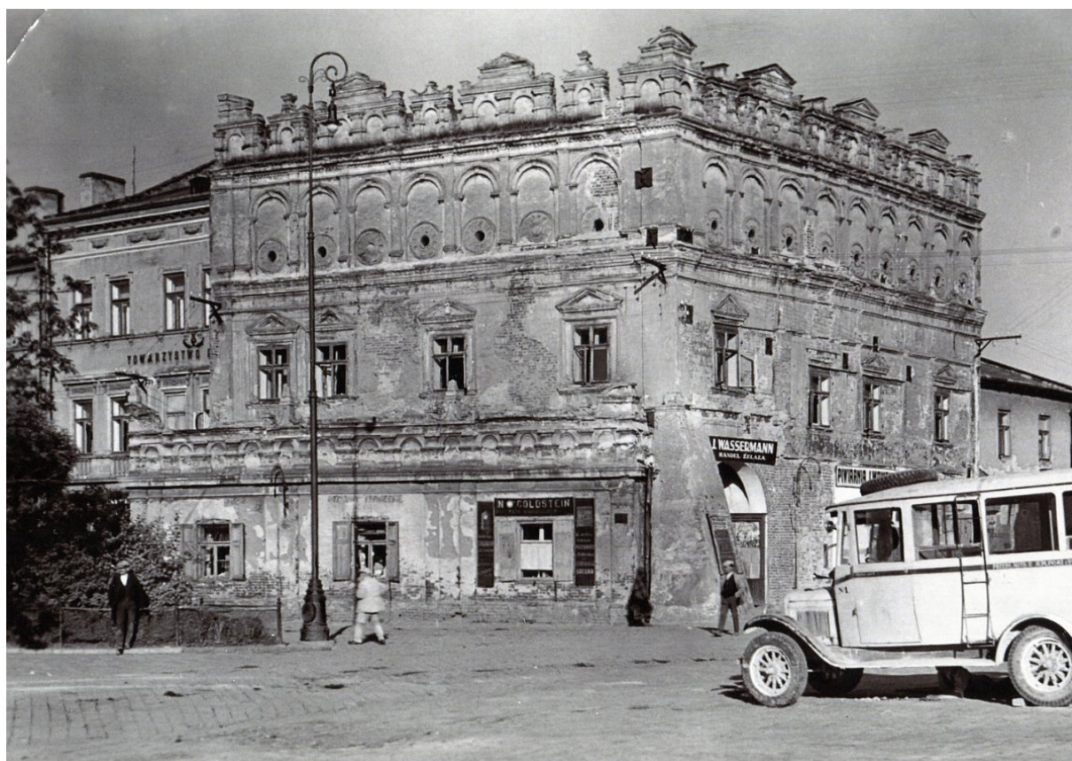
Ryc. 84. Kamienica Orsettich – zdjęcie archiwalne sprzed 1935 roku, widoczne zabudowania podcieni i szyldy sklepowe, źródło: www.fotopolska.eu [dostęp: 2.03.2014].
