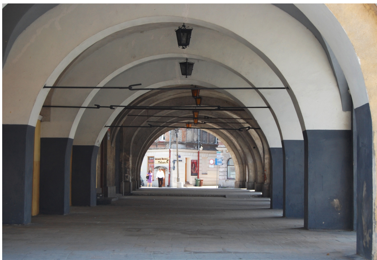
Ryc. 76. Podcienia kamienic w pierzei północno-wschodniej, fot. autorki, 2015.
