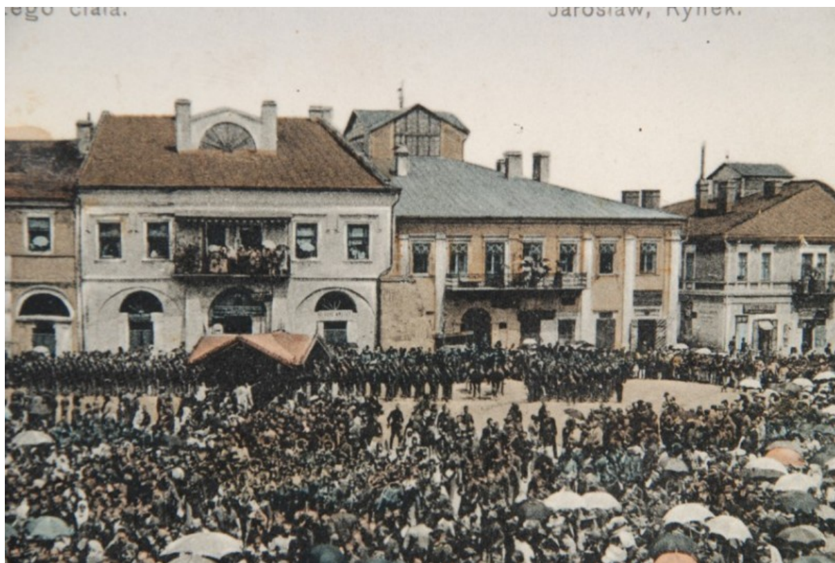
Ryc. 75. Północno-wschodnia pierzeja rynku na archiwalnej pocztówce, widoczne doświetlenia wiat – świetliki, a także zamurowane podcienia części kamienic, źródło: archiwum autorki.
