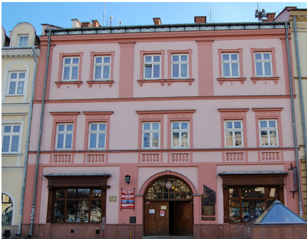
Ryc. 88. Kamienica Gruszewiczów w 2015 roku, fot. autorki.
