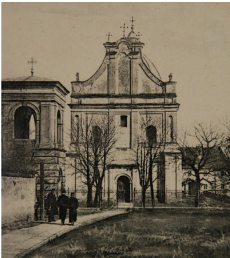
Ryc. 112. Cerkiew pw. Przemienienia Pańskiego – zdjęcie archiwalne przed przebudową, źródło: www.jaroslaw.pl [dostęp: 28.04.2013]
