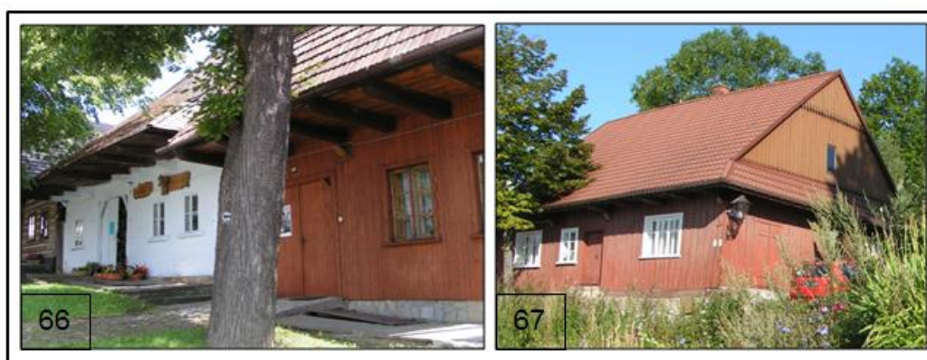
Ryc. 66, 67. Podtrzymywanie tradycji lokalnej poprzez dokonywanie właściwych remontów, fot. A. Mitkowska 2008
