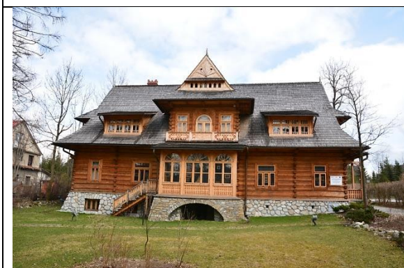
[26] Pensjonat „Oksza”, 1895, przy ul. Zamoyckiego, proj. St. Witkiewicz. Symetria elewacji frontowej i proporcje są odzwierciedleniem formy klasycznej chałupy podhalańskiej. Fot. aut.
