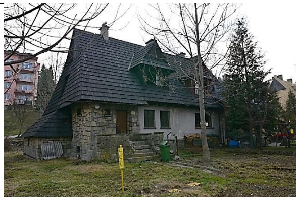
[88] Zespół domów dwurodzinnych, 1950-1953, Przy ul. Jagiellońskiej, proj. A. Górską. Harmo- nijność proporcji i oszczędność detalu. Fot. aut.
