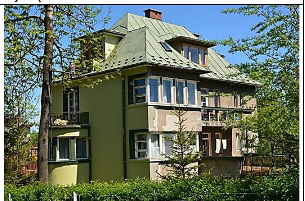
[72] Modernizm międzywojenny w architekturze pensjonatowej występuje również z dachem czterosпадowym, lata 30-te XX w., przy ul. Grunwaldzkiej. Fot. aut.
