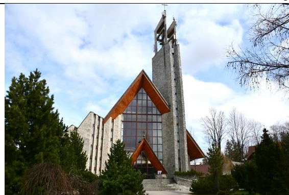
[123] Kościół pw. Świętego Krzyża, 1983-1991, przy ul. Zamoyskiego, proj. Arch. W. Cęćkiewicz. Uhonorowanie idei regionalnych na tle wartości modernizmu. Fot. aut.
