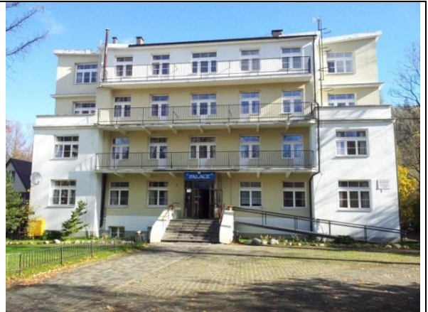
[68] Pensjonat „Palace”, 1930–1932, przy ul. Chałubińskiego, proj. Prot Komornicki. Nowa forma modernistyczna w obszarze poprzednio zdominowanym przez architekturę pensjonatową stylu alpejskiego i zakopiańskiego. Stan obecny. Fot. aut.
