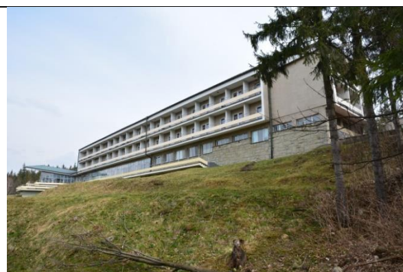
[110] Dom wypoczynkowy „Panorama”, 1965, przy ul. Wierchowej, proj. Jerzy Dajewski. Próba ograniczenia ingerencji w krajobraz poprzez horyzontalne ukształtowanie obiektu. Fot. aut.
