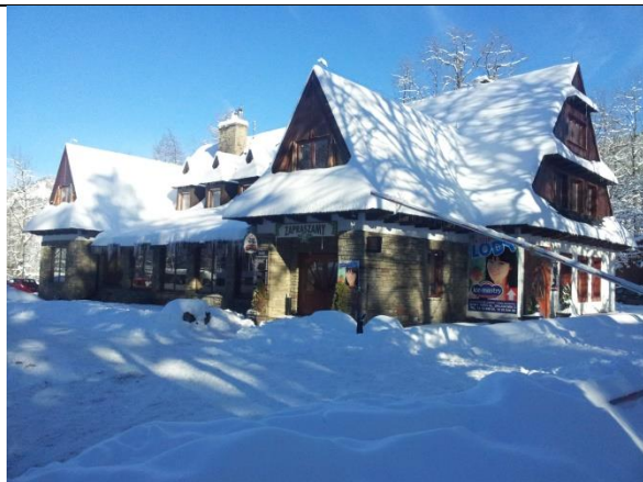
[94] Gospoda w Kuźnicach z częścią pensjonatową, 1956-1958, proj. A. i M. Górscy. Prostota formy nawiązująca do schronisk górskich w połączeniu z modułowością modernizmu. Stan obecny. Fot. aut.
