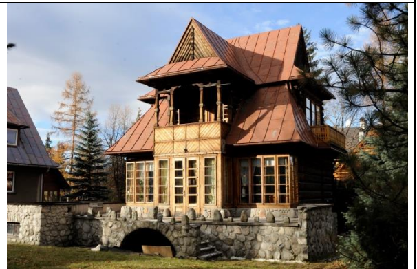
[56] Willa „Kwiat Paproci”, 1936, na Parcelach Urzędniczych przy ul. Sabały, proj. F. Kopkowicz. Geometryczne motywy art. déco, m.in. w szczytach dachu i na balustradach. Fot. z archiwum Z. Moździerza.
