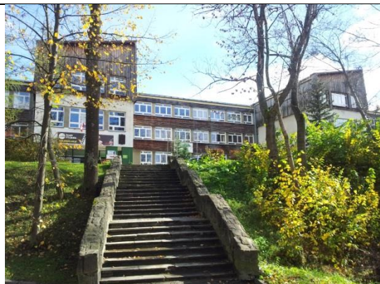
[120] Zespół Szkół Zawodowych im. H. Modrzejewskiej, 1975–1982, przy ul. Kasprusie, proj. A. Górski. Modernistyczne ukształtowanie prostopadłościennych brył, pasy okien, powtarzalność – nawiązanie do charakteru miejsca stanowią drewniane okładziny ścian. Fot. aut.
