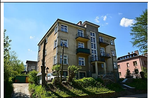
[71] Kamienica Kubicy, modernizm międzywojenny, pensjonat z lat 30-tych XX w., przy ul. Orkana, proj. P. Komornicki. Fot. aut.
