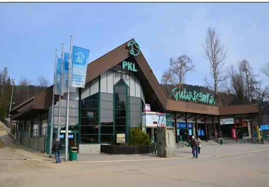
[136] Stacja dolna kolejki na Gubałówkę, 1996-1997, proj. Z. Remi, T. Gluziński. Współczesny obiekt w nurcie późnego modernizmu zastąpił przedwojenną stację dolną reprezentującą „wolny funkcjonalizm”. Fot. aut.
