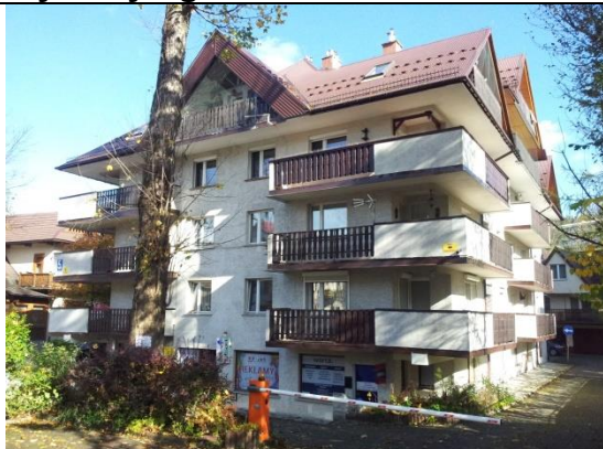
[134] Budynek mieszkalno – usługowy, 1994–1995, ul. Chałubińskiego, proj. K. Kielb. Długo oczekiwana rzeczywistość wolnego rynku kreuje nową formę obiektów apartamentowych. Fot. aut.
