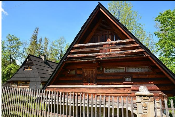
[97] Domki wakacyjne, 2 połowa lat 60-tych, przy ul. Droga do Daniela, proj. St. Karpieł. Prosta kształtowania formy, uproszczony detal wynikający ze struktury drewna. Fot. aut.
