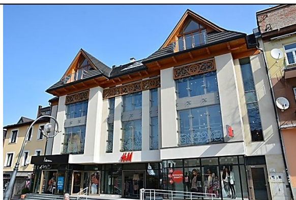
[157] Budynek handlowy, 2009-2010, przy ul. Krupówki, proj. T. Trojan-Korn, P. Szlachtowski, S. Szatko. Regionalny dach półszczytowy i współczesna technologia ściany – współczesna interpretacja stylu zakopiańskiego „w murze”. Fot. aut.
