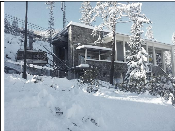
[75] Stacja dolna – stan obecny. Fot. aut.
