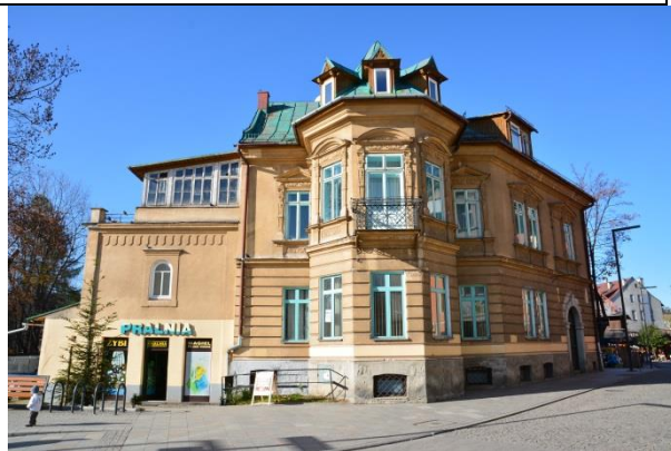
[47] Hotel-pensjon „Warszawski” (obecnie „Kresy”), 1907, proj. nieustalony. Jeden z nielicznych obiektów tego nurtu o przeznaczeniu wyłącznie pensjonatowym. Fot. aut.
