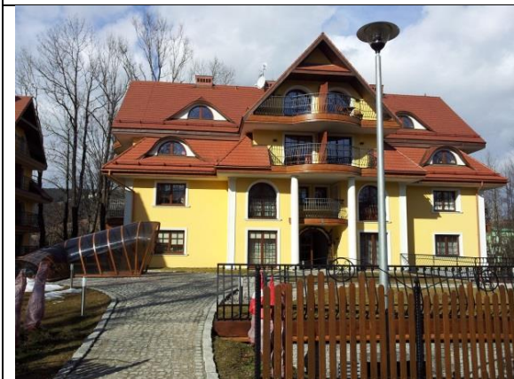
[154] Zespół pensjonatowo-apartamentowy, 2011–2013, przy ul. Sienkiewicza, proj. K. Kielb. Postmodernistyczna kompilacja motywów eklektycznych. Fot. aut.
