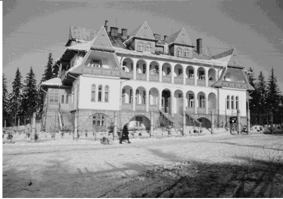
[51] Pensjonat „Cieszynianka”, 1922, przy ul. Droga do Białego, proj. Z. Nosek. Odzwierciedlenie przenikania motywów stylu zakopiańskiego, historyzmu i modernizmu w technologii murowanej. Fot. H. Poddębski ok. 1938. Ze zbiorów Muzeum Tatrzańskiego.
