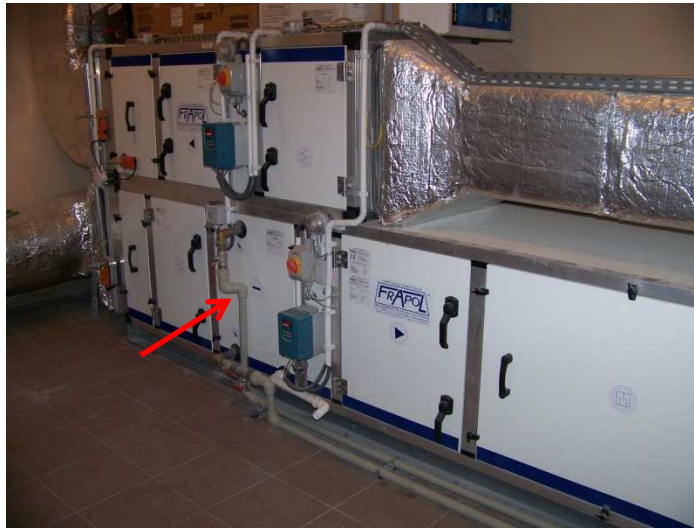
Rys. 3.12. Centrala wentylacyjna nawiewno-wywiewna AF 10/07 Standard
